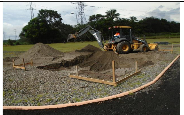
Foto # 2, Inicio de la excavación para la construcción de la segunda base del nuevo transformador T2. S/E Progreso.
