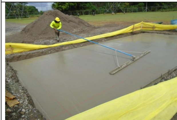
Foto # 3, Acabado final de concreto de Limpieza. S/E Progreso.
