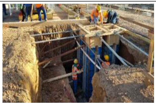
Foto # 2, Encofrado de los pedestales. S/E Llano Sánchez.
