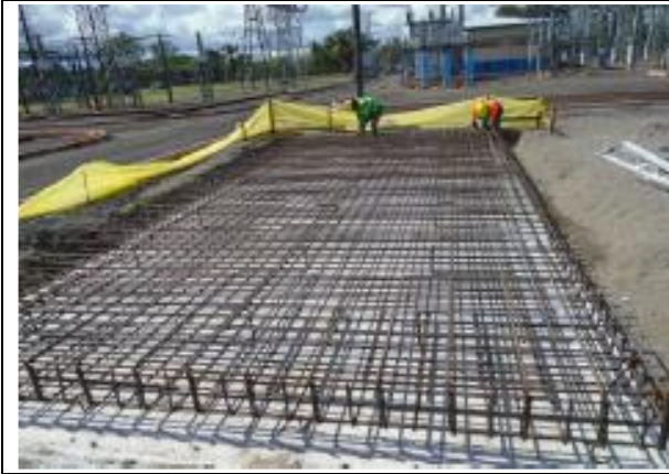
Foto # 1, Colocación del acero. S/E Progreso.
