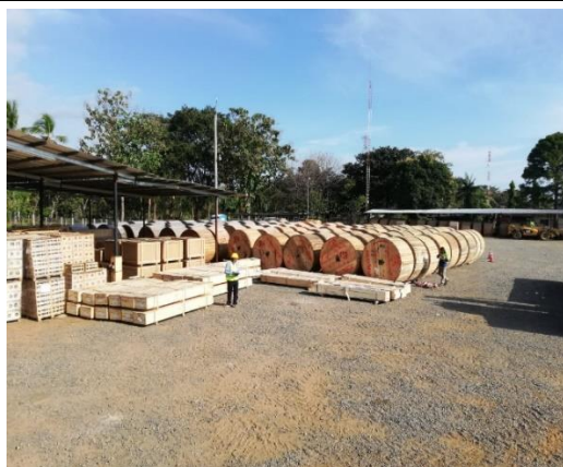
Foto # 3, Los carretes con el ACCC.
