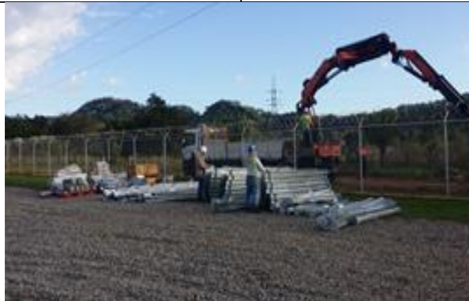
Foto # 3, Descarga de estructuras metálicas en la S/E mata de Nance.
