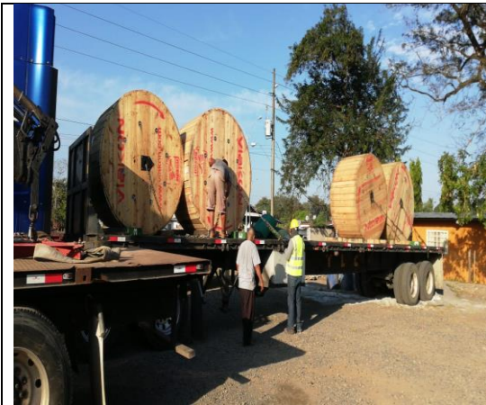
Foto # 1, Descarga de cable ACCC, almacén San Lorenzo.
