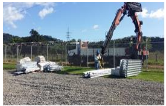
Foto # 2, Descarga de estructuras metálicas en la S/E mata de Nance.
