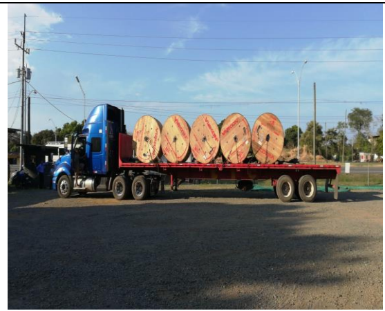
Foto # 2, Descarga de cable ACCC, almacén San Lorenzo.
