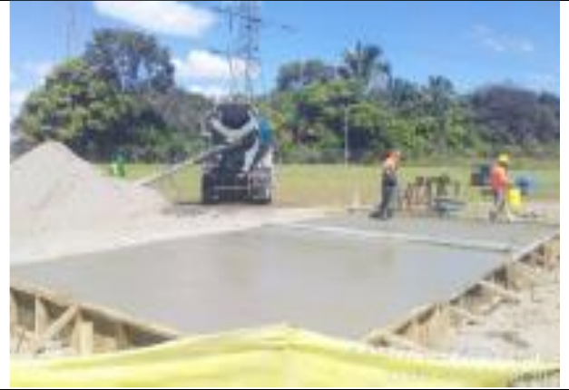
Foto # 2, Vaciado del Concreto. S/E Progreso.
