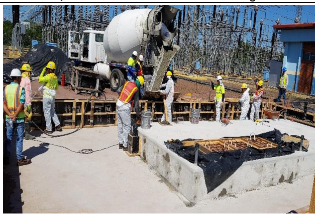
Foto # 4, Vaciado de paredes de la piscina. S/E Llano Sánchez.
