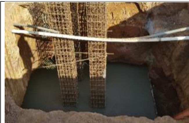
Foto # 1, Vaciado de zapata de la fundación del nuevo pórtico para el T1. S/E Llano Sánchez.
