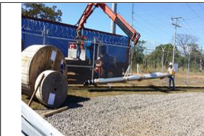
Foto # 1, Suministro de Tubos de Aluminio
