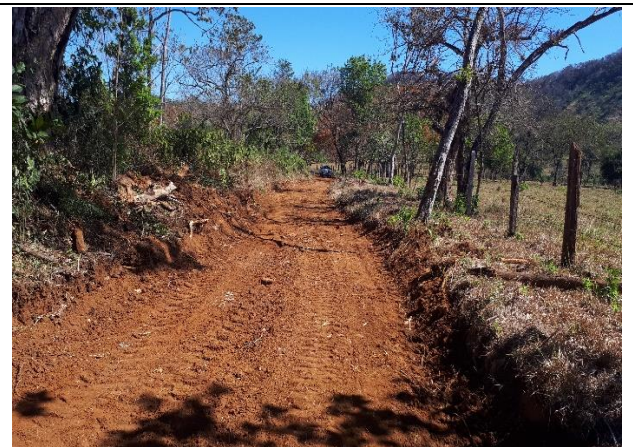
Foto # 6, Adecuación del camino T939 a T933, Mata de Nance.
