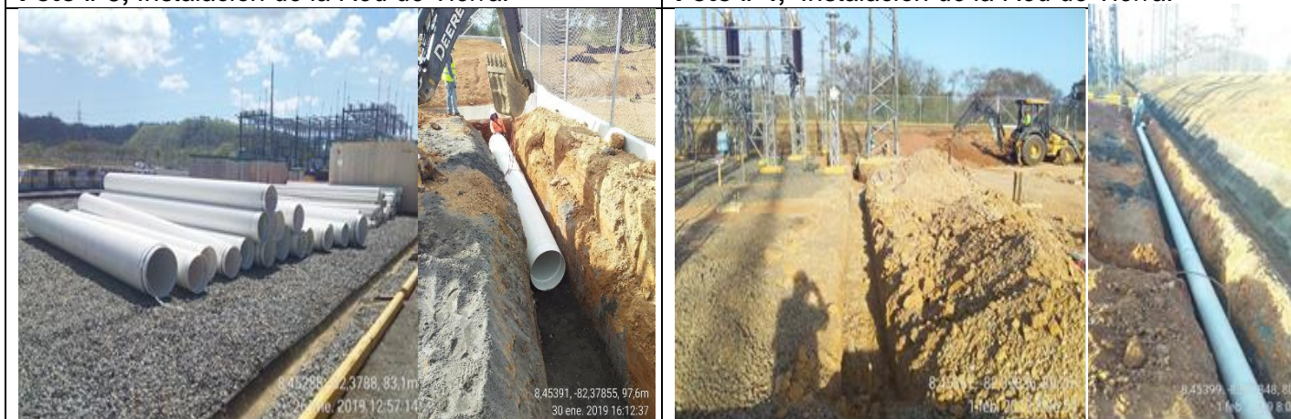
Foto # 5, Construcción del sistema de drenaje.
