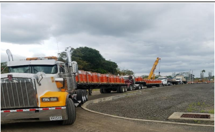
Foto # 4, Llegada de accesorios del transformador T4, S/E Panamá II.
