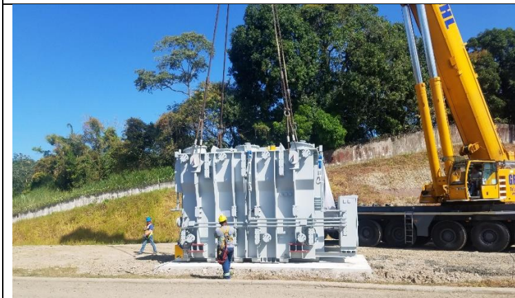
Foto # 3, Colocación de la cuba del transformador T4 en su base temporal, S/E Panamá II.
