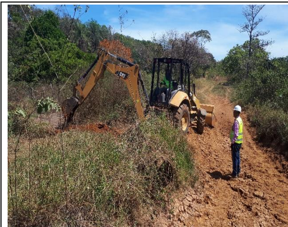
Foto # 5, Adecuación del camino T939 a T933, Mata de Nance.
