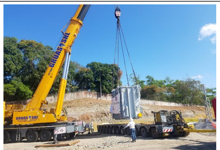
Foto # 2, Descarga de cuba del transformador T4 en S/E Panamá II
