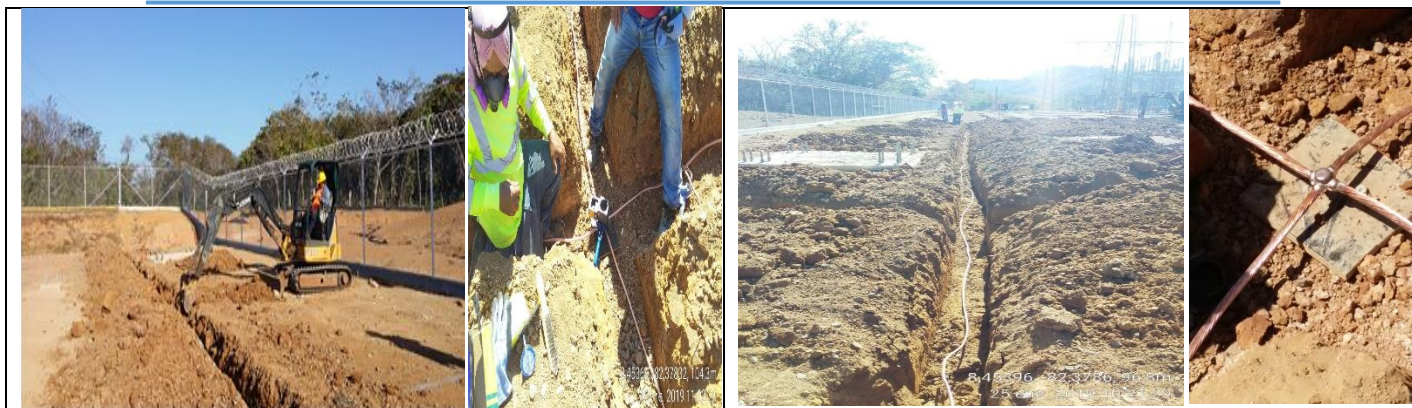
Foto # 3, Instalación de la Red de Tierra.
