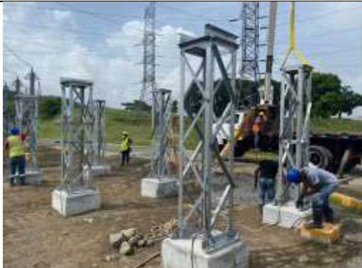
Foto # 9, Trabajos realizados en Subestación Panamá II.
