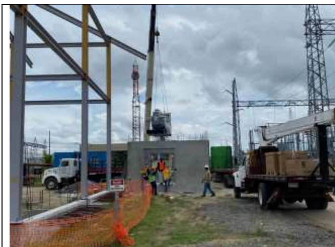
Foto # 1 , Descarga de Generador de Emergencia en S/E Panamá II.
