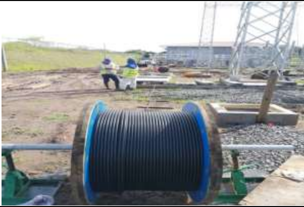
Foto # 3, Trabajos de cableado en Subestación Llano Sánchez.
