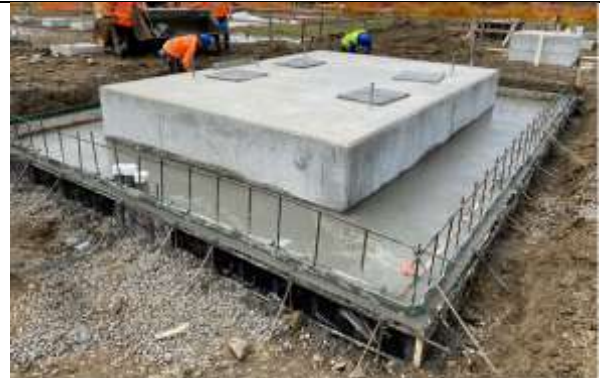
Foto # 10, Trabajos realizados en Subestación Panamá II.
