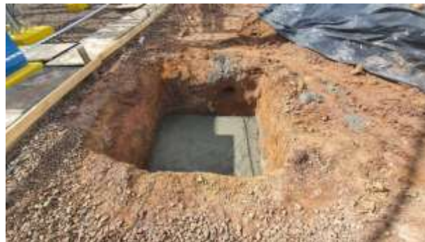
Foto # 2 , Colocación de concreto pobre para la fundación de aisladores de barra de 230 kV en Subestación Llano Sánchez.
