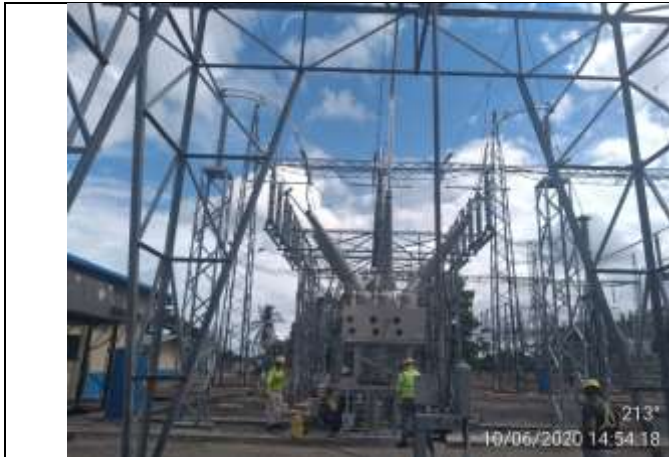
Foto # 3, Montaje del nuevo interruptor 23A22 de la S/E Progreso
