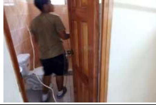
Foto # 2, Remozamiento de baño en el Centro de Salud.
