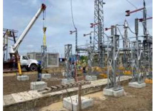
Foto # 8, Trabajos realizados en Subestación Panamá II.
