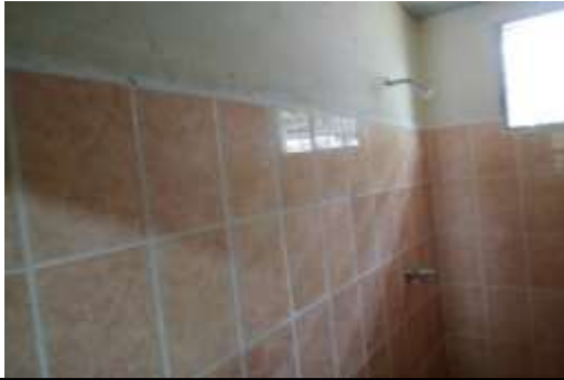
Foto # 1, Remozamiento de baño en el Centro de Salud.
