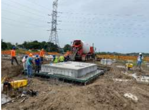
Foto # 7, Trabajos realizados en Subestación Panamá II.
