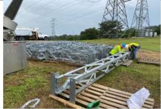
Foto # 6, Trabajos realizados en Subestación Panamá II.
