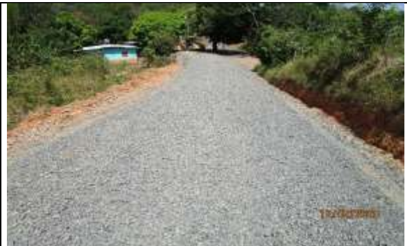
Foto # 2, Construcción de camino de acceso hacia la escuela.
