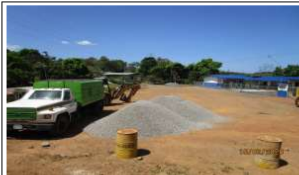
Foto # 1, Construcción de la cancha de fútbol.
