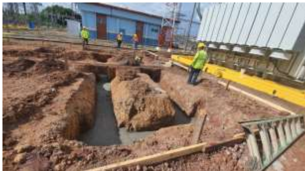
Foto # 1 , Colocación de concreto pobre para la fundación del seccionador de 230 kV en Subestación Llano Sánchez.
