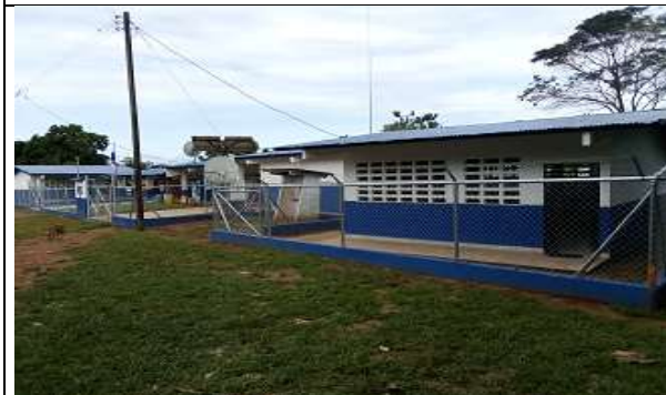
Foto # 3, Remozado de la escuela y cerca de ciclón al 100%
