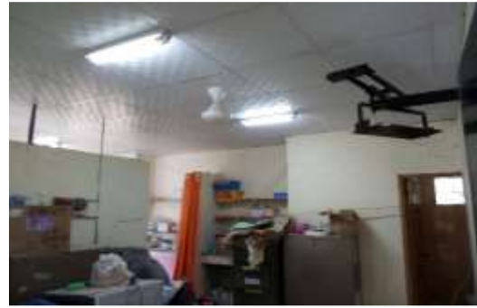
Foto # 4, Rehabilitación de cielo raso en centro de salud de Chichica.
