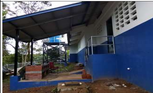
Foto # 4, Torre de tanque de abastecimiento y anexo de fogones en la
