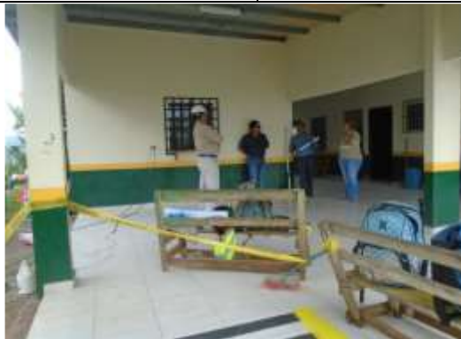
Foto # 5, Área nueva construida en centro de salud de Chichica.
