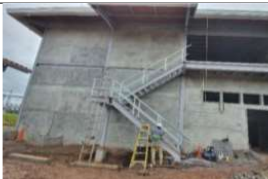
Foto # 2, Instalación y pintura de escalera metálica exterior en Subestación Llano Sánchez.
