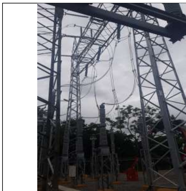
Foto # 1, Instalación de bajantes de línea 230-5B en la S/E Mata de Nance.
