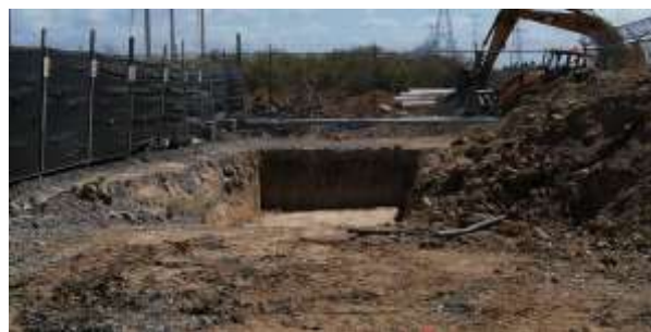
Foto # 2, excavación para Prueba de Placa en área de fundaciones de equipos.
