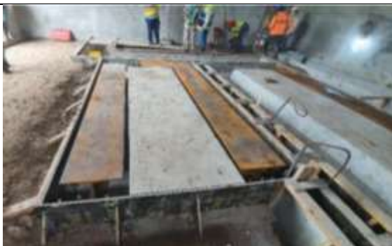
Foto # 1, Colocación de channels en fundación BN-03 (Valve Hall #2) en Subestación Llano Sánchez.
