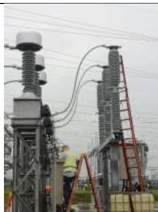
Foto # 4, Instalación de puentes entre interruptores y CTs de 22.2 kV en Subestación Llano Sánchez.
