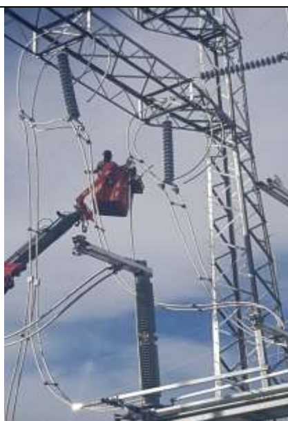
Foto # 2, Instalación de bajantes de línea 230-5B en la S/E Mata de Nance.
