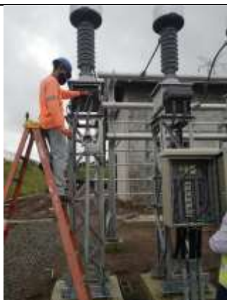
Foto # 3, Instalación de cableado en CTs de 22.2 kV en Subestación Llano Sánchez.
