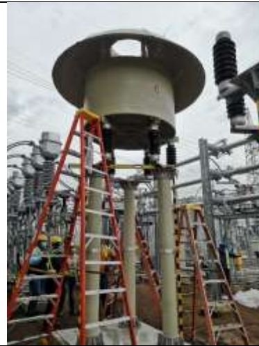
Foto # 4, Instalación de reactor en Subestación Llano Sánchez.
