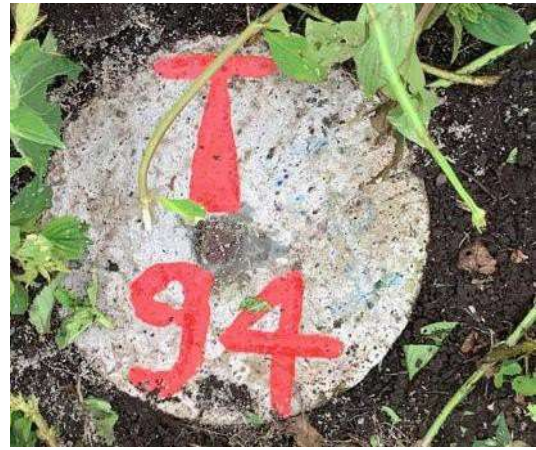
Foto # 4, Monumentación de Estructuras de la torre 94.
