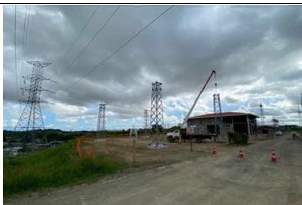
Foto # 7, Montaje de columnas de pórtico en Subestación Panamá II.
