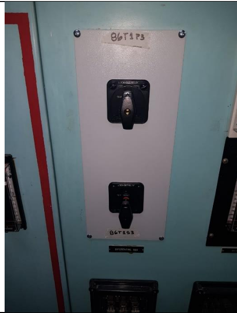
Foto # 2, Instalación de relés 86 BF en Subestación Mata de Nance.
