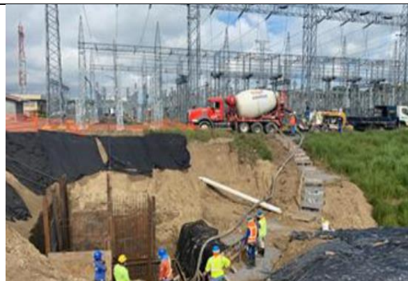
Foto # 8, Vaciado de zapata de poste con bomba estacionaria en Subestación Panamá II.
