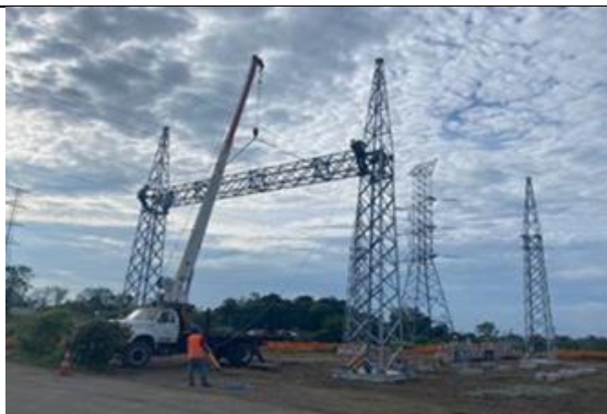
Foto # 9, Montaje de viga de pórtico en Subestación Panamá II.
