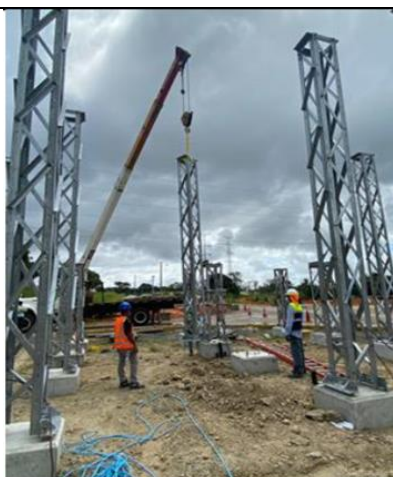
Foto # 5, Instalación de 5 estructuras de cuchillas motorizadas en Subestación Panamá II.
