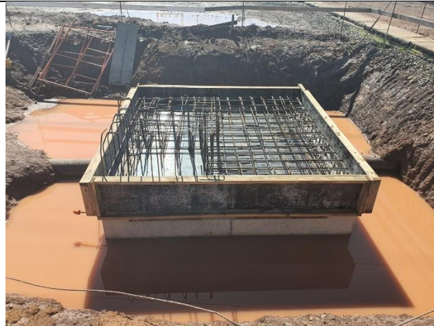
Foto # 2, Actividades civiles del Autotransformador T2 en Subestación Panamá.
