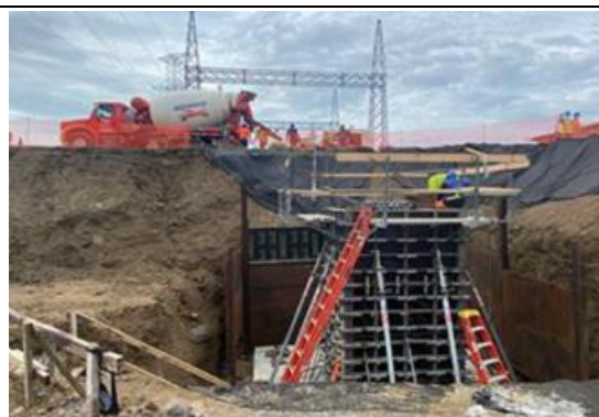
Foto # 10, Vaciado del pedestal del poste con bomba estacionaria en Subestación Panamá II.
