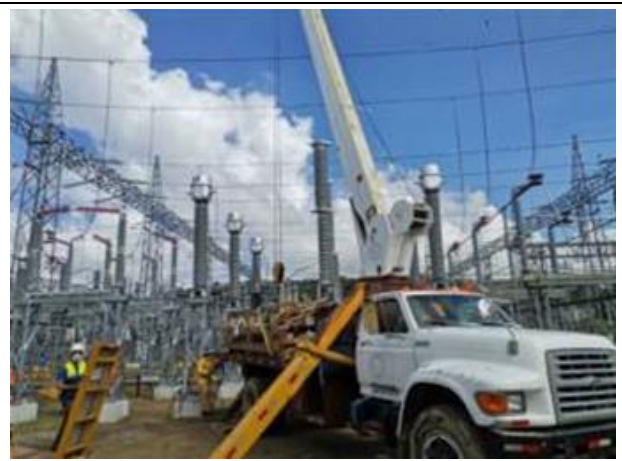
Foto # 6, Trabajos en el patio de la Subestación Panamá II.
