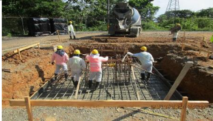
Foto # 7, Vaciado de Pórticos en la Subestación Changuinola.
