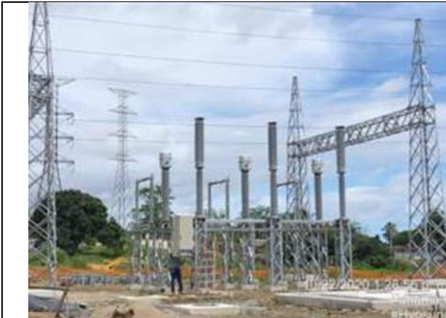
Foto # 5, Trabajos en el patio de la Subestación Panamá II.
