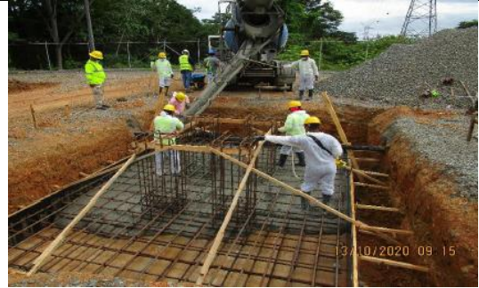
Foto # 6, Vaciado de Pórticos en la Subestación Changuinola.
