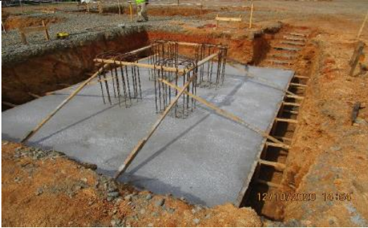
Foto # 5, Vaciado de Pórticos en la Subestación Changuinola.
