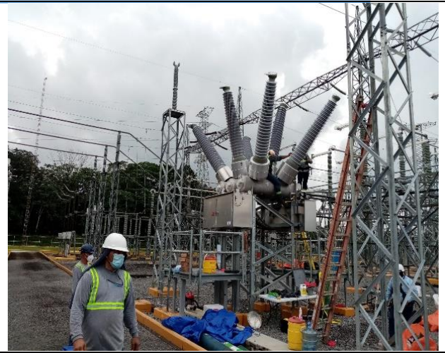
Foto # 2, Montaje y pruebas del nuevo interruptor en Subestación Progreso.
