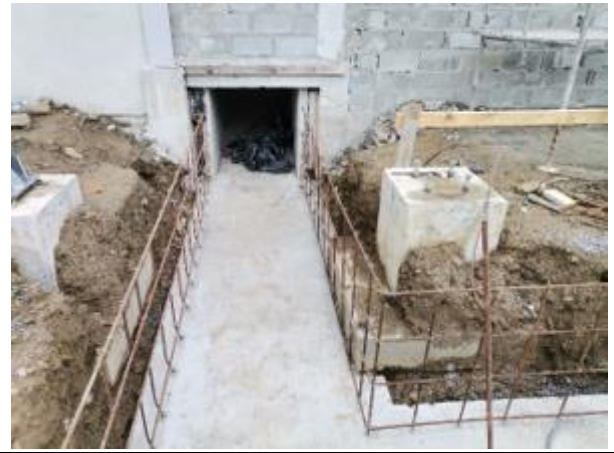
Foto # 6, Trabajos en las canaletas del patio de la Subestación Panamá II.
