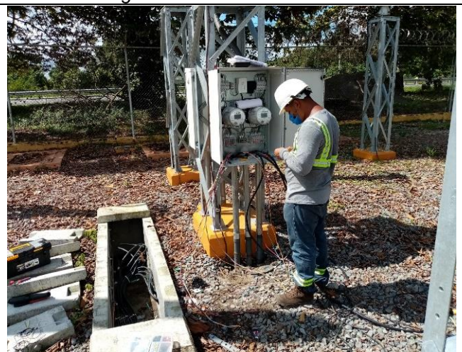
Foto # 4, Montaje del gabinete de medición del SMEC en Subestación Progreso.
