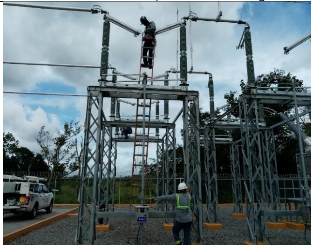
Foto # 5, Ajustes de seccionadores en Subestación Mata de Nance.
