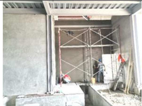
Foto # 9, Paredes intermedias de cooling 1 y cooling 2 en Subestación Panamá II.
