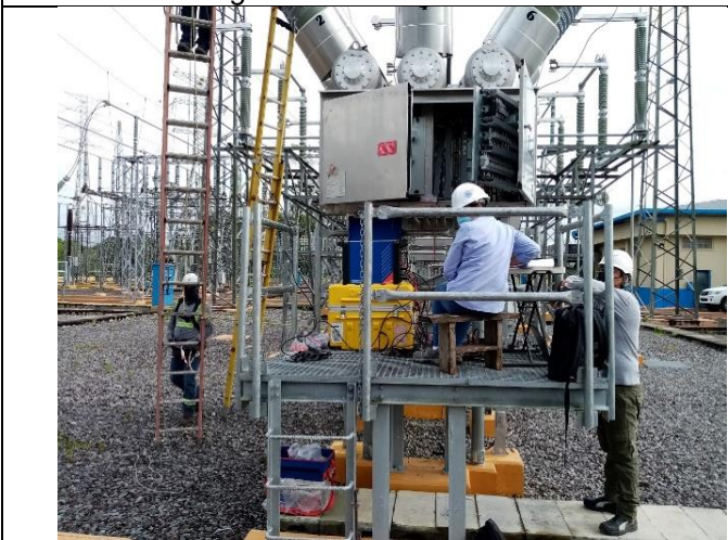
Foto # 3, Montaje y pruebas del nuevo interruptor en Subestación Progreso.
