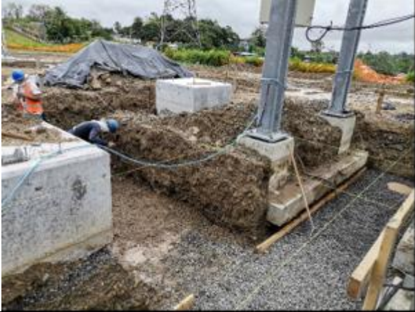
Foto # 5, Trabajos en las canaletas del patio de la Subestación Panamá II.
