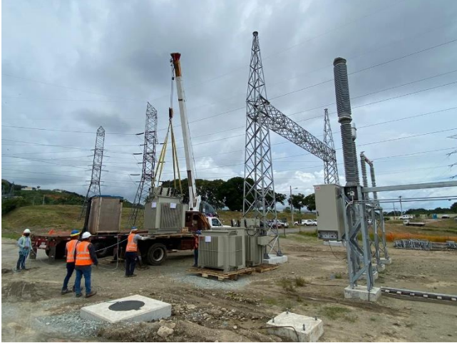
Foto # 1, Materiales entregados en Subestación Panamá II.
