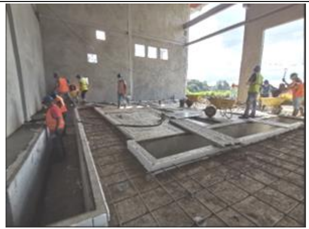
Foto # 8, Trabajos en el Valve Hall 2 en Subestación Panamá II.
