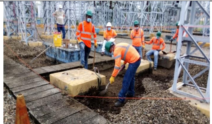
Foto # 2, Avance de las excavaciones para las demoliciones necesarias en Subestación Panamá.
