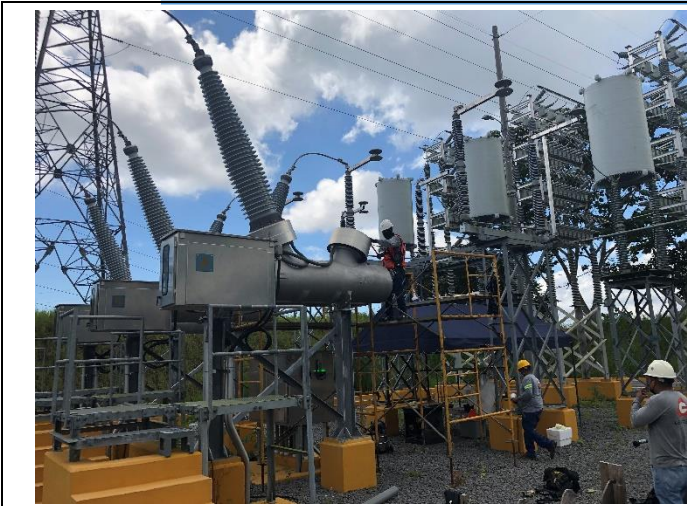
Foto # 1, Trabajos realizados dentro de la Subestación Panamá II.
