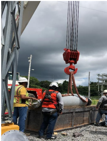
Foto # 3, Trabajos realizados dentro de la Subestación Panamá II.
