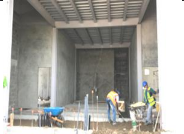
Foto # 10, Trabajos realizados en cuarto control en Subestación Panamá II.
