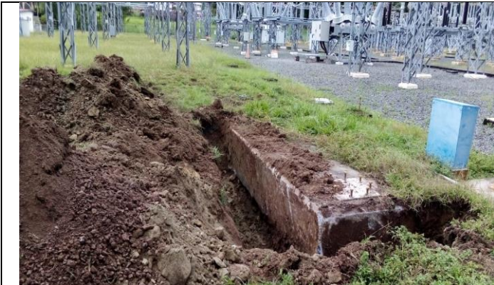
Foto # 1, Avance de las excavaciones para las demoliciones necesarias en Subestación Panamá.
