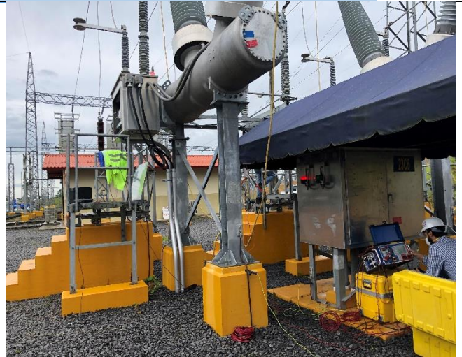
Foto # 2, Trabajos realizados dentro de la Subestación Panamá II.
