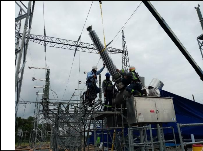
Foto # 1, Montaje y pruebas del nuevo interruptor en Subestación Progreso.
