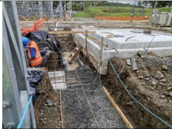
Foto # 7, Trabajos en las canaletas del patio de la Subestación Panamá II.
