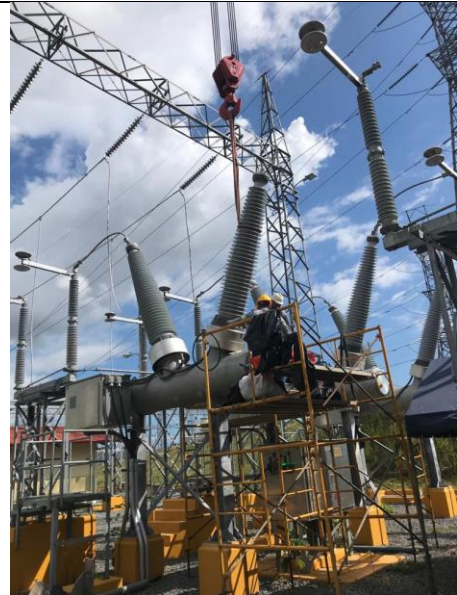
Foto # 4, Trabajos realizados dentro de la Subestación Panamá II.
