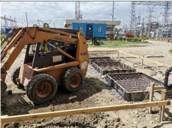
**Foto # 7, Fundaciones de los condensadores en Subestación Panamá II.**
