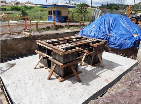
**Foto # 1,** *Fundación de interruptor de 115 kV en Subestación Panamá.*
