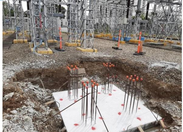
**Foto # 2,** *Fundación de interruptor de 115 kV en Subestación Panamá.*
