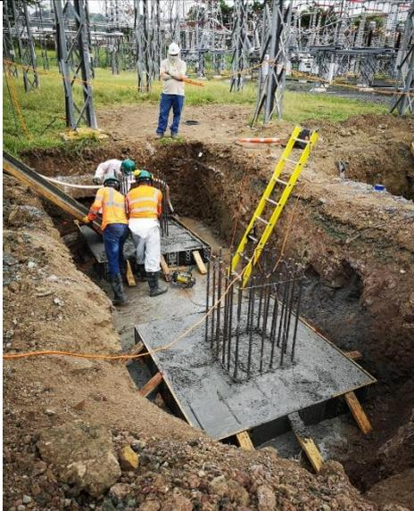
**Foto # 3,** *Fundación de aisladores de soporte de barra en Subestación Panamá.*
