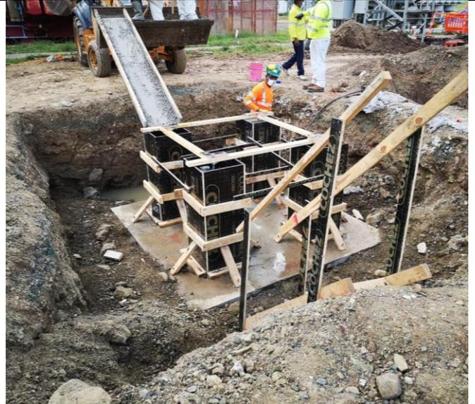
**Foto # 4,** *Fundación de interruptor de 230 kV en Subestación Panamá.*
