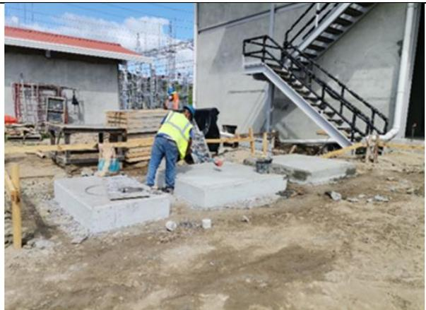
**Foto # 8, Fundaciones de los condensadores en Subestación Panamá II.**
