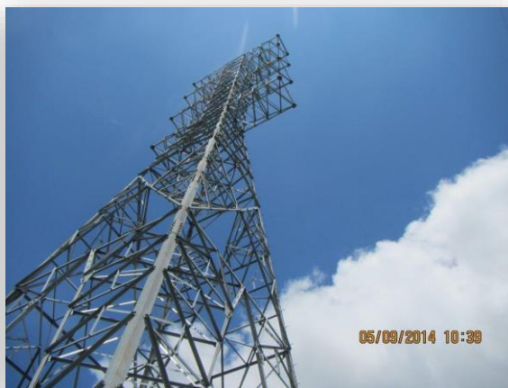
Montaje de torre N° 68 del tramo de 230 kV.
