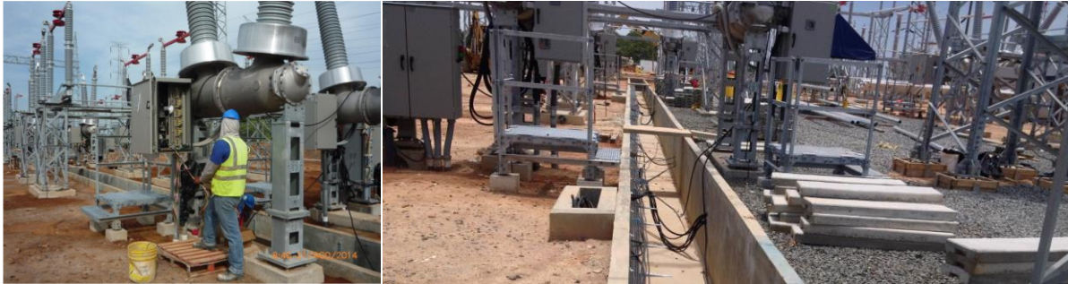
Conexión de los Equipos Electromecánicos del Patio 230 kV hacia la Casa Control.
