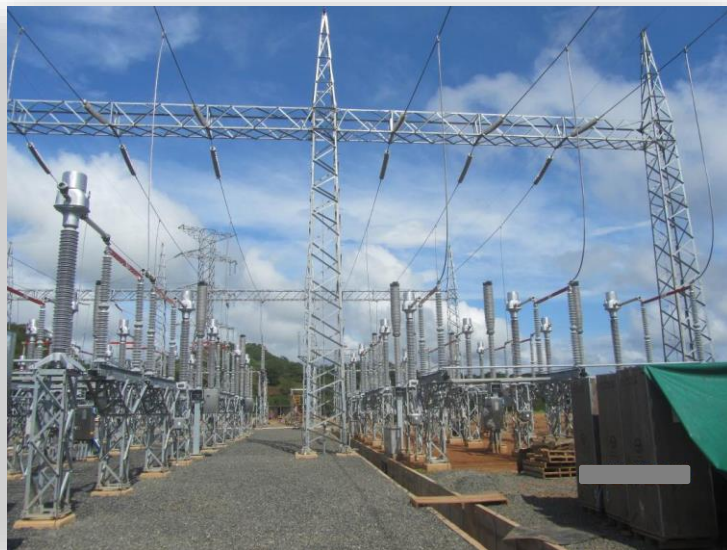
Avance de montaje de equipos y estructuras electromecánicas del Patio de 230 kV.
