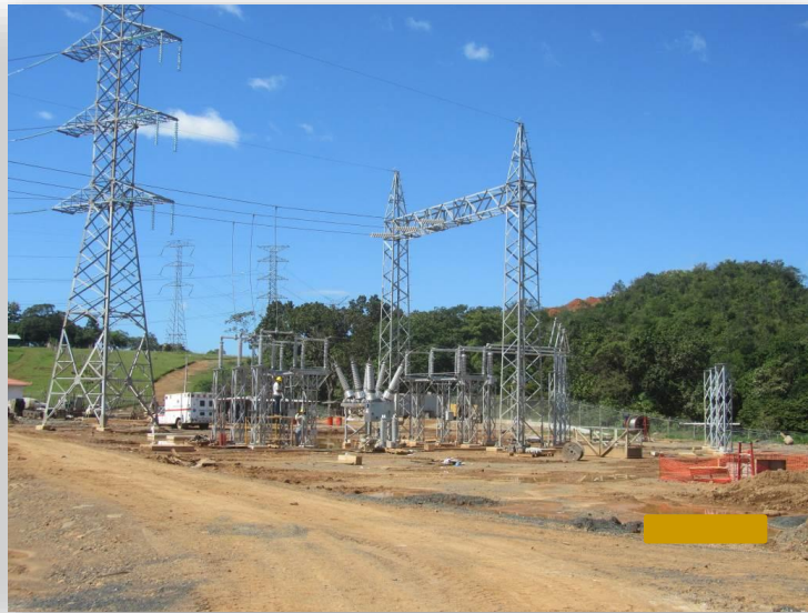
Avance de montaje de equipos y estructuras electromecánicas del Patio de 115 kV.
