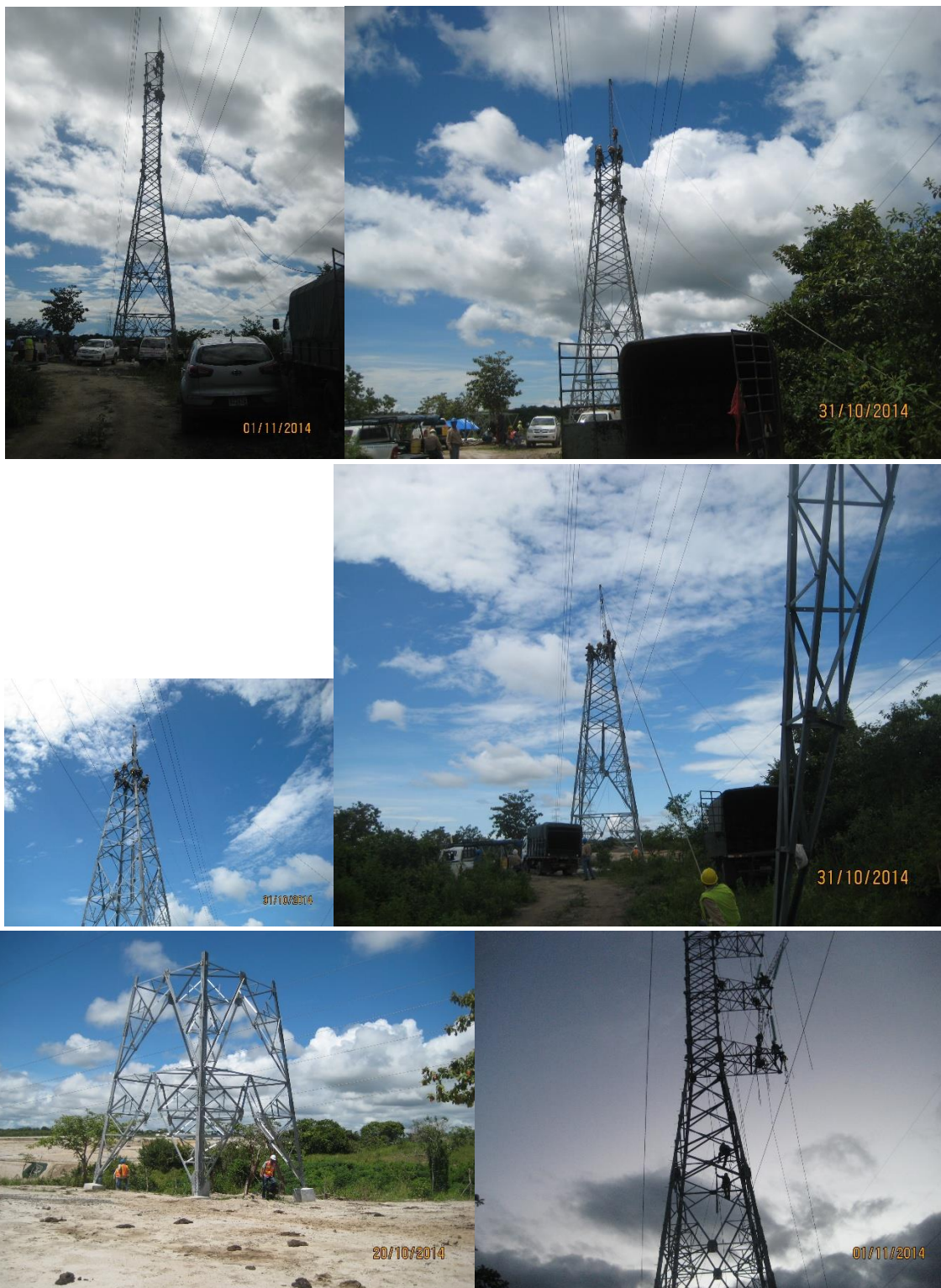
Secuencia de los trabajos de armado de la torre T248N para la seccionar de la Línea.
