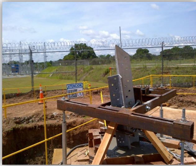
TORRE #510-41 TXAT Colocación de stub fundación tipo zapata
