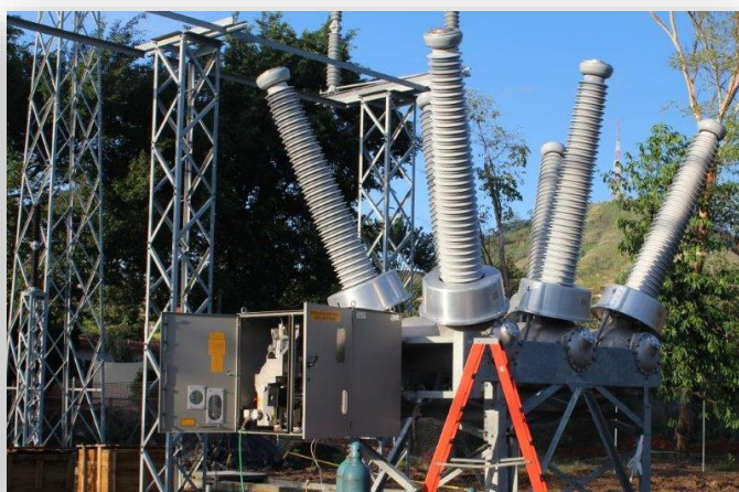
Interruptor de Potencia montado en su base, S/E Panamá.
