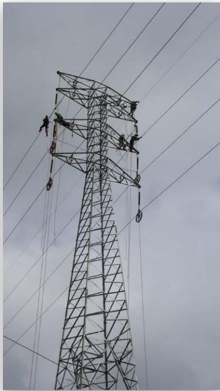
Trabajo de Flechado de la Línea Santa Rita – Chagres 115 kV.
