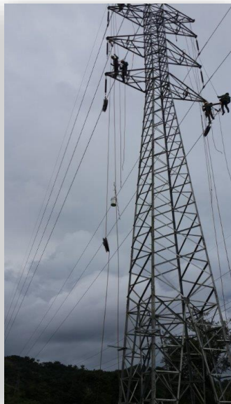
Maniobras durante el tendido de los cables en la segunda sección.
