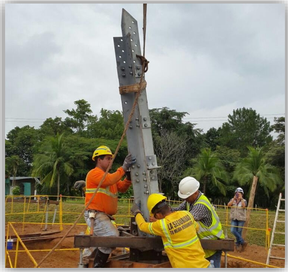
TORRE #510-41 TXAT Colocación de stub fundación tipo zapata
