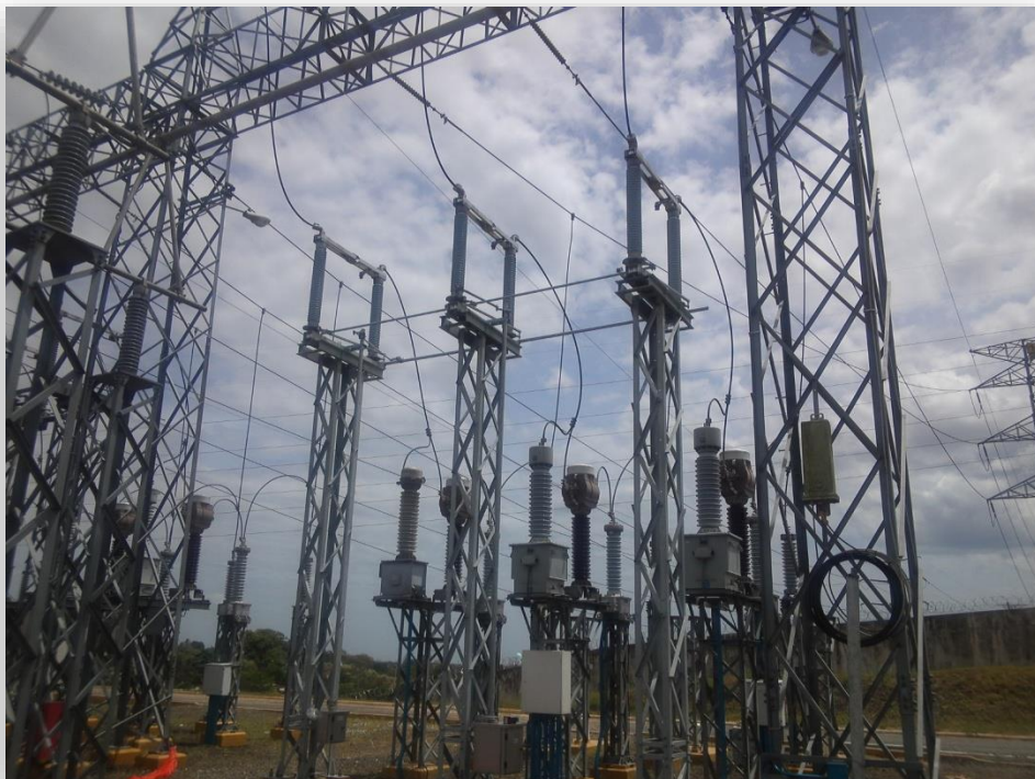
Seccionadoras Motorizada de las Líneas 115-28 y 29 - S/E Panamá II.
