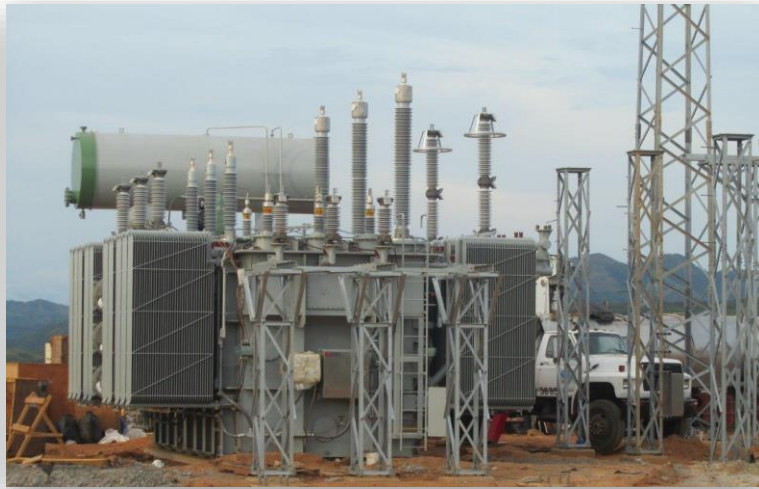
Transformador de Potencia ubicado en su base.
