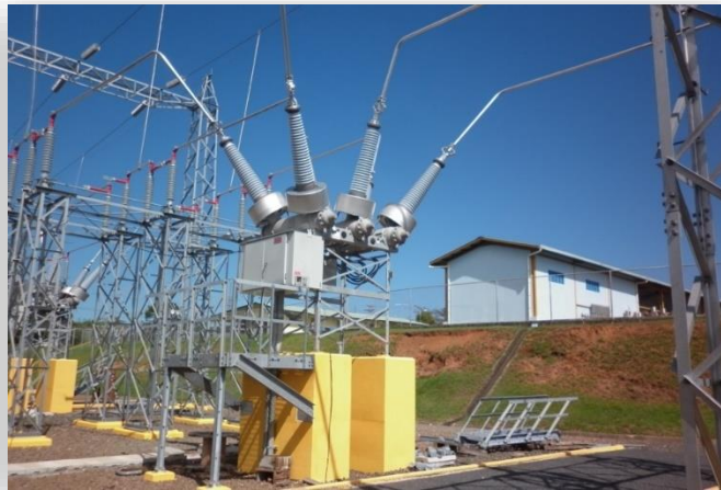
Vista Interruptor de 115kV asociado al T3 de la S/E Llano Sánchez.
