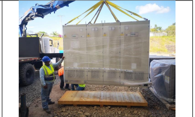
Foto # 2, Entrega de algunos materiales en la subestación Llano Sánchez.
