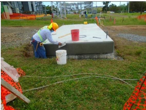
Foto # 1, Trabajos en la fundación del autotransformador en subestación.
