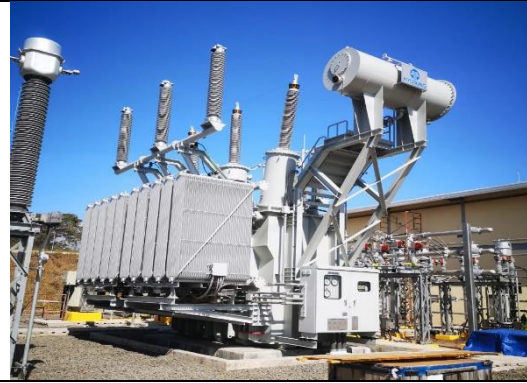
Foto # 4, Montaje de transformador de acople en subestación Llano Sánchez.
