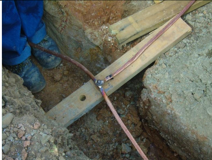
Foto # 5, Trabajos de soldadura en la malla de tierra, alrededor del Autotransformador T1.
