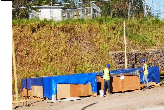
Foto # 1, Entrega de algunos materiales en la subestación Llano Sánchez.
