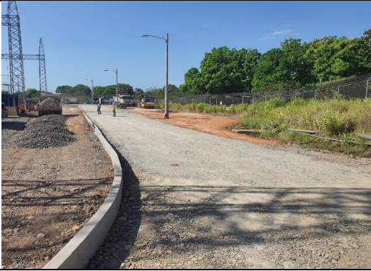
Foto # 3, Construcción de calles internas del proyecto en subestación Llano Sánchez.
