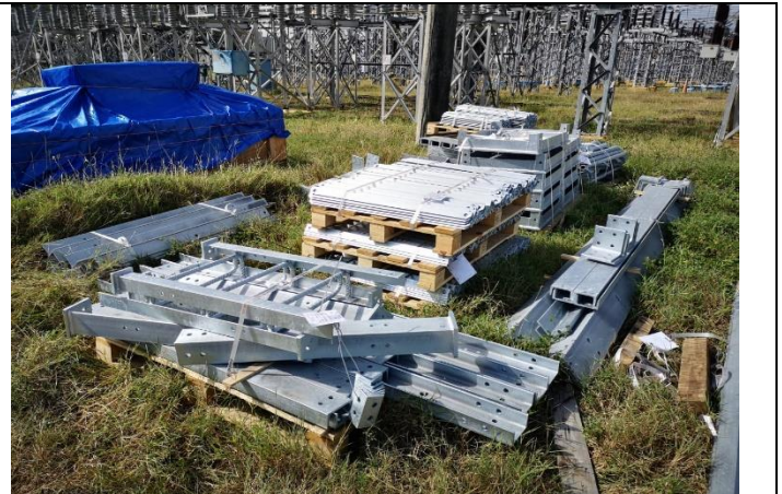
Foto # 2, Recepción de estructuras metálicas en subestación Panamá.
