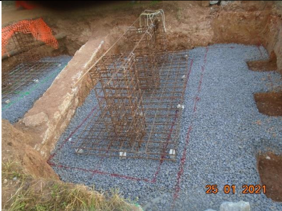
Foto # 3, Trabajos en la fundación de la cuchilla seccionadora 3T1A en subestación.
