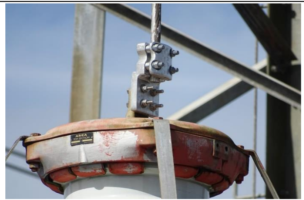
Foto # 6, Trabajos de bajantes en las cuchillas y pararrayos en la Subestación Mata de Nance.
