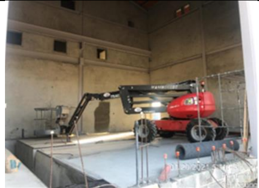
Foto # 6, Trabajos en casa control con grúa puente en subestación Panamá II.
