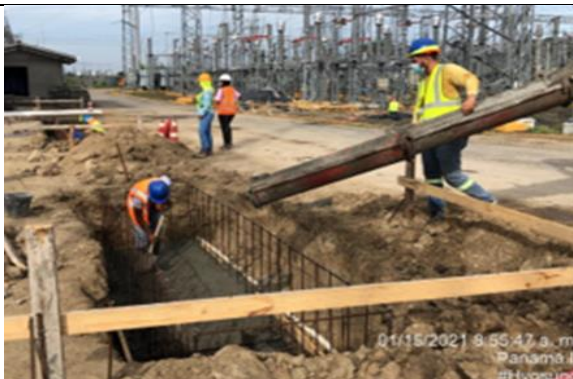
Foto # 9, Trabajos civiles en patio de la subestación Panamá II.
