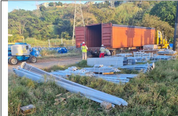
Foto # 1, Recepción de estructuras metálicas en subestación Panamá.
