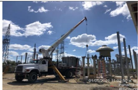
Foto # 10, Trabajos eléctricos en patio de la subestación Panamá II.
