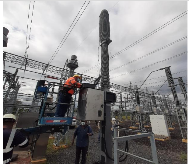
Foto # 2, Instalación de interruptor 23B42 en subestación Veladero.
