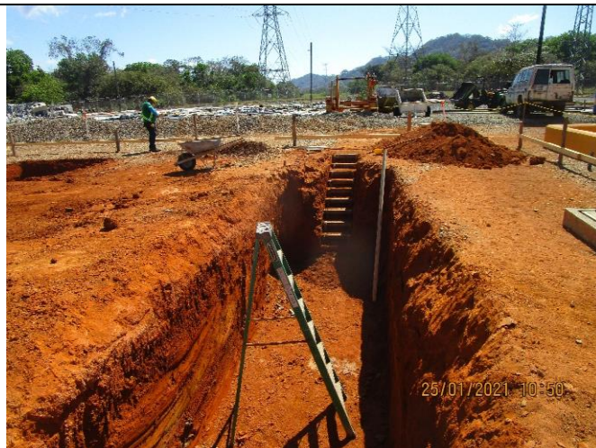
Foto # 4 , Excavación de soporte de barra tripolar en subestación Mata de Nance.
