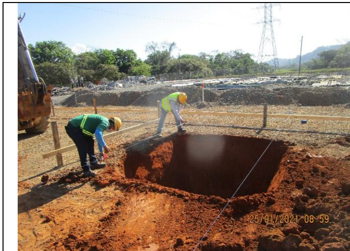
Foto # 3 , Excavación de soporte de barra de 230 kV en subestación Mata de Nance.
