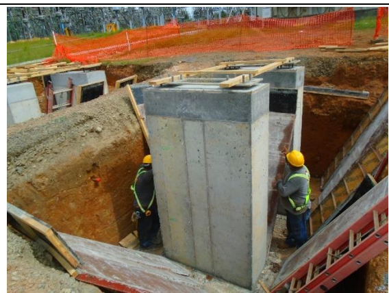
Foto # 2, Trabajos en la fundación de la cuchilla seccionadora 23T1 en subestación.
