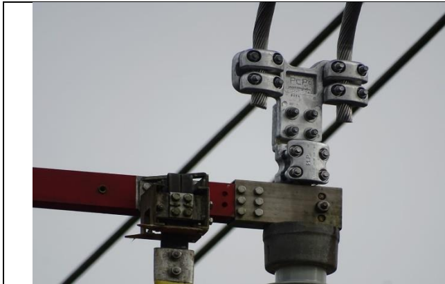
Foto # 5, Trabajos de bajantes en las cuchillas y pararrayos en la Subestación Mata de Nance.
