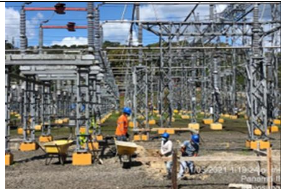
Foto # 8, Trabajos civiles en el patio de la subestación Panamá II.
