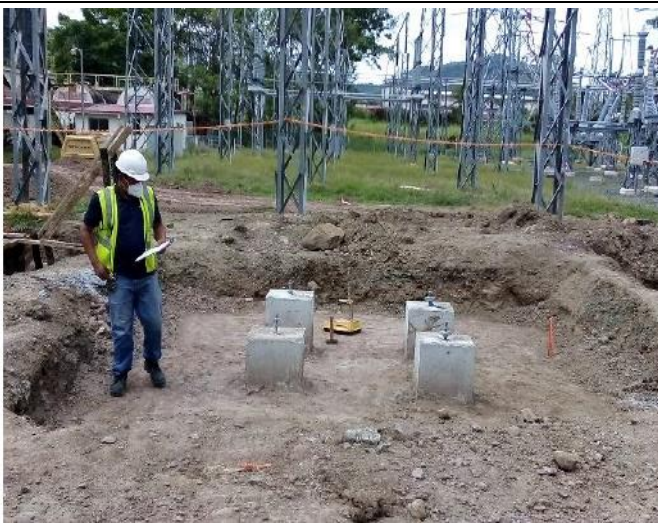
Foto # 1, Fundación de interruptor de 230 kV en subestación Panamá.
