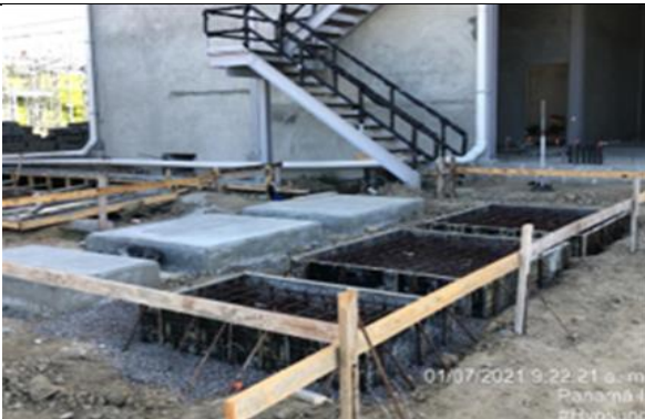
Foto # 7, Fundaciones de Aire Acondicionado en subestación Panamá II.
