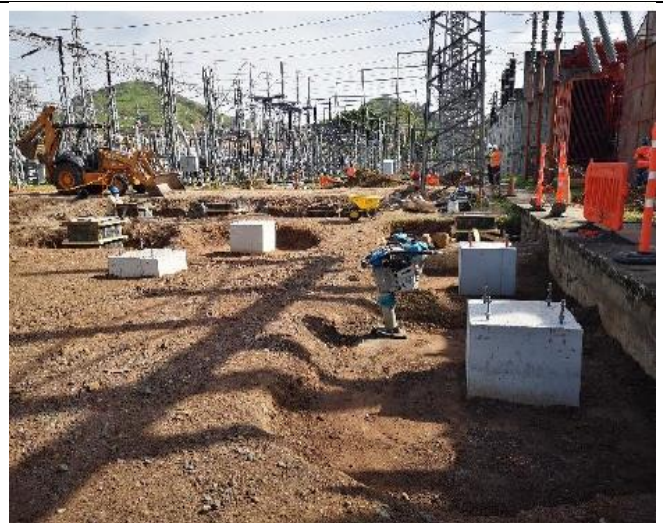
Foto # 2, Trabajos civiles en el patio de 230 kV en subestación Panamá.
