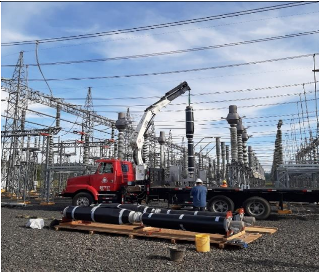
Foto # 1, Instalación de interruptor 23B42 en subestación Veladero.
