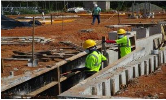
Foto # 3, Desencofrado de muros de canaleta 3A en subestación Changuinola.
