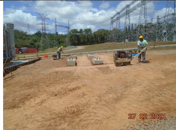
Foto # 4, Compactación del terreno en subestación Chorrera.
