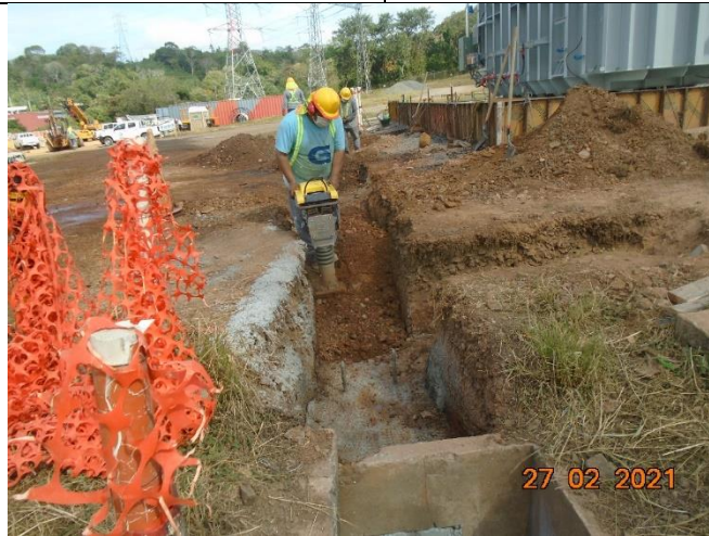
Foto # 5, Compactación del terreno en subestación Chorrera.
