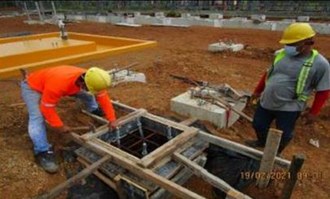
Foto # 5, Preparación de base para soporte de gabinete en interruptor de tanque muerto en S/E Changuinola.
