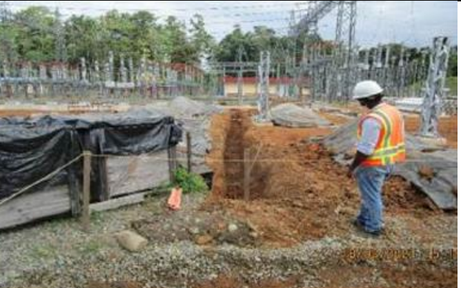
Foto # 7, Excavación de zanja para drenaje en subestación Changuinola.
