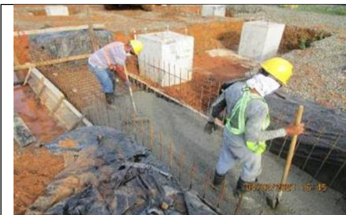
Foto # 1, Vaciado de concreto en la parte final de la canalera tipo 3A en subestación Changuinola.
