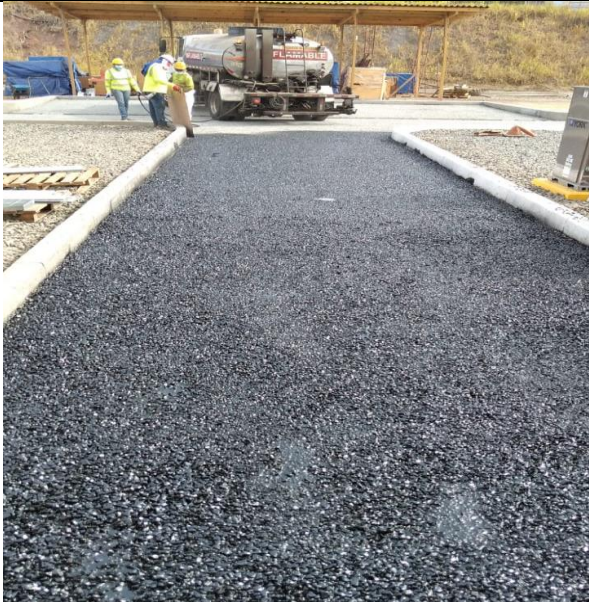
Foto # 3, Doble sello en las calles internas en subestación Llano Sánchez.
