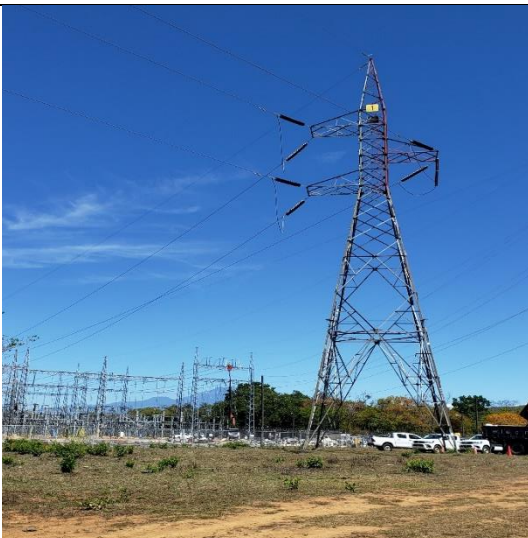
Foto # 1, Relocalización de las líneas 230-5B y 230-6C en subestación Mata de Nance.
