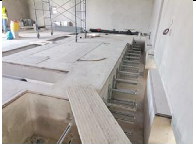
Foto # 6, Colocación de bastidores de soporte para cables en canaletas internas en subestación Panamá II.
