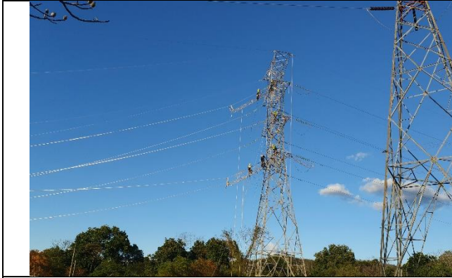
Foto # 5, Trabajos en la torre 940 y la Nave 4 a la subestación Mata de Nance.
