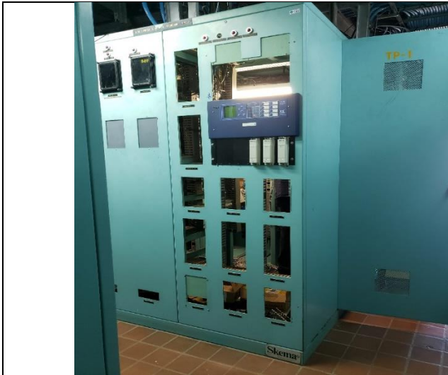
Foto # 3, Reemplazo de protecciones para las futuras posiciones de las líneas 230-9A y 230-39 en subestación Mata de Nance.
