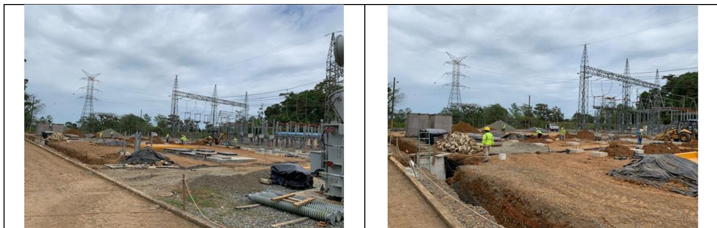
Foto # 1, Trabajos Civiles en subestación Changuinola.
