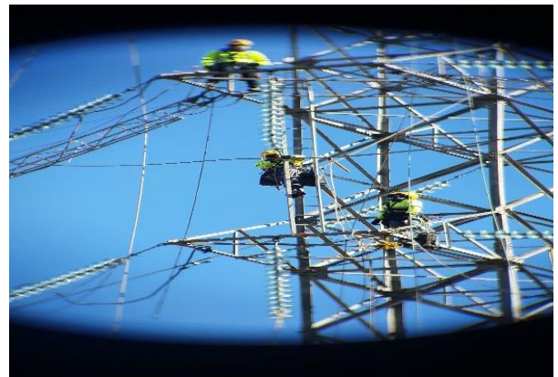
Foto # 2 , Trabajos en la torre 940 a la subestación Mata de Nance.
