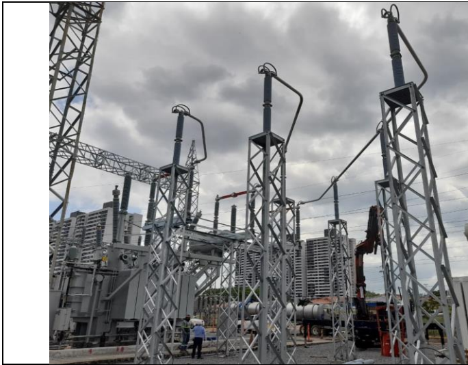
Foto # 1, Montaje de estructuras y barraje de 230kV en subestación Panamá.
