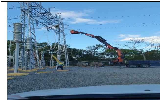
Foto # 3 , Trabajos de cambio de pórtico a la Nave 4 en subestación Mata de Nance.
