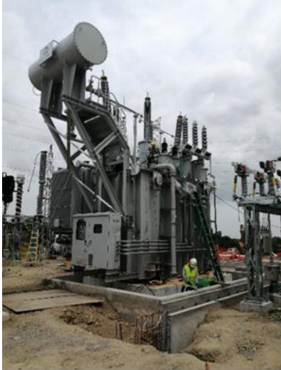
Foto # 7, Trabajos de montaje de elementos del T4 en subestación Panamá II.
