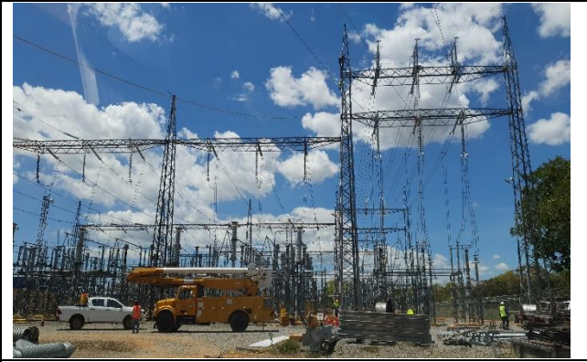
Foto # 6, Trabajos en la torre 940 y la Nave 4 a la subestación Mata de Nance.
