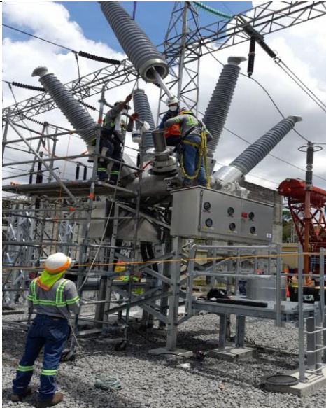
Foto # 3, Montaje de interruptor de 230kV en subestación Panamá.
