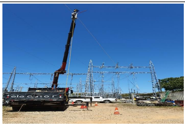
Foto # 4 , Trabajos de cambio de pórtico a la Nave 4 en subestación Mata de Nance.
