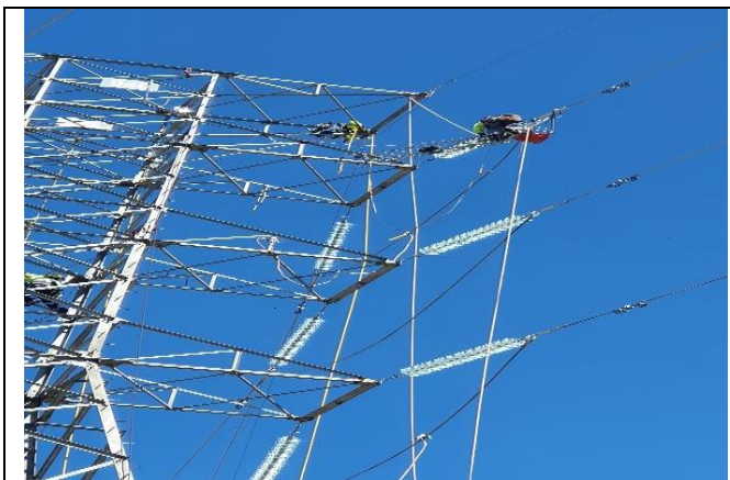
Foto # 1 , Trabajos en la torre 940 a la subestación Mata de Nance.
