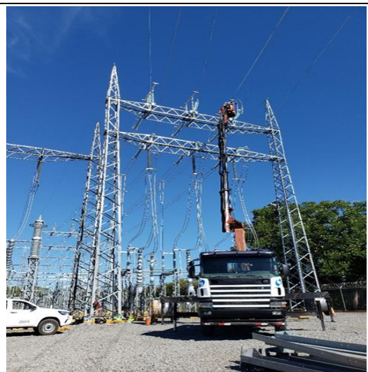
Foto # 2, Relocalización de las líneas 230-5B y 230-6C en subestación Mata de Nance.
