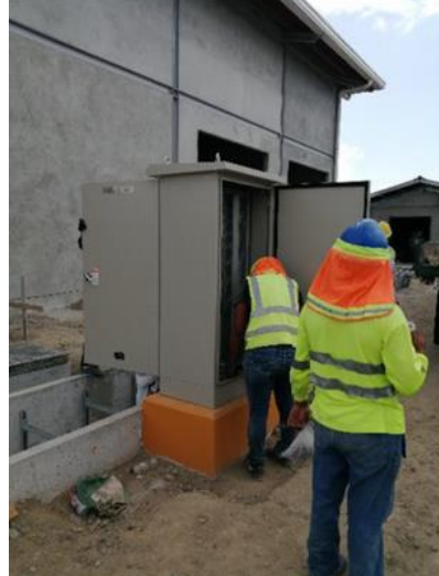
Foto # 8, Trabajos en el panel MK01 en subestación Panamá II.
