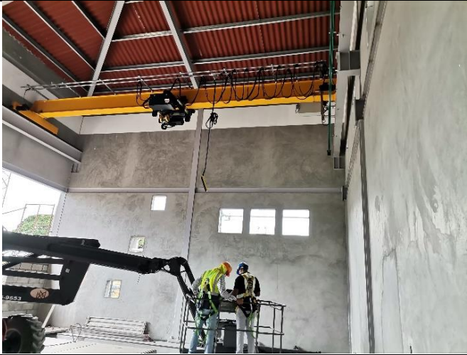
Foto # 5, Trabajos de la grúa puente del Valve Halle 1 en subestación Panamá II.
