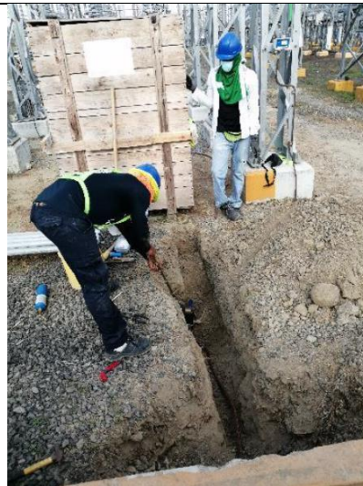
Foto # 10, Trabajos en la red de tierra del poste metálico de 230 kV en subestación Panamá II.
