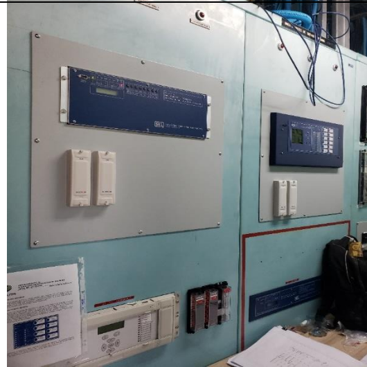
Foto # 6, Reemplazo de protecciones para las futuras posiciones de las líneas 230-9A y 230-39 en subestación Mata de Nance.
