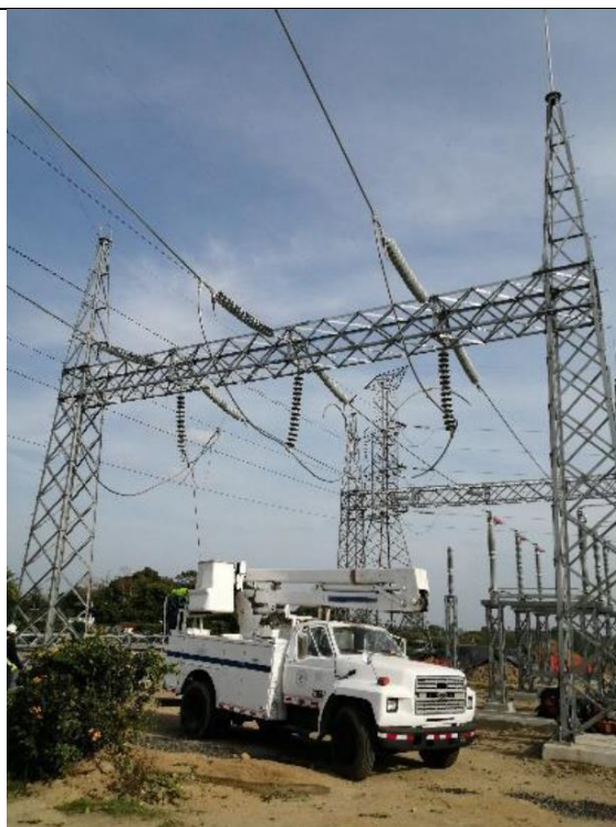
Foto # 4, Instalación de cable 1590 AAC entre el portico del STATCOM y el poste de 230 kV
