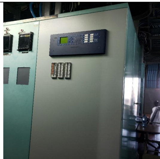
Foto # 5, Reemplazo de protecciones para las futuras posiciones de las líneas 230-9A y 230-39 en subestación Mata de Nance.
