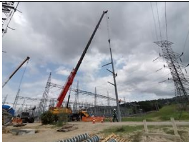
Foto # 8, Montaje de poste metálico de 230 kV
