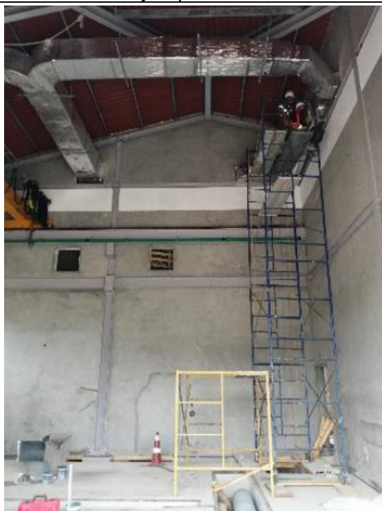
Foto # 6, Instalación de ductos de Aire Acondicionado
