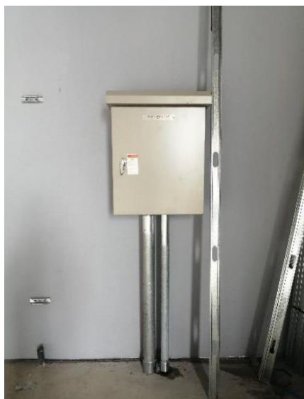
Foto # 5, Instalación del Panel del Valve Hall 1 y 2
