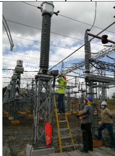
Foto # 9, Prueba de resistencia de aislamiento de CTS de 230kV, nave 1, en subestación Panamá II.
