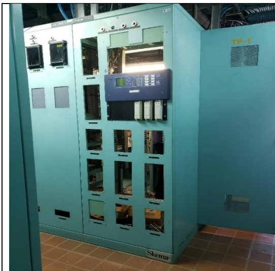
Foto # 3, Reemplazo de protecciones para las futuras posiciones de las líneas 230-9A y 230-39 en subestación Mata de Nance.
