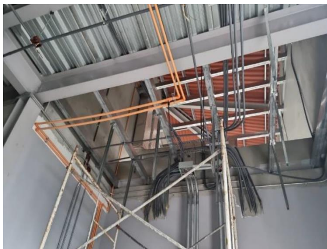
Foto # 2, Instalación de tuberías y cableado del sistema VESDA en Valva Hall #2 y Cuarto de Control
