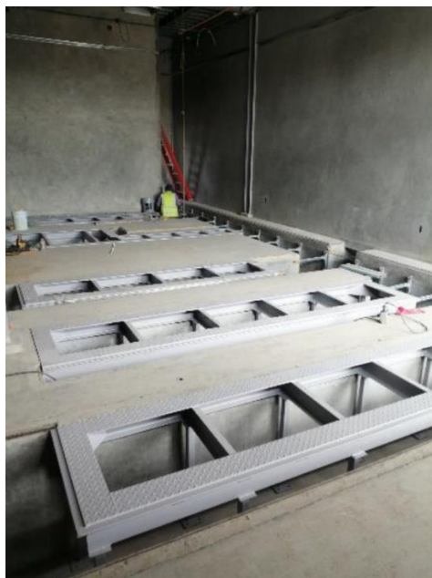
Foto # 3, . Instalación de los soportes para tableros de Control
