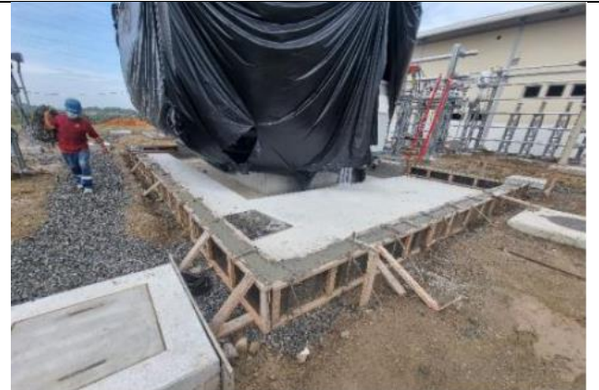
Foto # 6 Vaciado de las paredes del transformador
