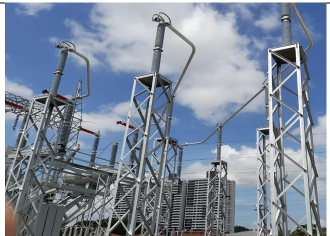
Foto # 4 Montaje de aisladores soporte y barras de 230kV
