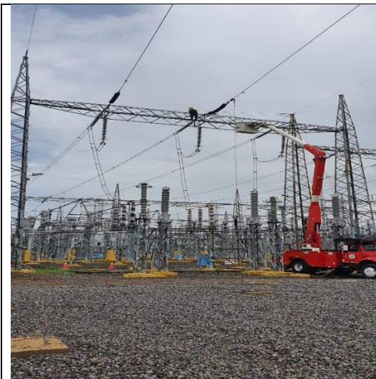
Foto # 1, Trabajos en la torre 1 de la línea 230-9 Mata de Nance.
