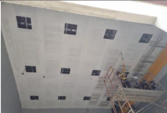
Foto # 5. Colocación de tape y pasta de cielo raso
