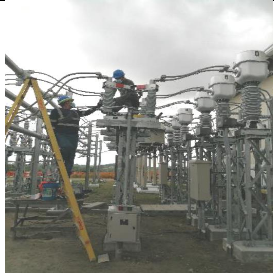
Foto # 8 . Instalación de brazos para el sistema de aterrizaje de seccionadoras de 22.2 kV
