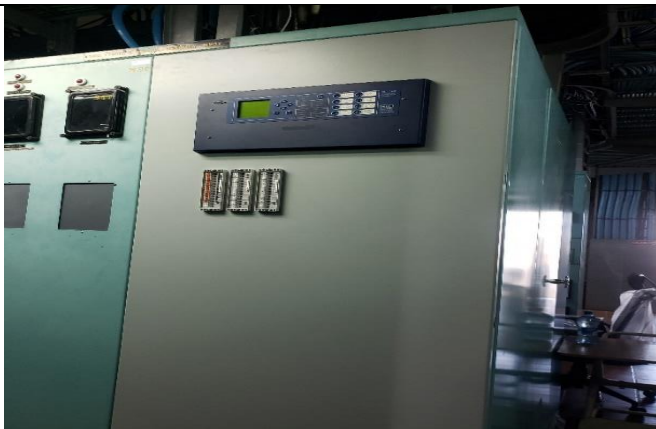
Foto # 5, Reemplazo de protecciones para las futuras posiciones de las líneas 230-9A y 230-39 en subestación Mata de Nance.
