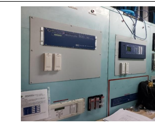
Foto # 6, Reemplazo de protecciones para las futuras posiciones de las líneas 230-9A y 230-39 en subestación Mata de Nance.
