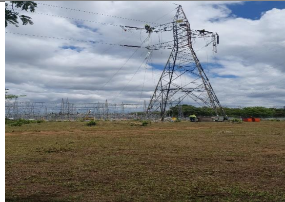
Foto # 5, Trabajos en la torre 1 de la línea 230-9 Mata de Nance.
