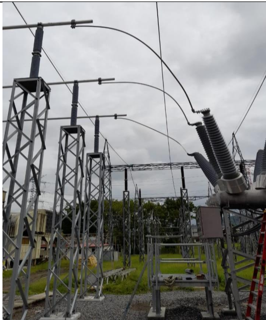
Foto # 1 Conexión de interruptor de 230kV
