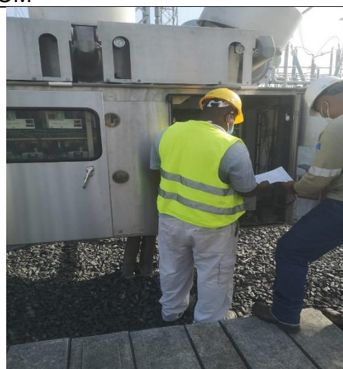
Verificación de conexión de cableado de estado de los interruptores de los bancos de capacitores y reactores existentes
