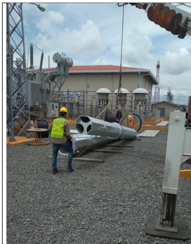
. Entrega del nuevo poste metálico de 230 kV
