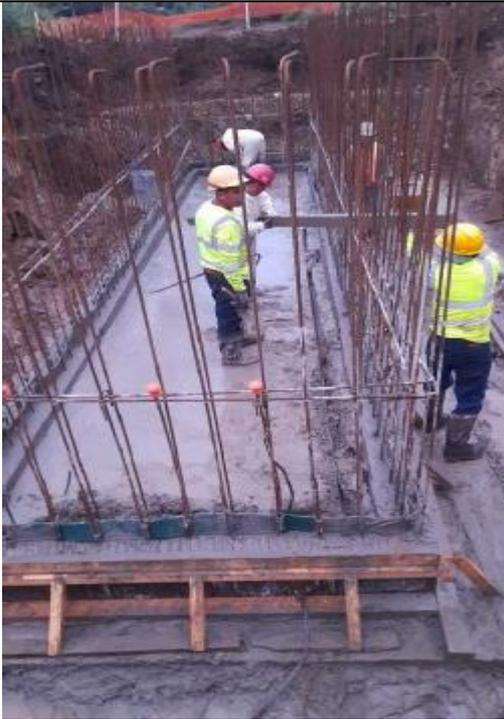
Línea de Transmisión – Cámara de empalme. Armado de acero de refuerzo.
