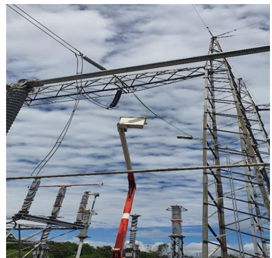
Foto # 2, Trabajos en la Nave 2 de Mata de Nance.
