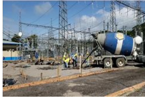
Foto # 4 Vaciado de fundaciones de aisladores soporte de barra de 230 kV
