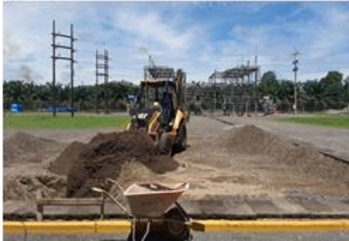
Foto # 3 Excavación para fundación de seccionador de 115 K
