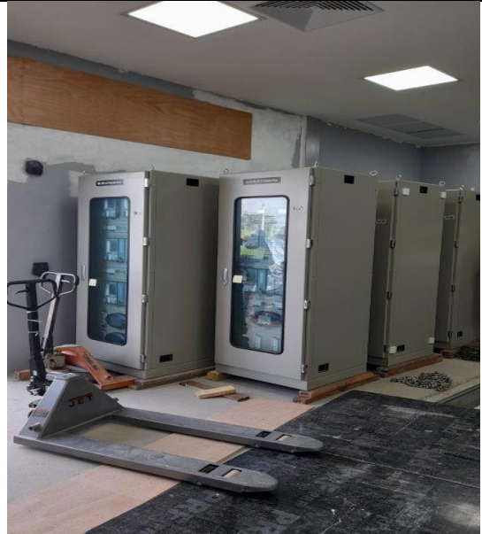
Foto # 6 Suministro de gabinetes de protección y control.
