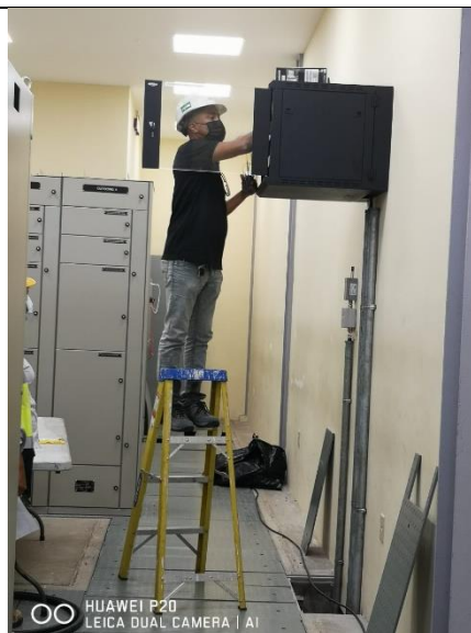
Foto # 2, Instalación de rack de comunicaciones
