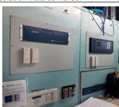
Foto # 6, Reemplazo de protecciones para las futuras posiciones de las líneas 230-9A y 230-39 en subestación Mata de Nance.
