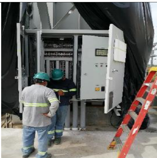
Foto # 7 Reparación de puerta y pintura del panel de control del transformador principal del proyecto STATCOM
