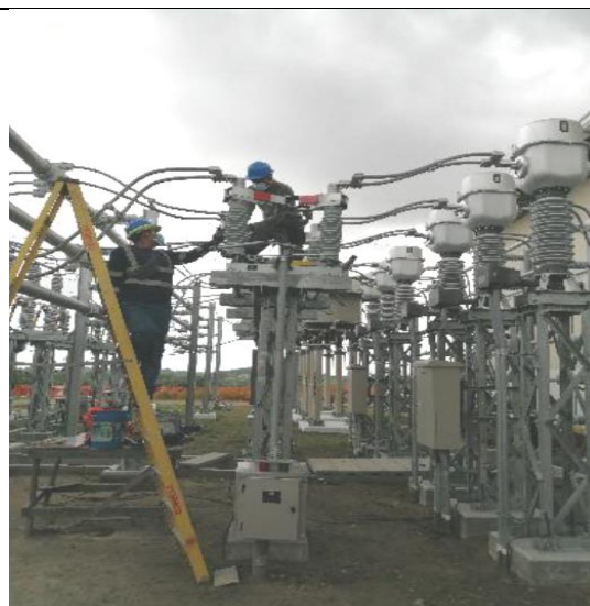
Foto # 8 . Instalación de brazos para el sistema de aterrizaje de seccionadoras de 22.2 kV
