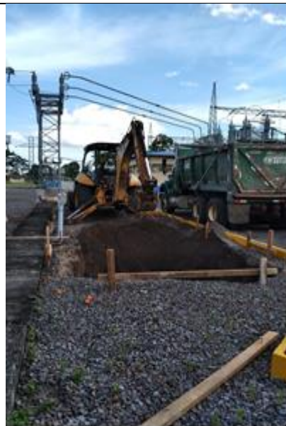
Foto # 4 Excavación para cuchilla de 115 kV
