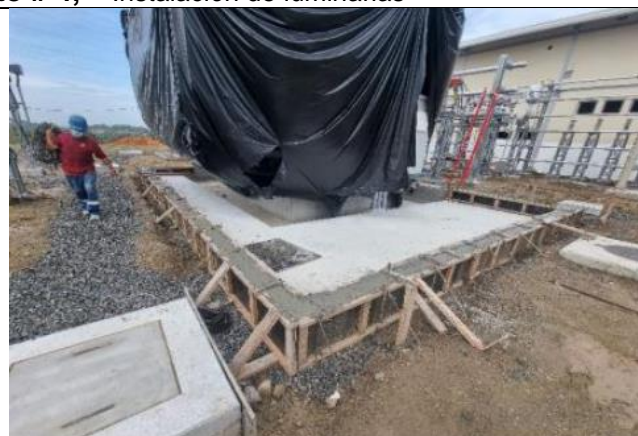
Foto # 6 Vaciado de las paredes del transformador
