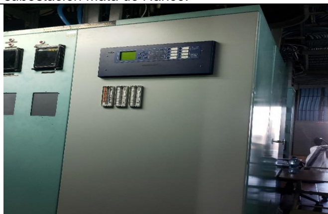
Foto # 5, Reemplazo de protecciones para las futuras posiciones de las líneas 230-9A y 230-39 en subestación Mata de Nance.
