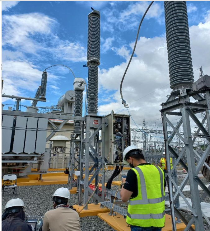
Pruebas a los interruptores de 230 kV del patio del STATCOM, realizadas por personal de ABB.
