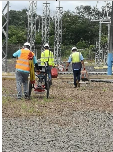
Foto # 3, Estudio de GeoRadar en la Subestación Llano Sánchez.
