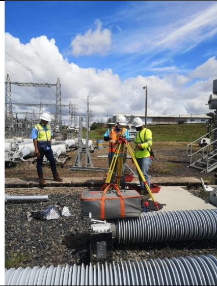
Foto # 2, Levantamiento Topográfico en la Subestación Llano Sánchez.
