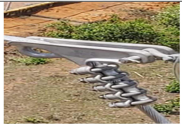
Foto # 6, Trabajos en la Nave 2 de Mata de Nance.
