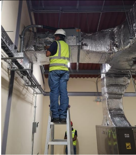
Foto # 7 Revisión a sistema de aire acondicionado
