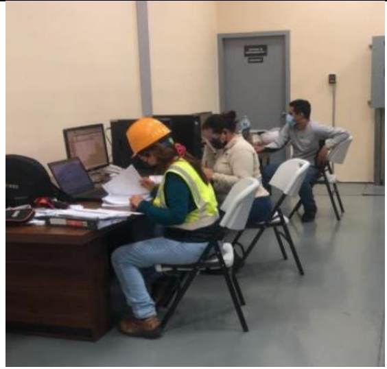
Foto # 8 . Pruebas de señales en HMI STATCOM
