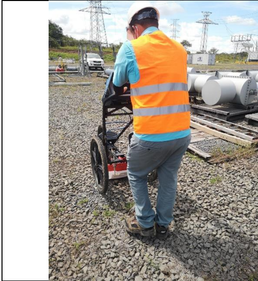
Foto # 1, Estudio de GeoRadar en la Subestación Llano Sánchez.
