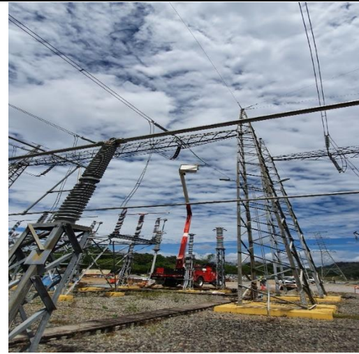
Foto # 4, Trabajos en la Nave 2 de Mata de Nance.
