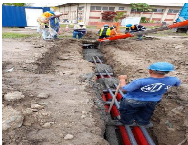
Foto # 1, Vaciado de concreto para vigaducto de comunicación entre casas control.
