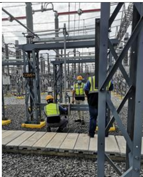
Foto # 5. Revisión de enclavamientos de cuchillas manuales
