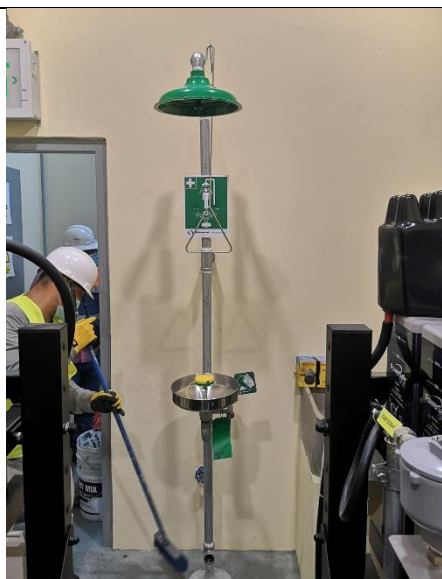
Foto # 6 Instalación de ducha de emergencia
