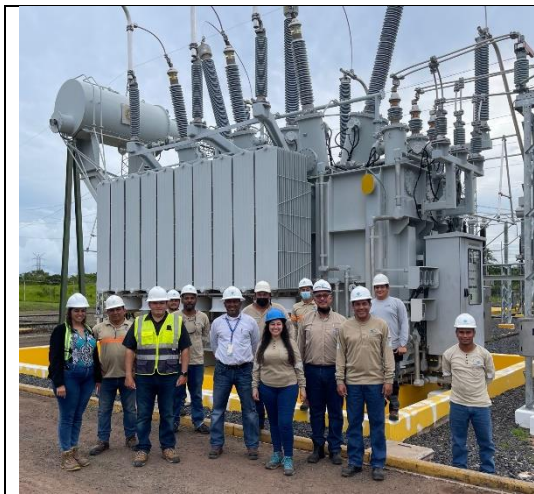
Energización de transformador T2 Subestación Llano Sánchez
