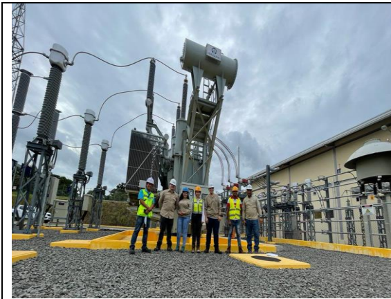
Energización de transformador T4
