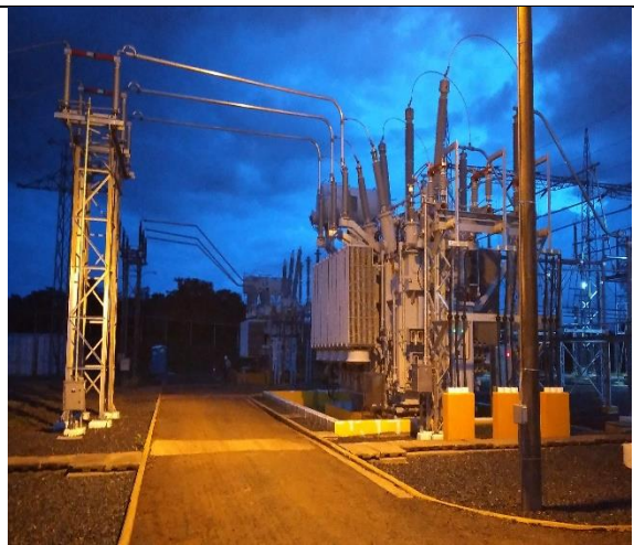
Energización de transformador T2 Subestación Llano Sánchez
