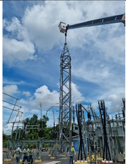
Foto # 4, Desmontaje de antiguo portico del T1 de la Subestación Llano Sánchez.
