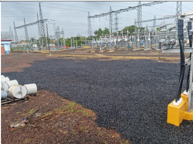
Foto # 5, Colocación de piedra#4 del área de trabajo en la Subestación Llano Sánchez.
