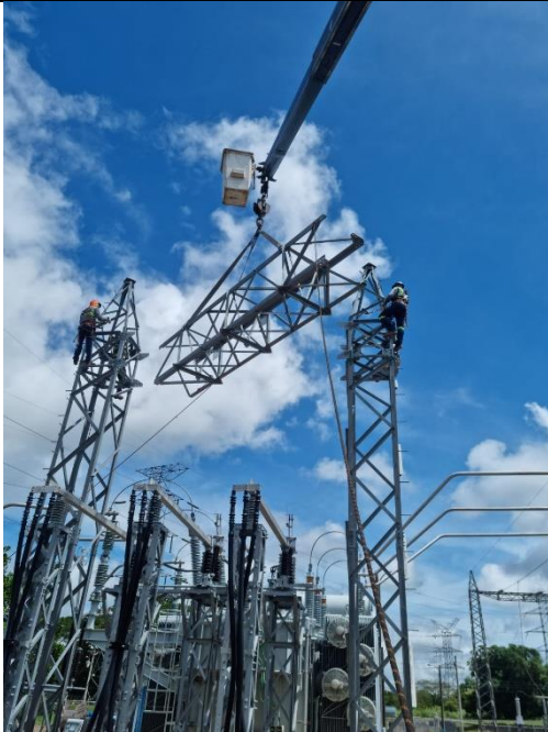
Foto # 3, Desmontaje de antiguo portico del T1 de la Subestación Llano Sánchez.
