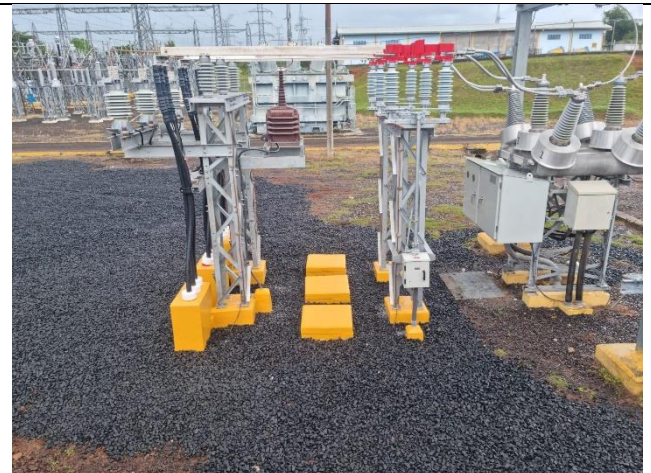
Foto # 6, Colocación de piedra#4 del área de trabajo en la Subestación Llano Sánchez.
