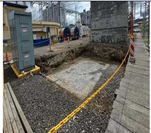
Demolición de fundación existente en subestación Panamá
