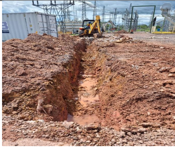
Demolición de vigaducto existente en subestación Llano Sánchez
