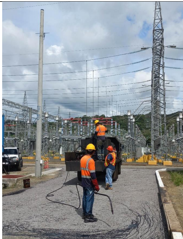
Proceso de imprimación de capa asfáltica de calles internas de la plataforma del STATCOM.
