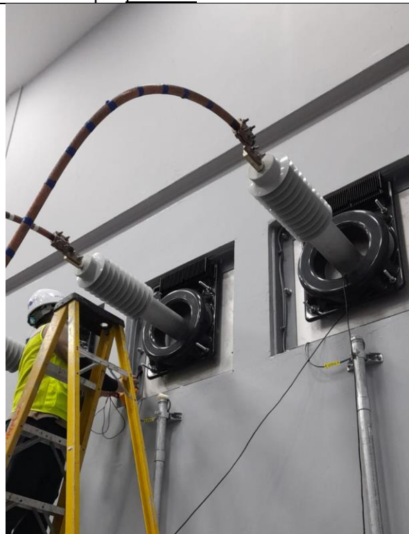
Inicio de pruebas de los wallbushings de DC y AC de los Valve Hall.
