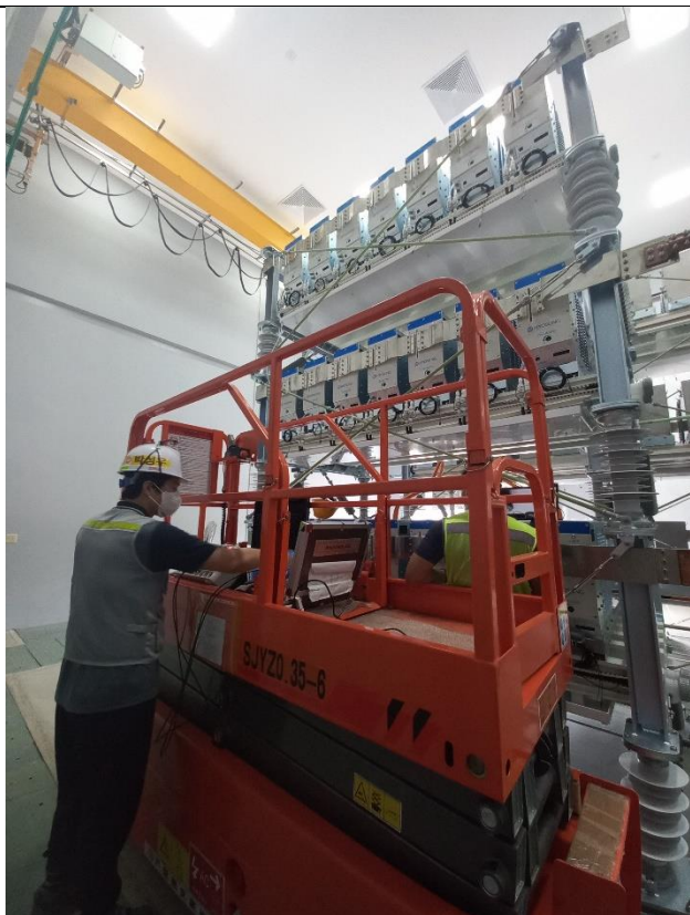
Pruebas a los IGBT de cada sub-módulo del STATCOM. Efectuada por personal de fábrica de Corea
