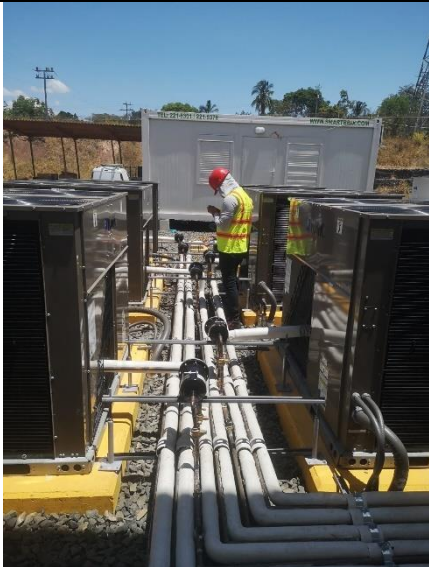
Verificaciones en sistema de A/A
