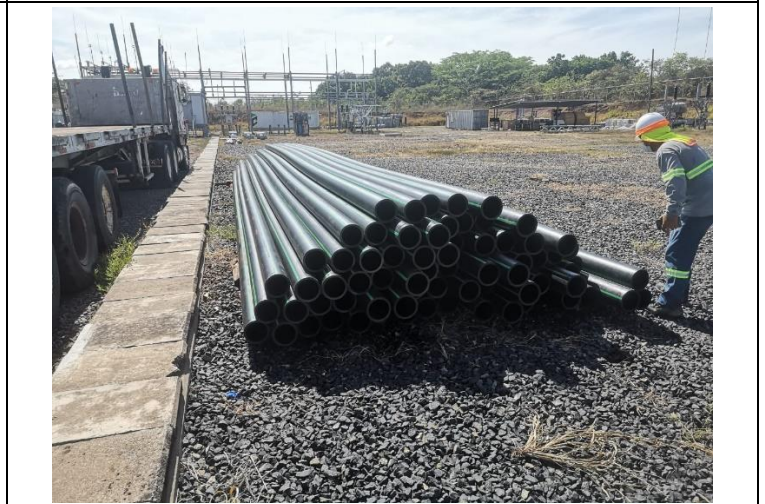
Foto # 4, Entrega del suministro de tuberías para PHD en la Subestación Llano Sánchez.
