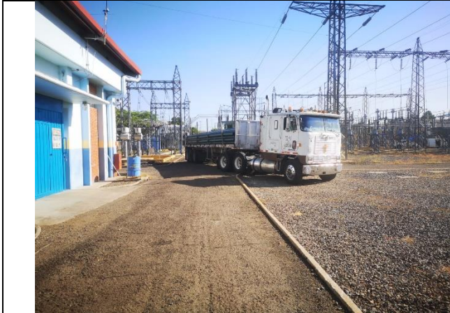
Foto # 1, Entrega del suministro de tuberías para PHD en la Subestación Llano Sánchez.
