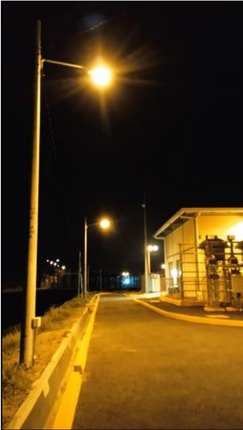
Pruebas de Iluminación Exterior del proyecto
