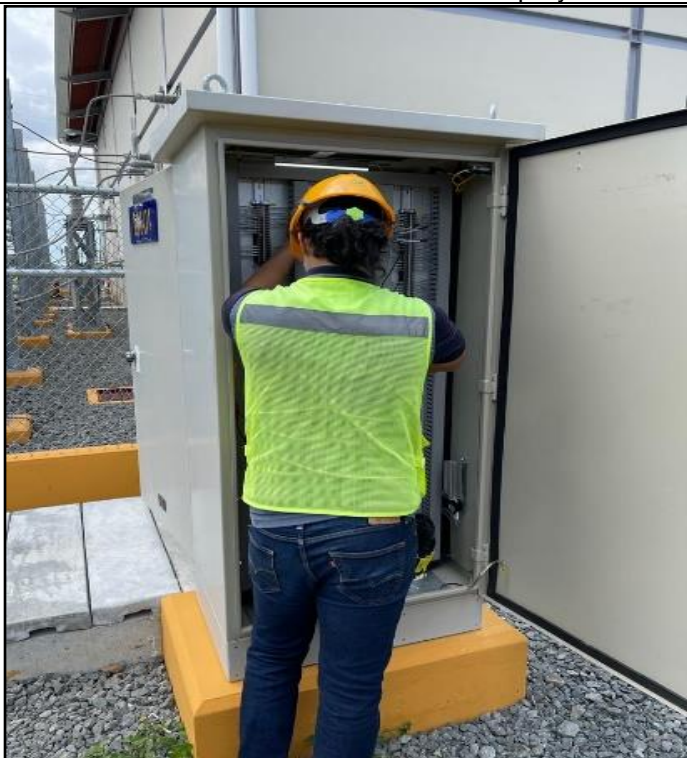
Avance de listado de temas pendientes. Finalizar conexionado de equipos.
