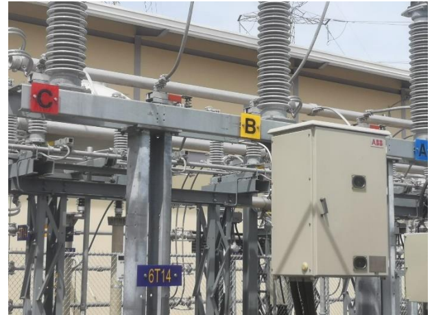
Colocación de letreros de fases en interruptores
