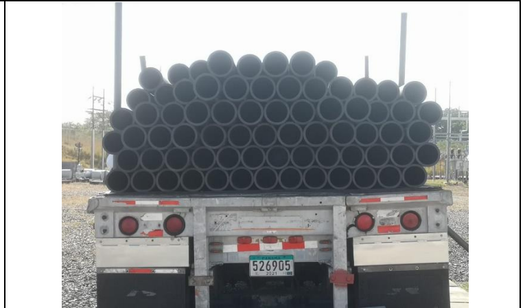
Foto # 2, Entrega del suministro de tuberías para PHD en la Subestación Llano Sánchez.
