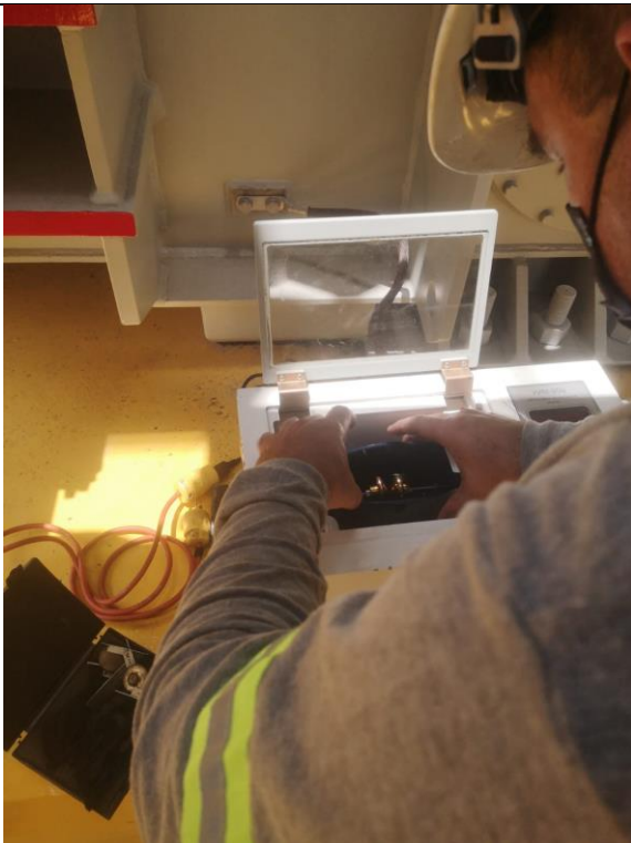
Pruebas dieléctricas en campo
