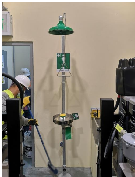
Foto # 6 Instalación de ducha de emergencia
