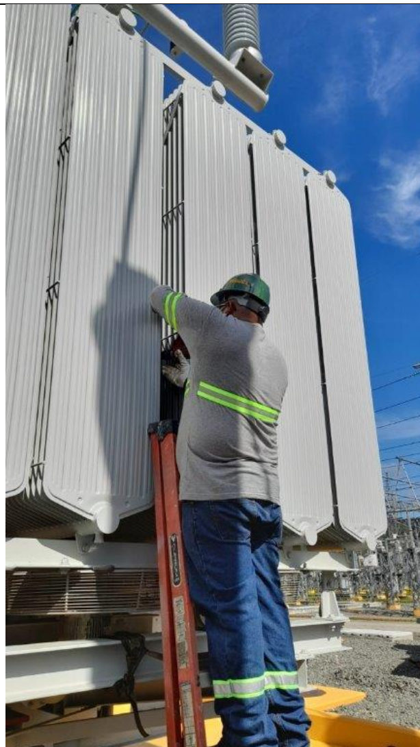
Foto # 2, Reparación de los radiadores
