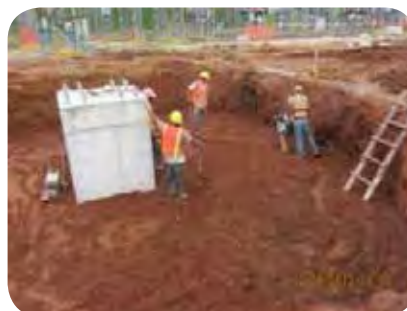
Utilización de equipo de seguridad (cascos, botas, chalecos reflectivos y escalera).
