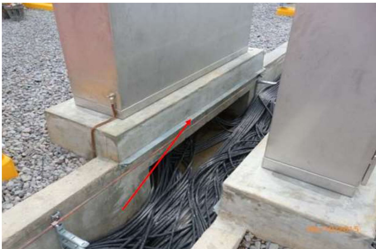
Instalación de ángulos de acero para soporte de tapas especiales de canaletas en patio de 230KV
