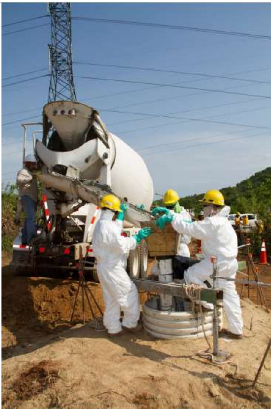
Torre 696 - Vaciado Fundación Tipo Pilote
