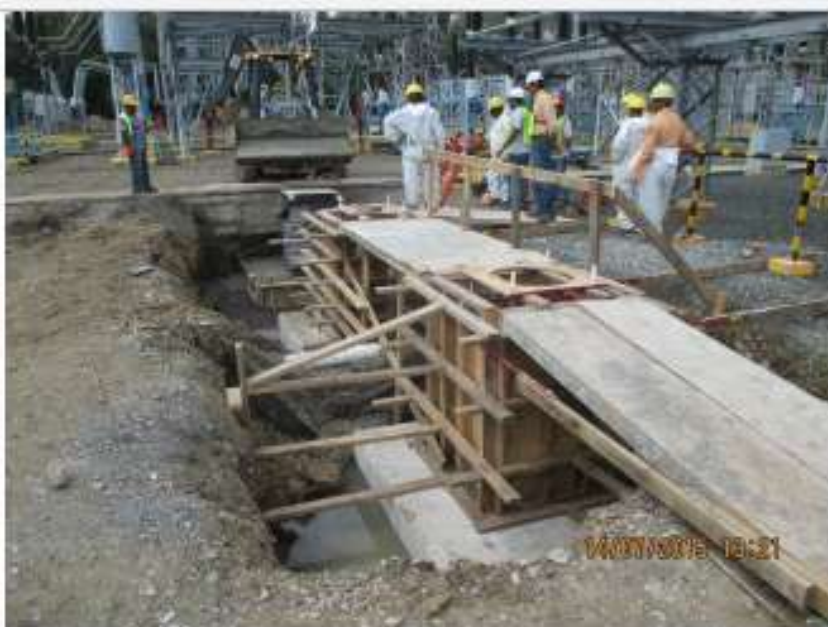
Encofrado de Pedestal de Seccionador Mando Manual h=2.5m - SE Panamá
