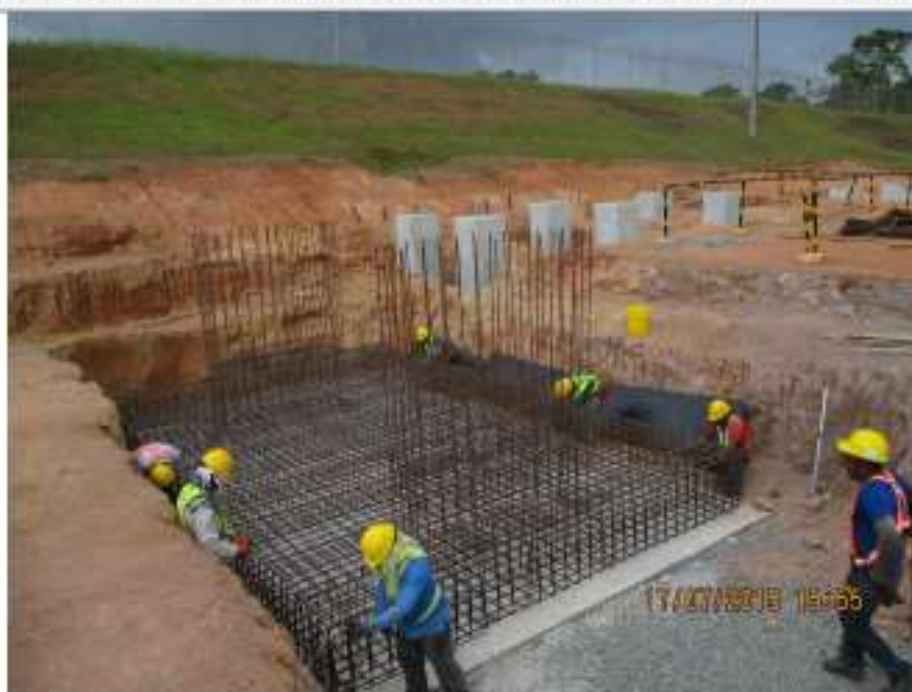
Refuerzo de Zapata de Base de Pórtico – SE Chorrera
