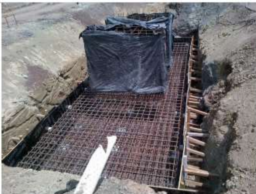
Armado de Acero de Fundación de Pórticos – SE Llano Sánchez
