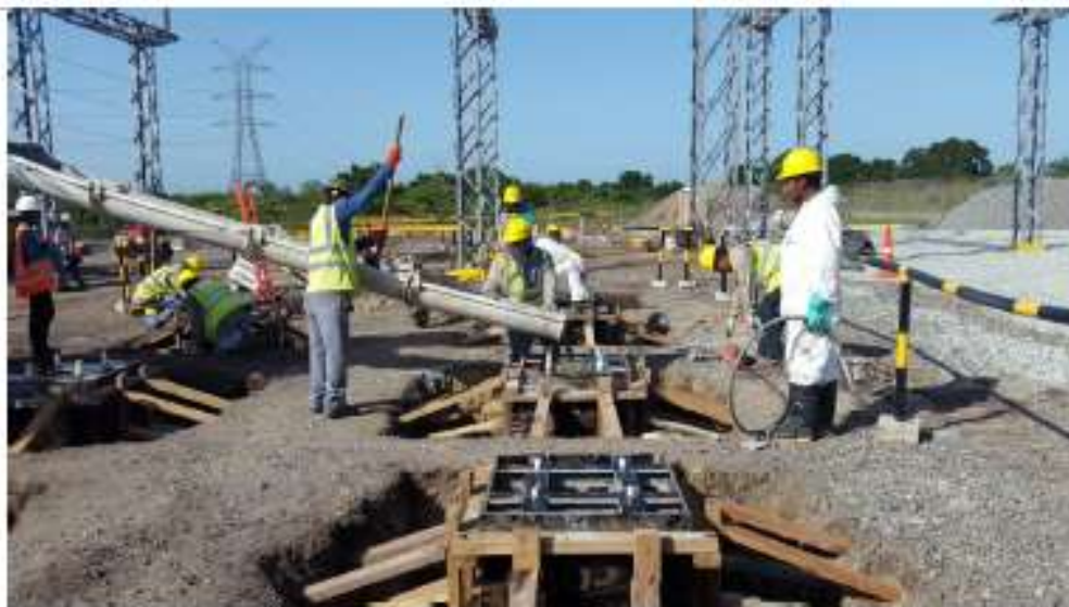
Vaciado de Pedestales - SE Veladero
