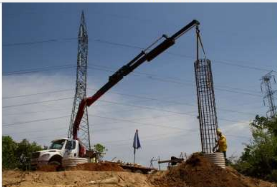
Torre 696 - Instalación de Acero de Refuerzo Pilote
