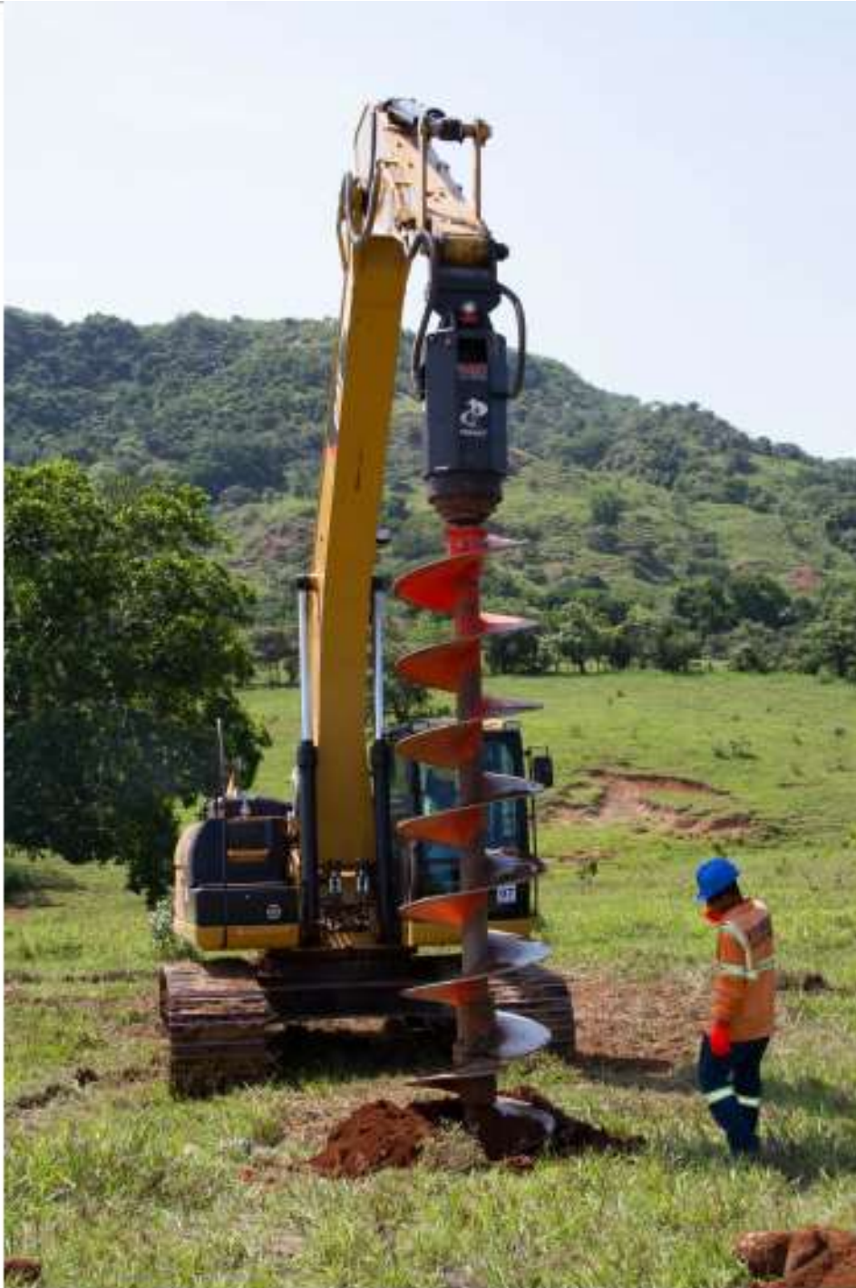
Torre 698 - Excavación de Fundación Tipo Pilote
