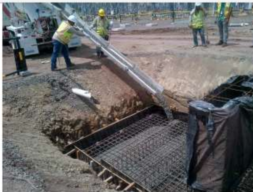
Vaciado de Fundación de Pórticos – SE Llano Sánchez
