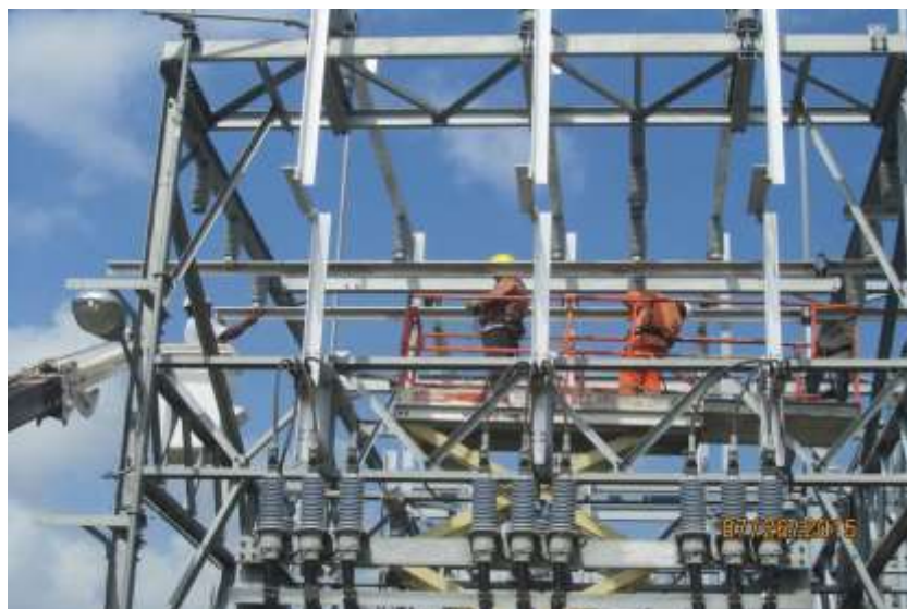
Acople de la barra B con la nueva nave construida para conexión del T3 al patio de 34.5 kV
