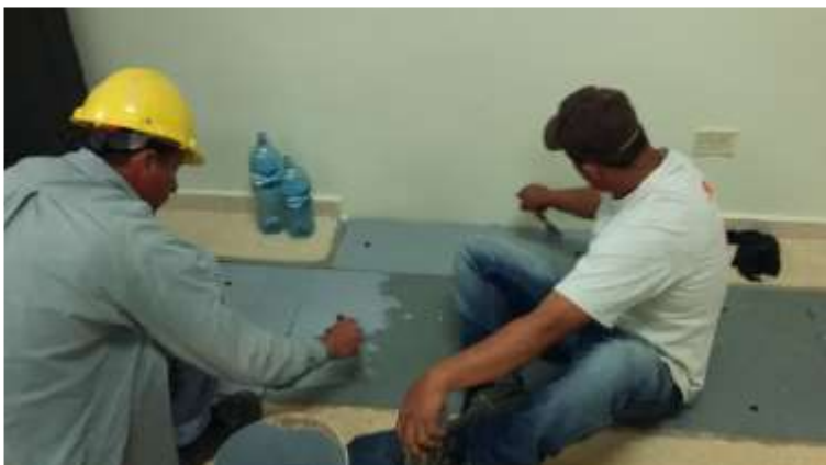
Pintura de Tapas metálicas de Casa Control de la SE San Bartolo
