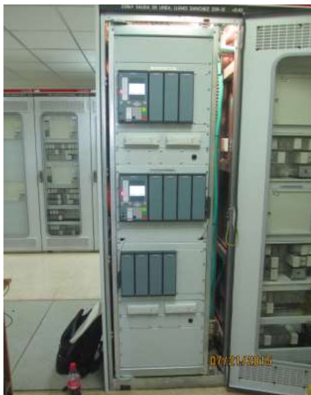
Nueva Protección secundaria de la Línea 230-15 en operación
