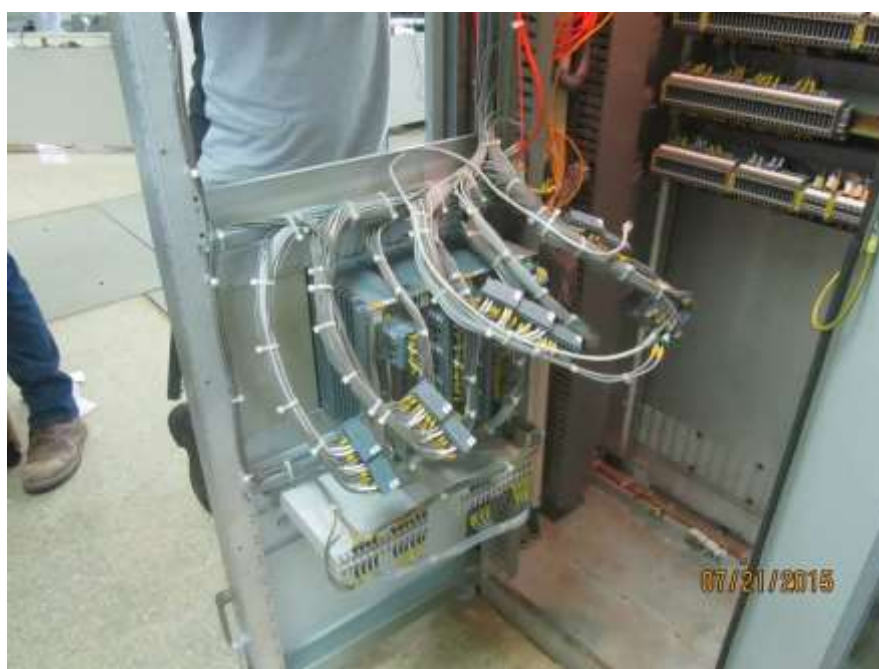
Reemplazo de protección secundaria de la Línea 230-15 que presentó defectos de fábrica
