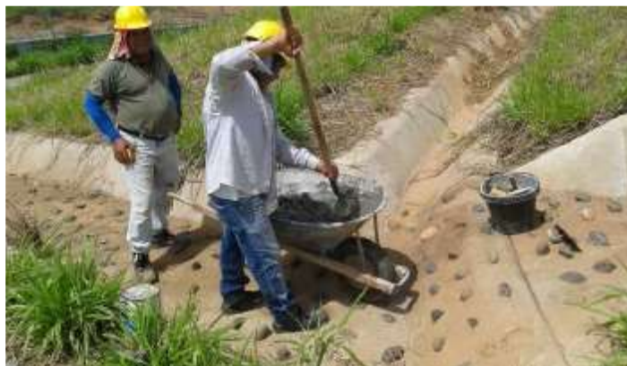
Reparación de drenajes pluviales
