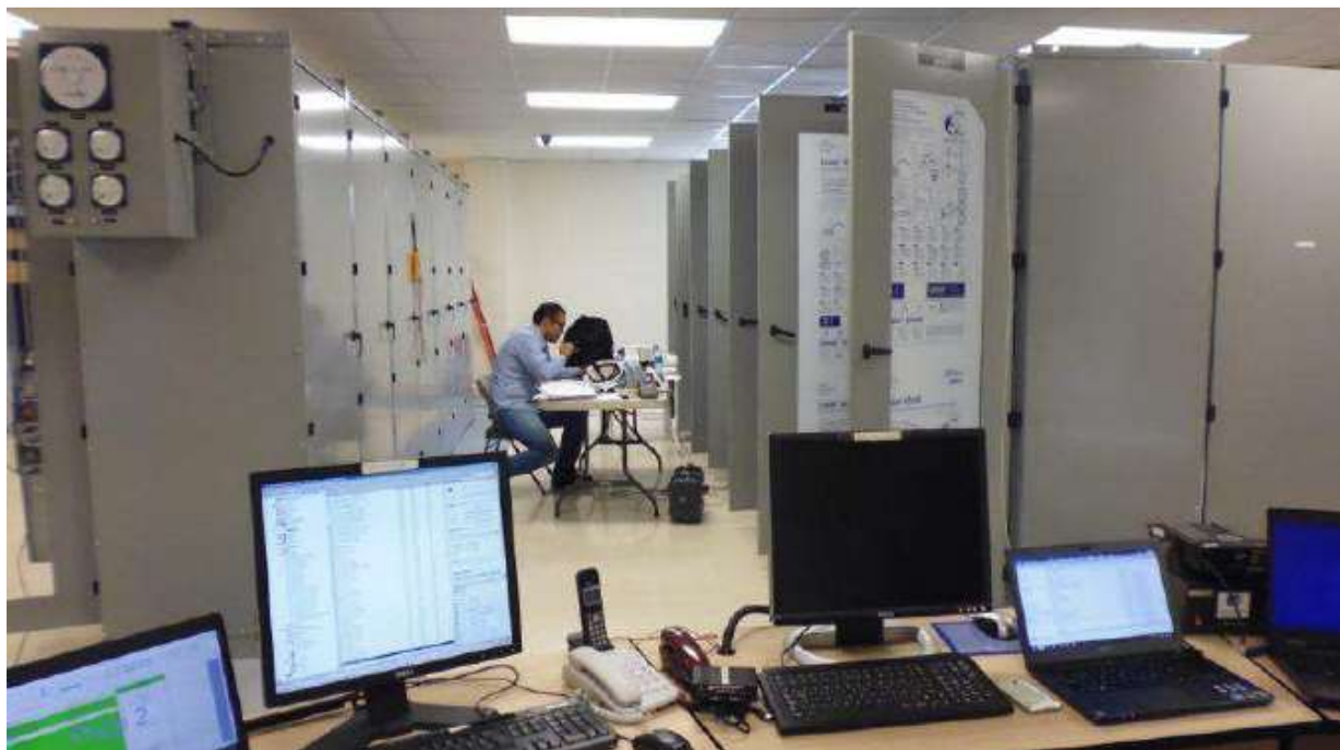
Trabajos de Cableado de control y programación en los tableros nuevos
