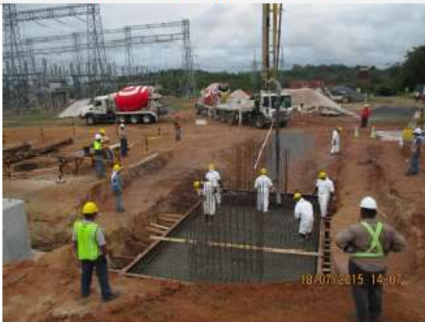
Vaciado de Zapata de Base de Pórticos – SE Chorrera
