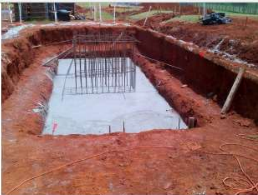
Fundación de Pórticos – SE Veladero
