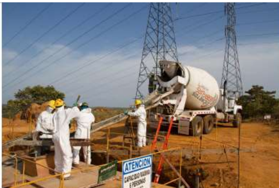
Torre 671 - Vaciado de Fundación Base Zapata
