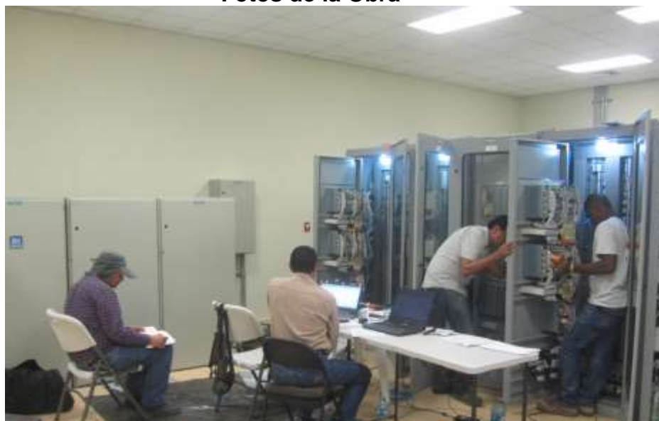
Etapas finales de pruebas previas al comisionado de la Subestación
