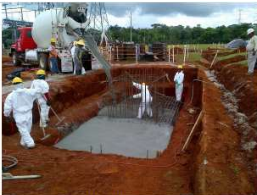
Vaciado de Pórticos - SE Veladero
