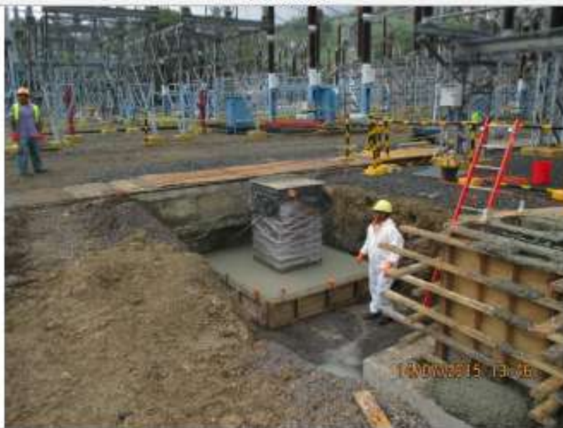
Relleno de Fundación de Pararrayos y Transformador de Potencia - SE Panamá
