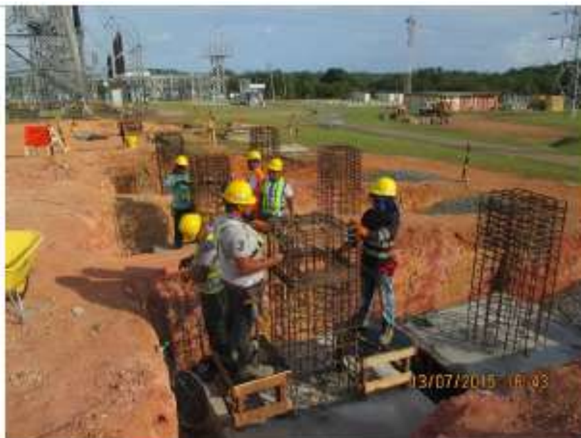
Refuerzo en Pedestal de Transformadores de Potencia – SE Chorrera
