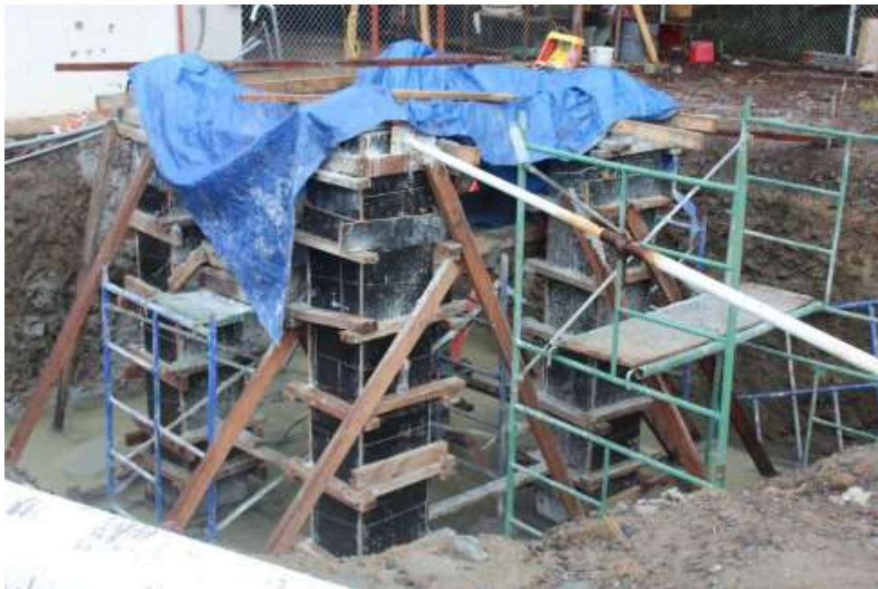
Vaciado de hormigón de los pedestales de la fundación de torre de pórtico 5B
