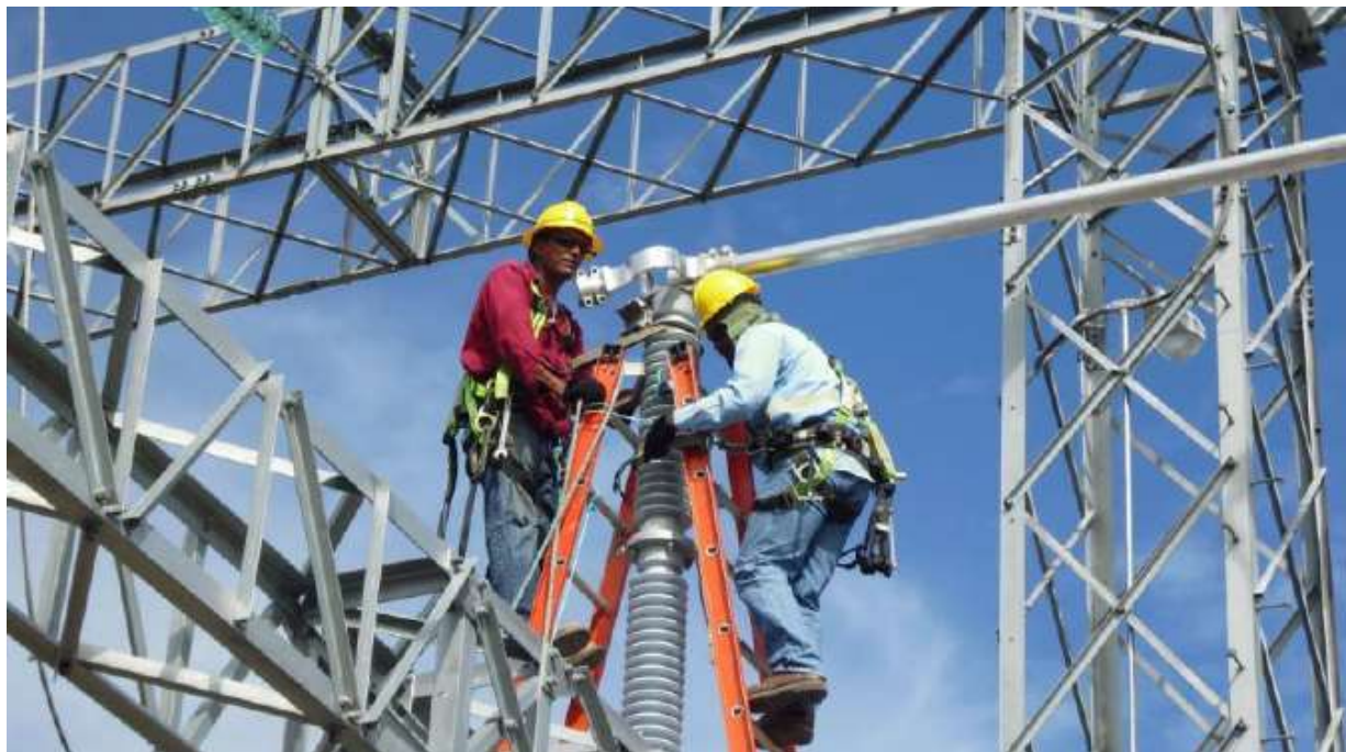
Trabajos en la extensión de la Barra A
