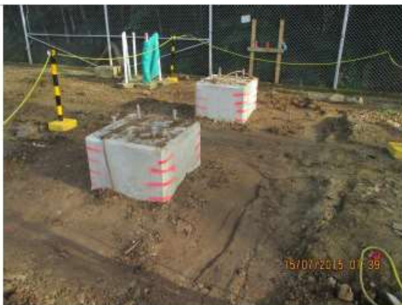
Relleno de Fundación de Pararrayos y Transformador de Potencia - SE Panamá
