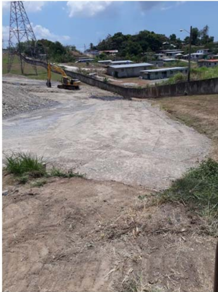
Relleno sobre los ramales de drenaje en la base de la Plataforma C – S/E Panamá 2
