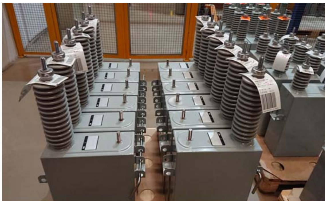
Pastillas de los bancos de capacitores a ser suministradas.
