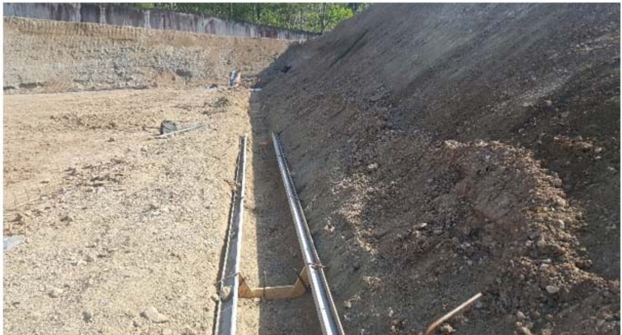
Construcción de cunetas en plataforma A – S/E Panamá 2
