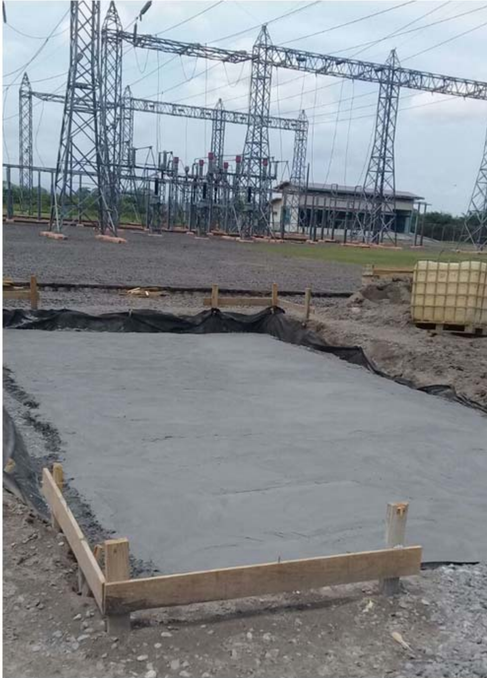
Plataforma temporal del nuevo autotransformador T1 en su fase de finalización, subestación Progreso.
