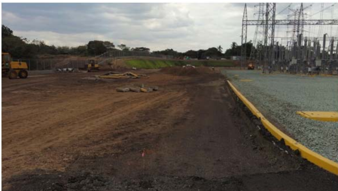
Demolición de cordón de calle existente y movimiento de tierra en área de equipos de Patio – S/E Llano Sánchez
