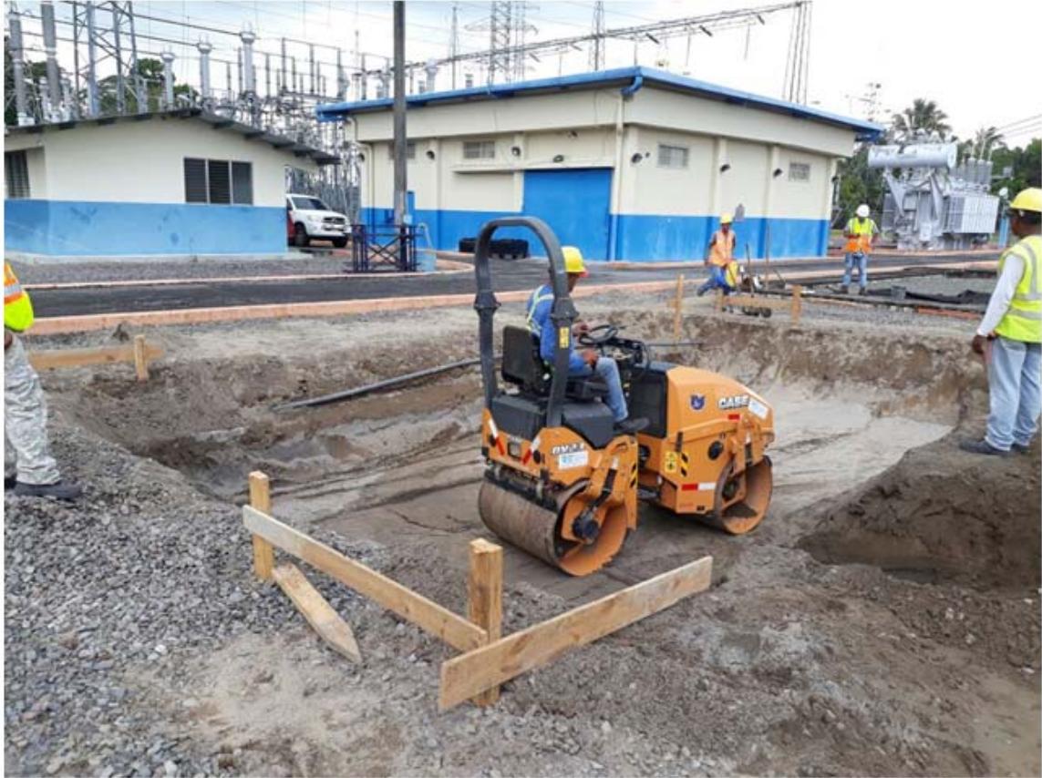
Proceso de compactación de las capas de tierra en la zona de la ubicación de la plataforma temporal del nuevo T1 S/E Progreso.
