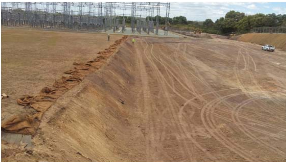
Instalación de manto de control de erosión en taludes de la Plataforma para SVC – S/E Llano Sánchez
