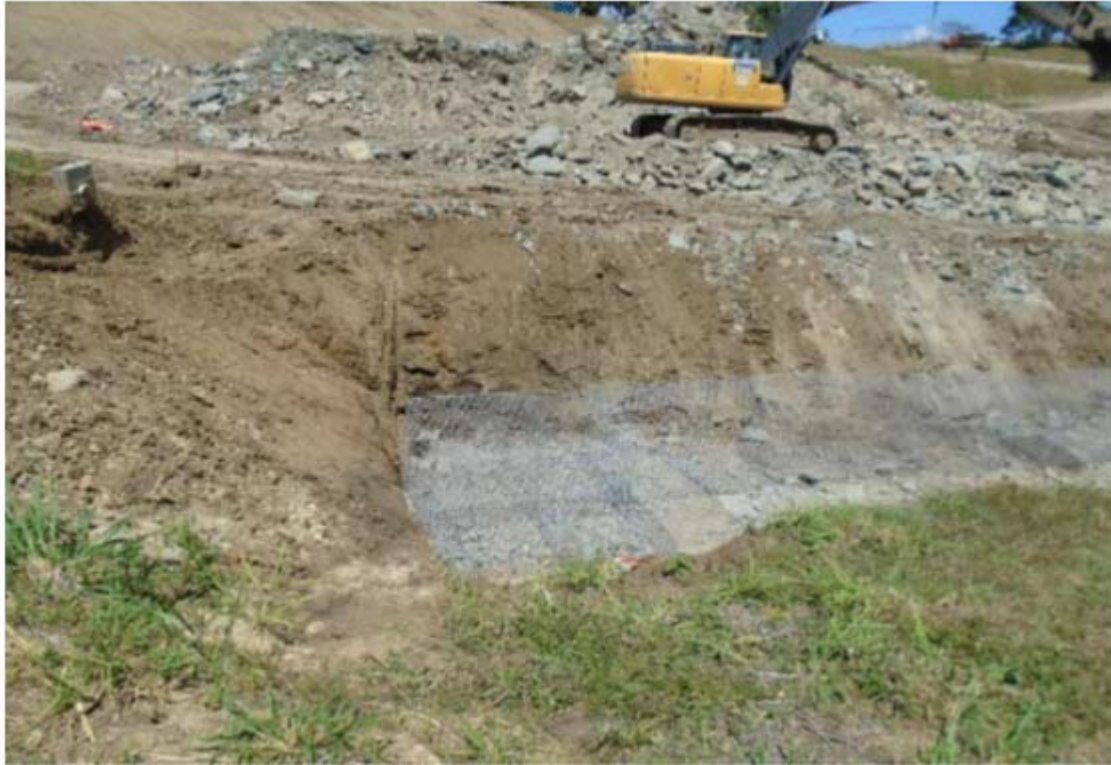
Instalación de gaviones en drenaje de la base de la Plataforma C – S/E Panamá 2
