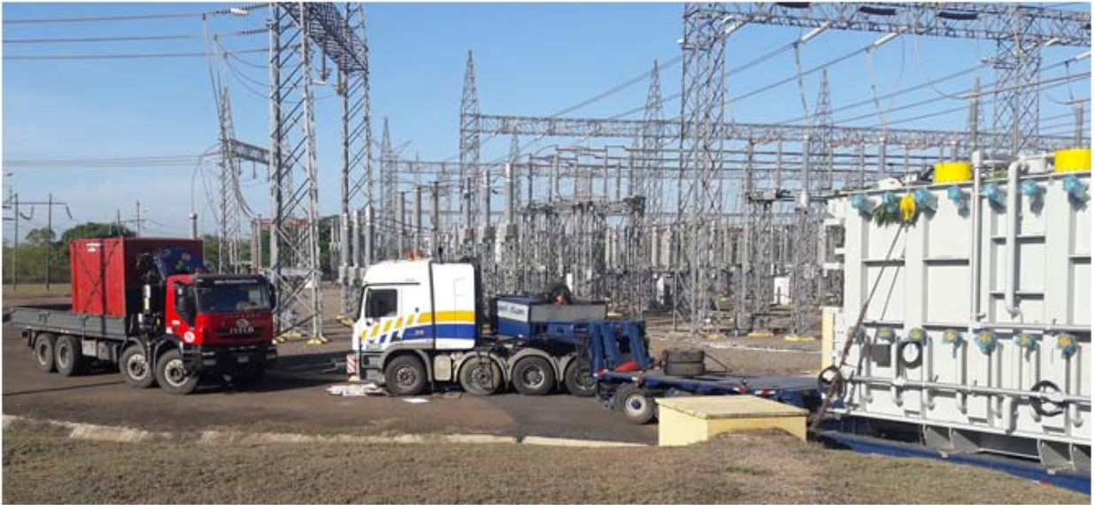
Vehículos circulando dentro de la subestación Llano Sánchez, en su camino a ubicar el transformador en la plataforma temporal.
