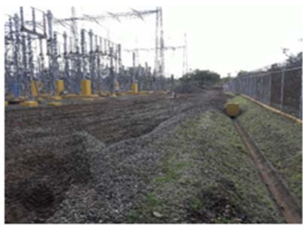
Trabajos de movimiento de tierra y remoción de piedra.
