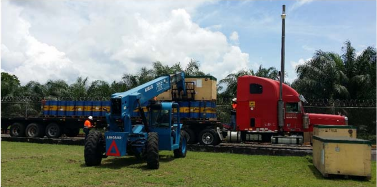
Camiones que transportaban tanques contenedores de aceite y cajas de equipos especiales siendo descargados dentro de la subestación Progreso.
