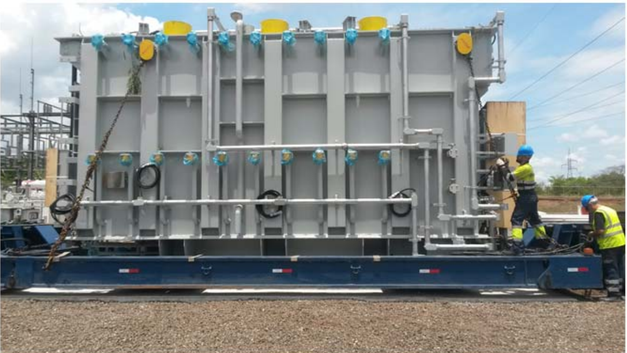
Proceso de descarga del nuevo autotransformador T2 de la Subestación Llano Sánchez
