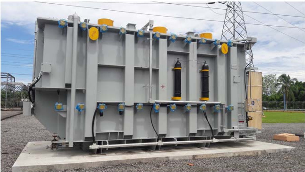
Autotransformador T1 de la Subestación Progreso en su plataforma temporal.
