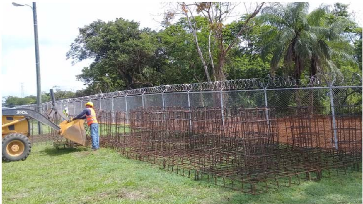
Acopio del acero en la subestación
