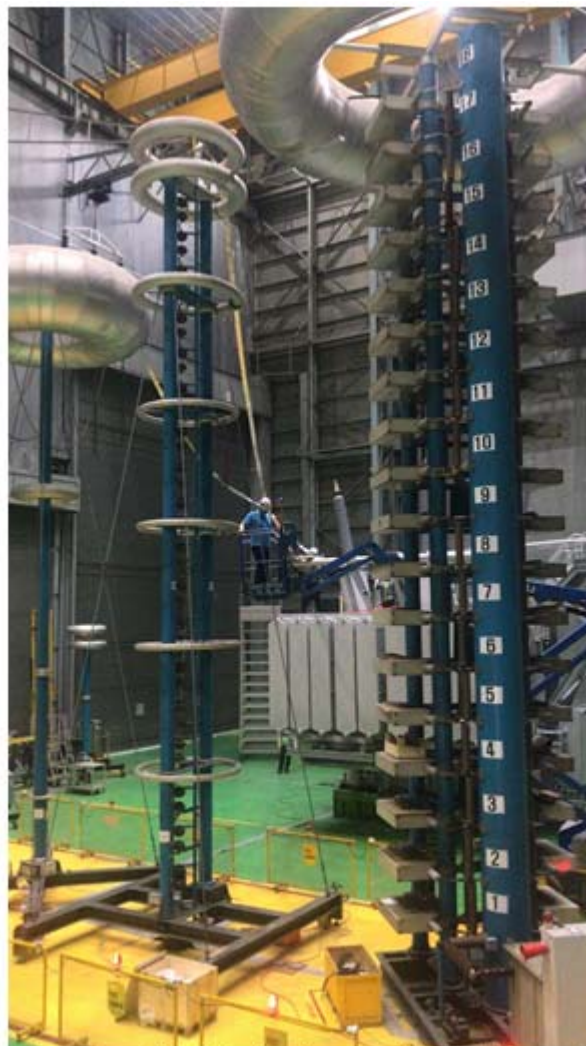
Preparación para una de las pruebas en fábrica de los Transformadores de Acople del proyecto del STATCOM, las cuales contaron con personal de ETESA, que cumplió con la función de testigos de las mismas.
