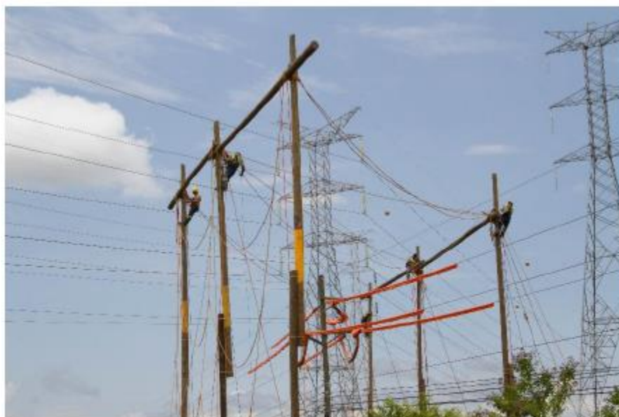
Colocacion de Portico para proteccion de Lineas de Distribucion
