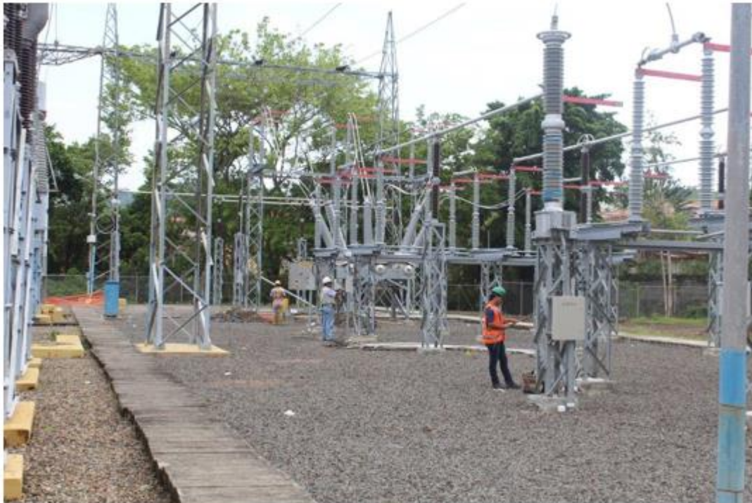
Preparación de los cables para el conexionado en Bahía 6, Patio de 230 kV
