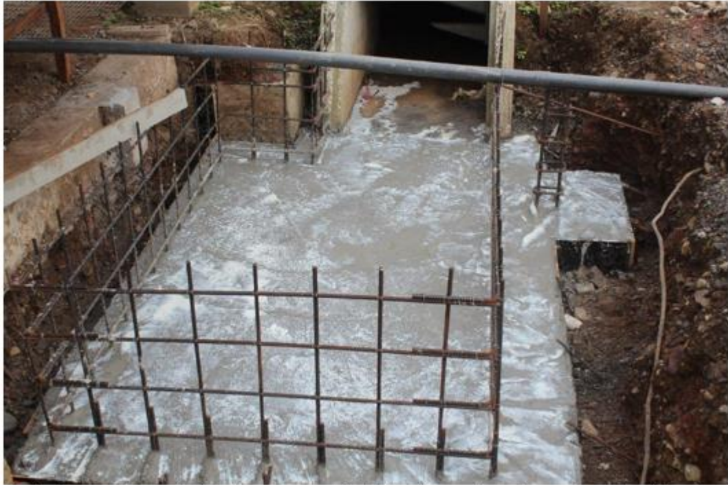
Vaciado de la losa de piso de la cámara entre el shelter de 115 kV y la canaleta de cables de 115 kV
