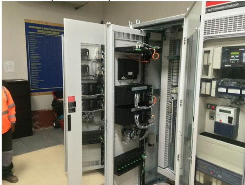
Instalación de los paneles de Control y Protección.
