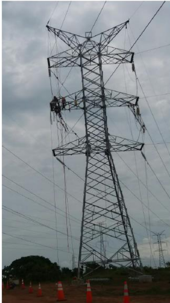
Tendido de Cables – Torres 510-07
