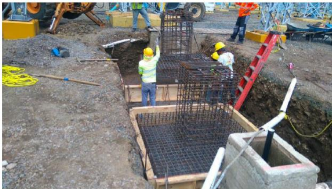
Instalación de Armadura de Acero Instalación de Tubería Iluminación NAVE3
