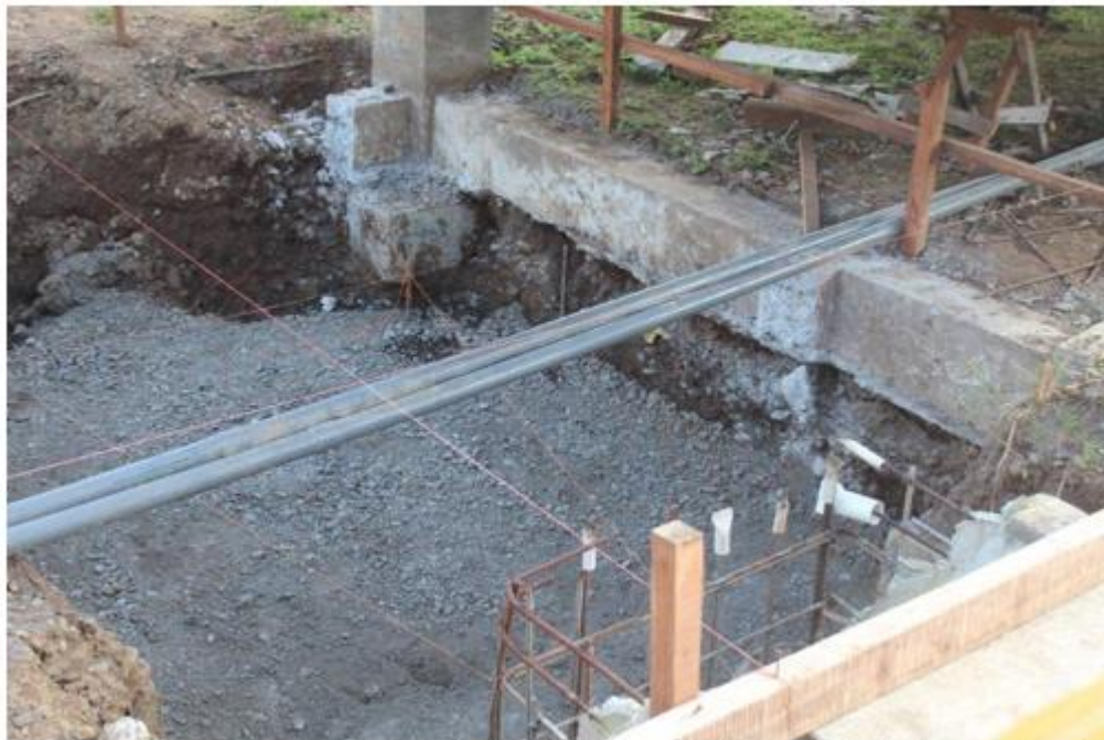
Preparación del fondo para vaciado del piso de la cámara de mantenimiento para los shelters
