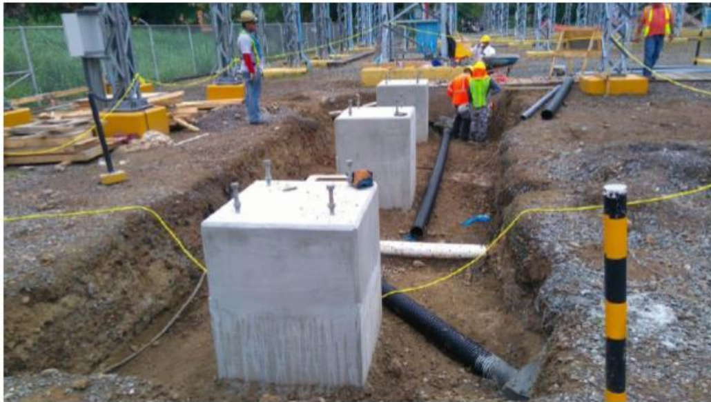
Instalación de Tubería de Iluminación Nave 3
