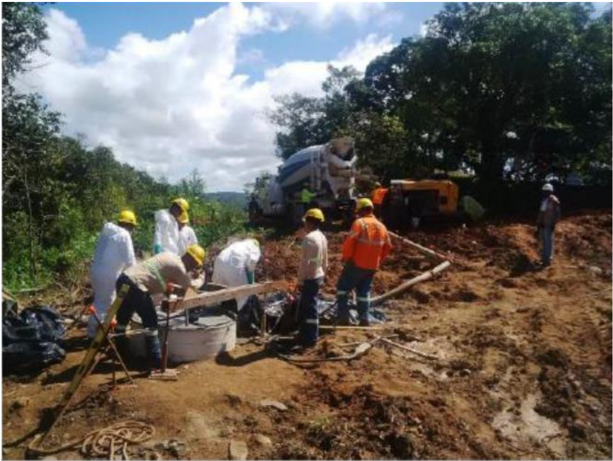
Vaciado de Pilote – Torre 779
