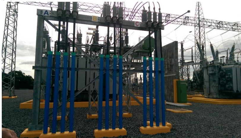
Vista del transformador T2 energizado
