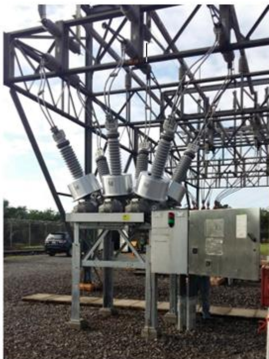
Vista en detalle de uno de los interruptores del proyecto.
