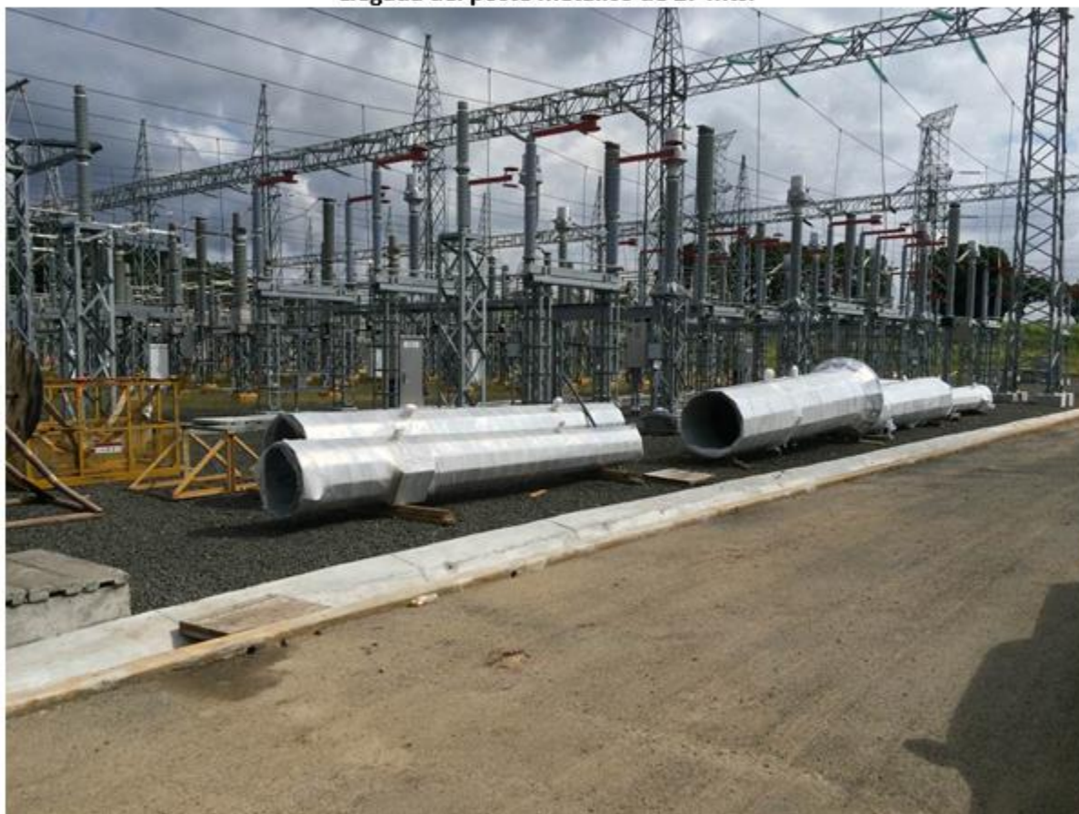
Llegada del poste metálico de 27 mts.
