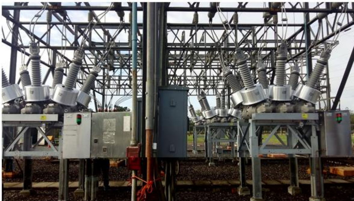
Vista Panorámica de Patio de 34.5 kV, 5 Interruptores en servicio.
