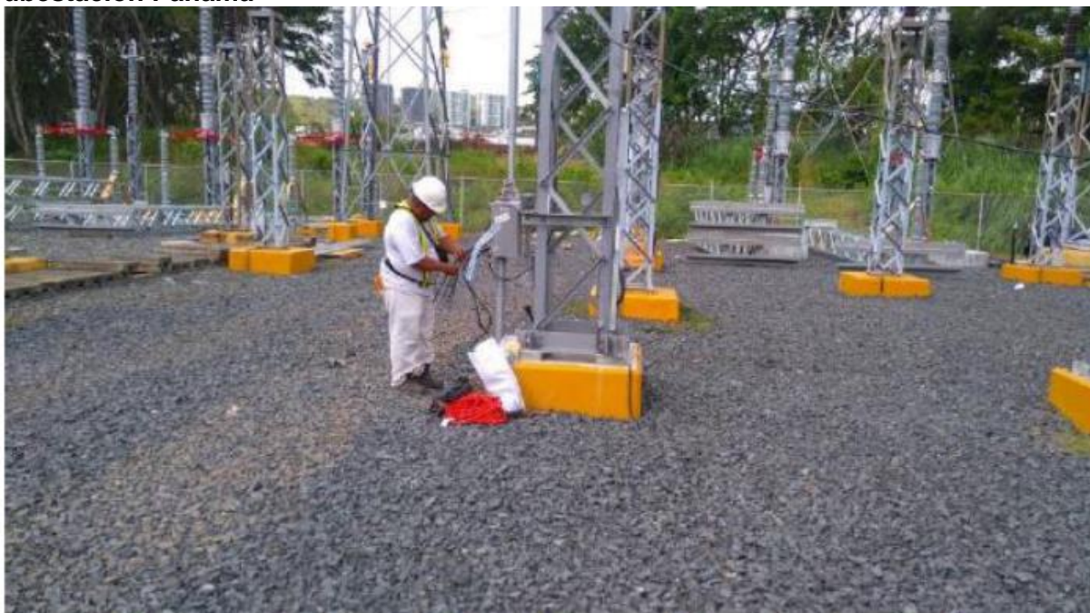
Conexión a Equipos de patio y cajas MK - SE Panamá
