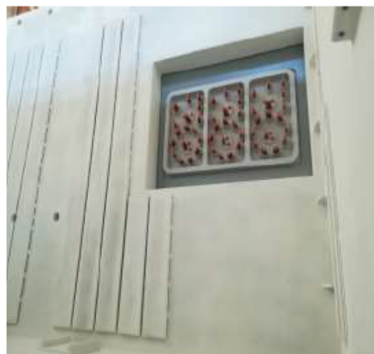
Imagen 4. Puntos de conexión del LTC
