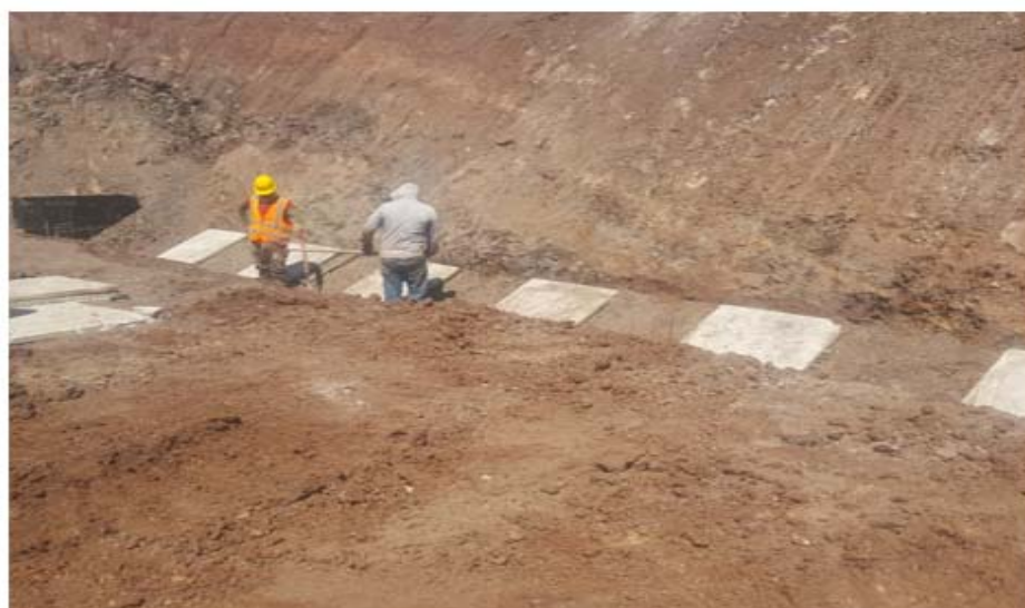
Construcción de revestimiento de cunetas pluviales – S/E Llano Sánchez
