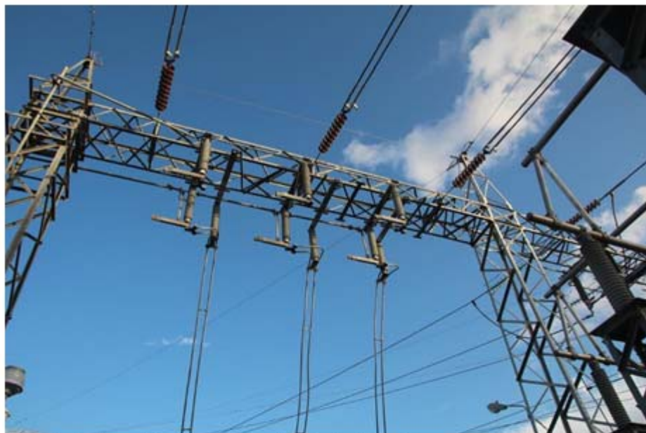
Montaje de la cuchilla seccionadora horizontal invertida en Bahía 7 – Patio de 115 kV
