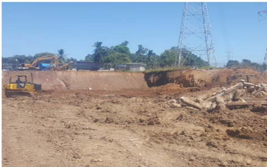
Remoción de material contaminado y restos de la cerca existente – S/E Llano Sánchez
