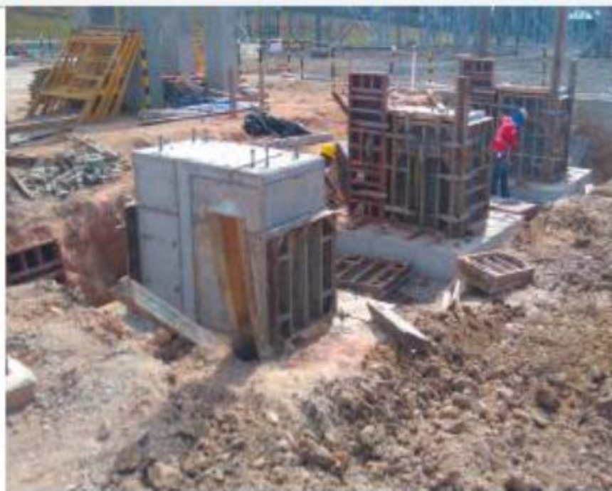
Desencofrado de Pedestal – Cuchilla Seccionadora – SE Chorrera
