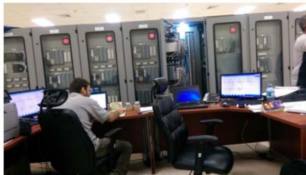
Ajustes configuración de los relés de protección
