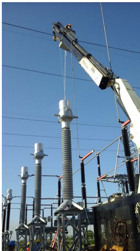
Retiro de las bajantes asociadas a las cuchillas seccionadoras
