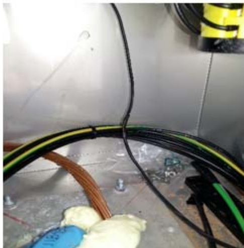
Sellado de Tuberías con material para evitar que la humedad se meta a los equipos.
