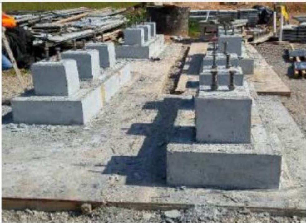
Desencofrado de pedestales – SE Chorrera
