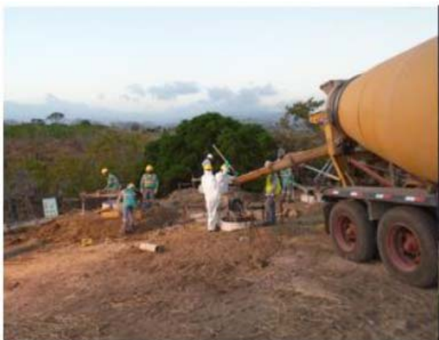
Vaciado de pilotes torre 254
