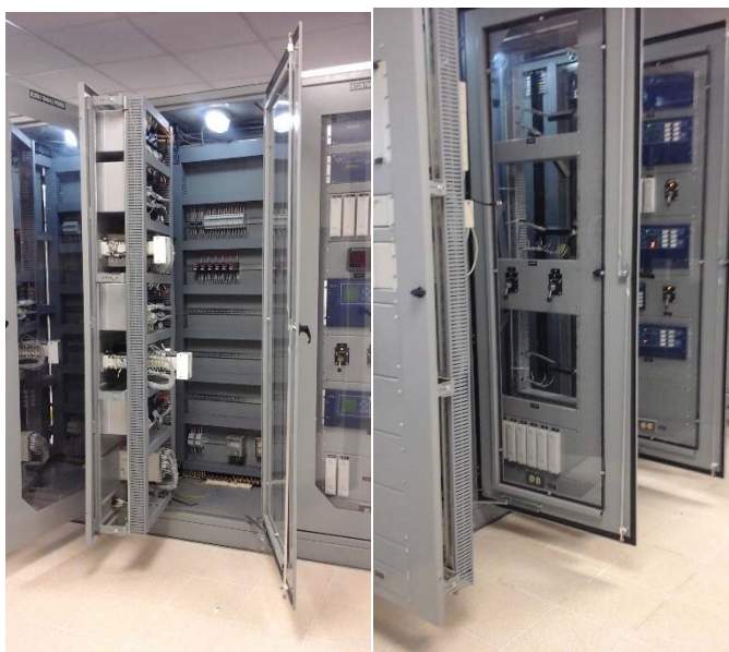
Configuración de las protecciones diferencial primaria y secundarios del Transformador 1
