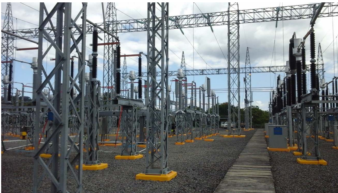
Retiro de los puentes en la Nave asociada al Transformador T1
