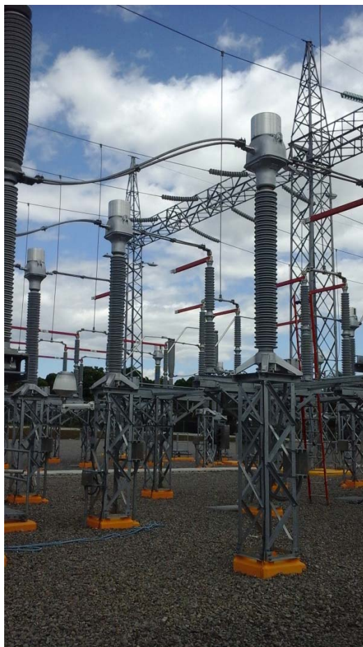
Instalación de los Transformadores de Corriente asociados al interruptor 23B22
