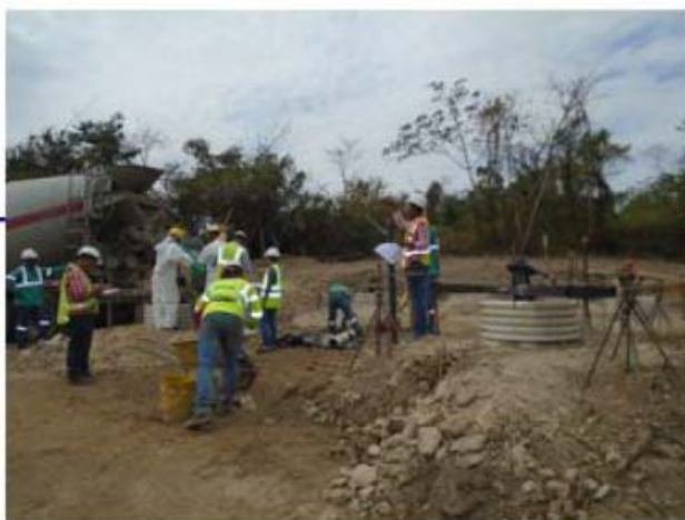
Vaciado de pilotes torre 256
