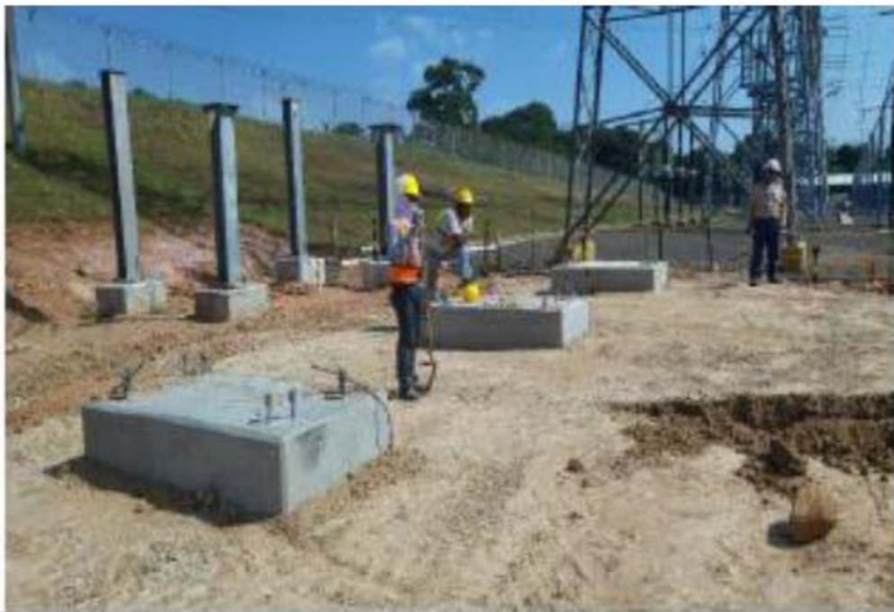
Relleno y compactación – Cuchillas seccionadoras – SE Chorrera
