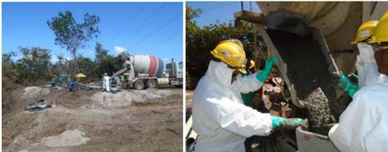
Vaciado de bases tipo pilotes A,B,C,D, en construcción de torre 278
