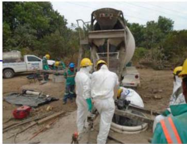
Vaciado de pilotes torre 256
