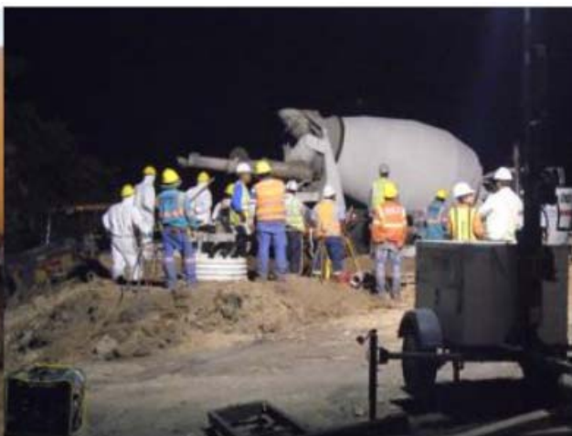
Vaciado de pilotes torre 254
