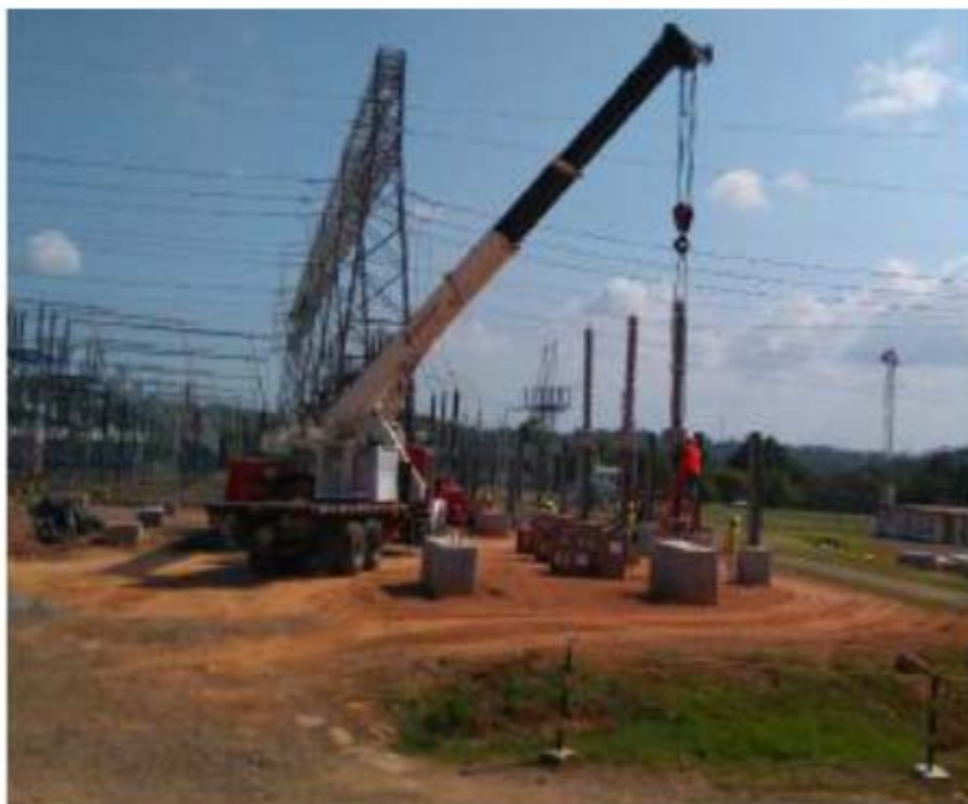
Montaje de Equipo – Transformador de Potencial– SE Chorrera
