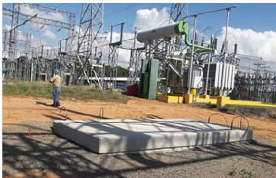
Base construida del Autotransformador T2 SE Chorrera
