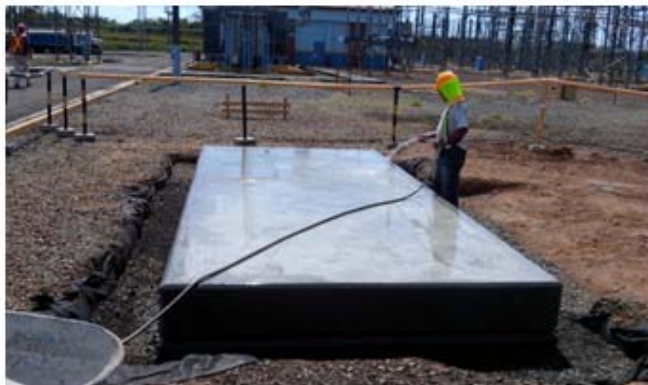
Base construida del Autotransformador T1 SE Llano Sánchez
