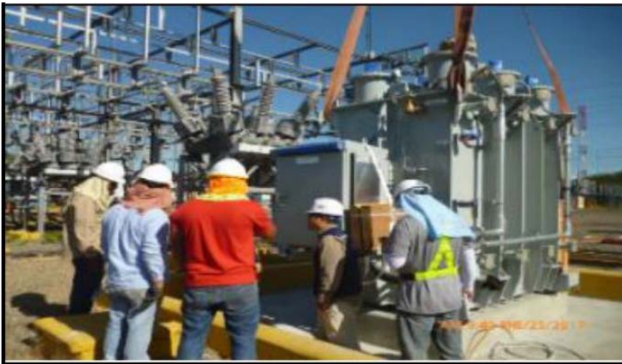
9.1 Montaje del Reactor R1 en presencia del Técnico de Fabrica.
