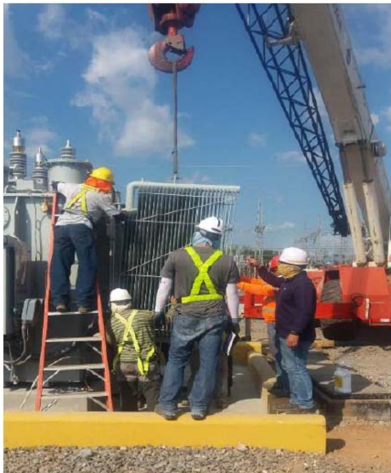
9.2 Montaje del Radiador
