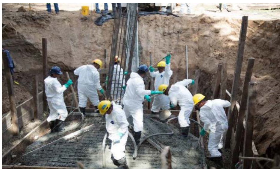
Vaciado de bases – Torre 411
