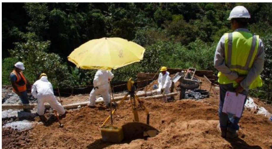
Vaciado de Pilote – Torre 801
