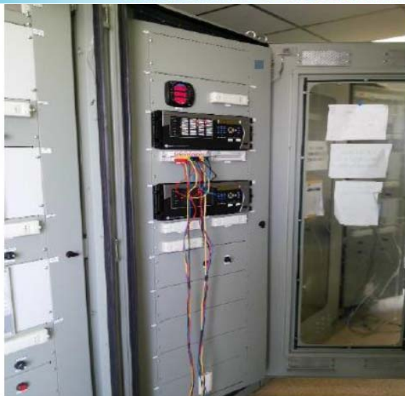
Pruebas al Relé de Protección – SE Llano Sánchez
