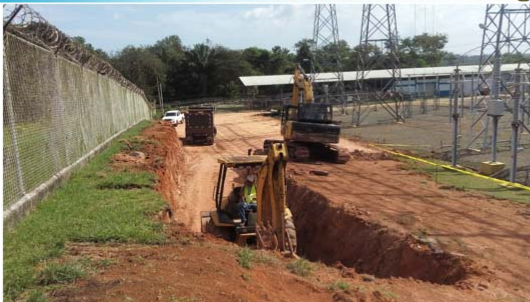
Excavación del globo A – S/E Chorrera
