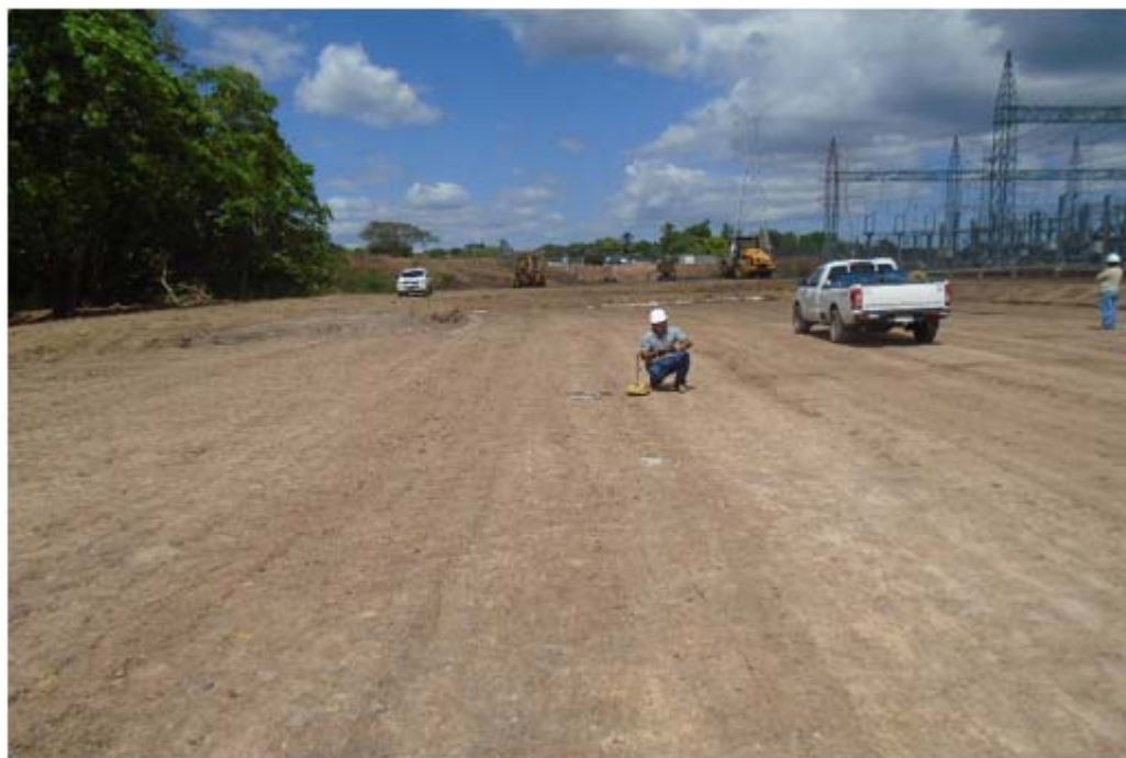
Prueba de compactación en plataforma para equipos de Patio – S/E Llano Sánchez
