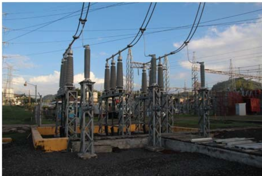
Cables de la bajante de la cuchilla horizontal invertida instalados y conectados.
