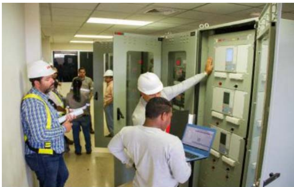
Energización – SE Veladero – Llano Sánchez
