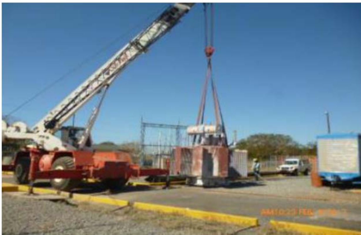
Remoción del Reactor R2 existente.
