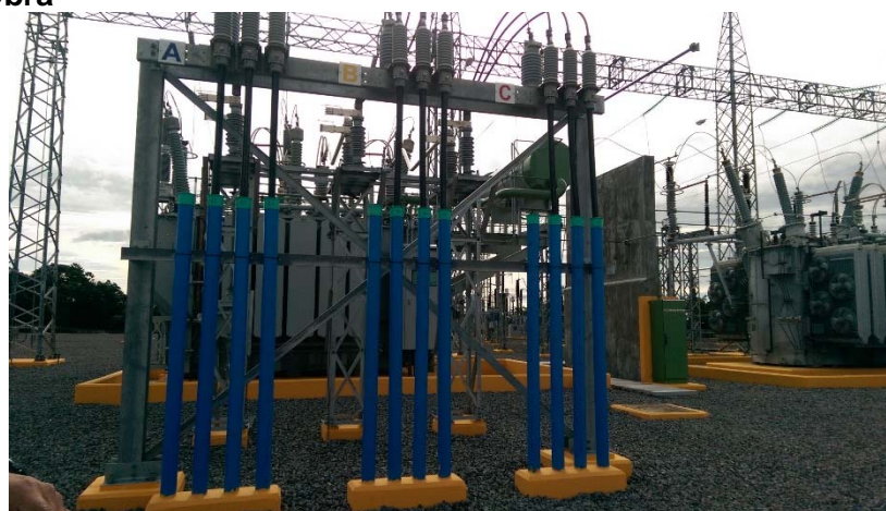
Vista del transformador T2 energizado
