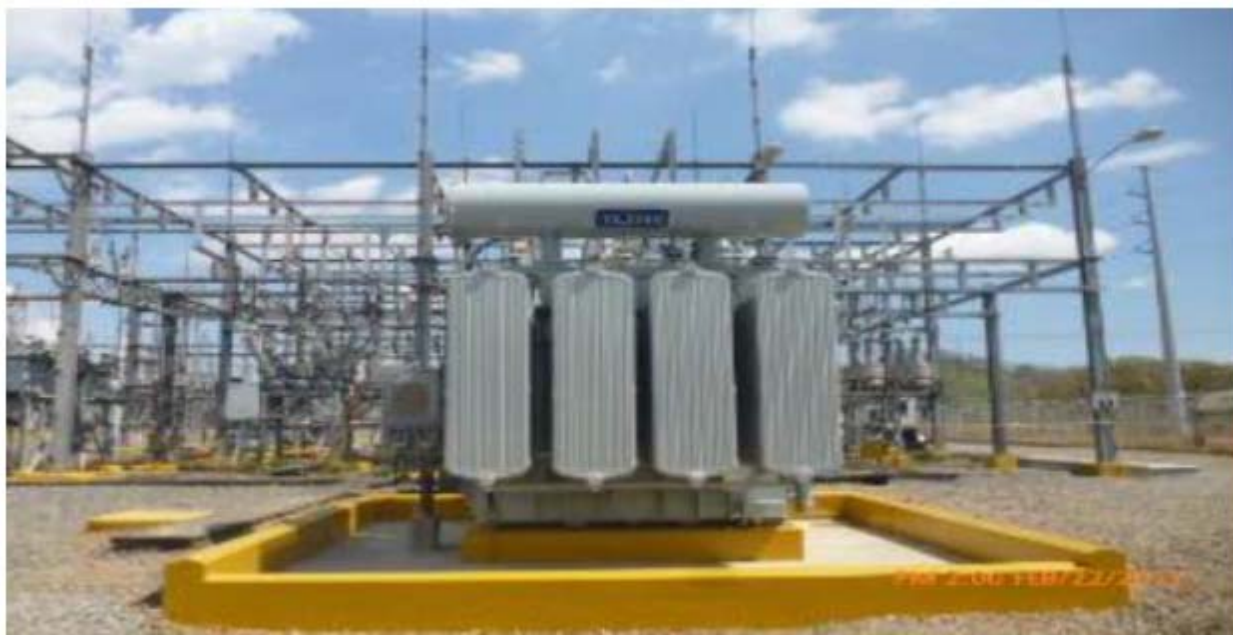
Reactor R2 energizado.
