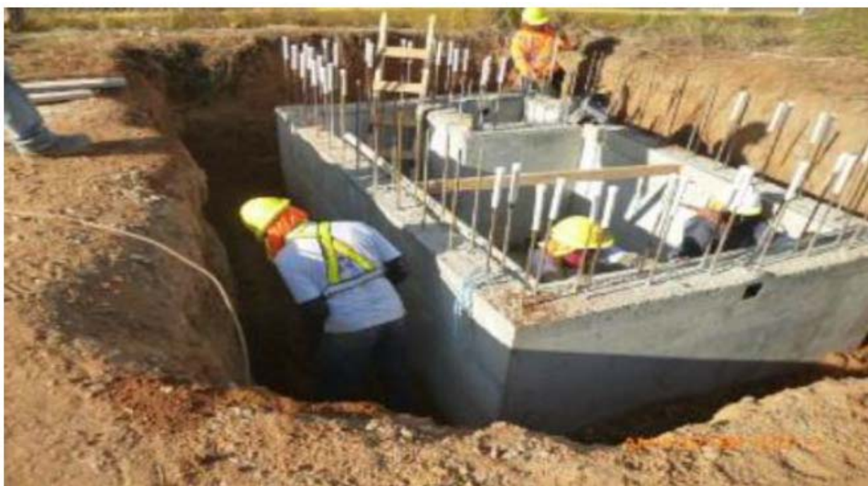
Relleno con material en el área del tanque recolector de aceite.
