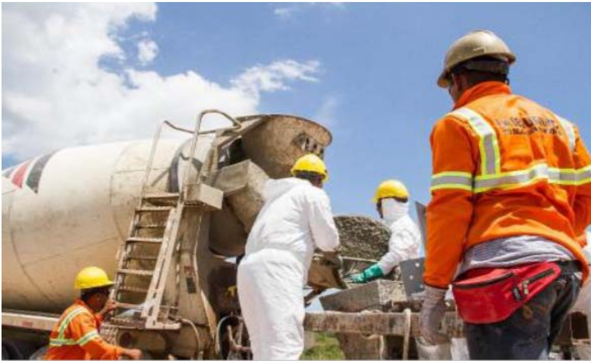
Vaciado de Pilote – Torre 290-1
