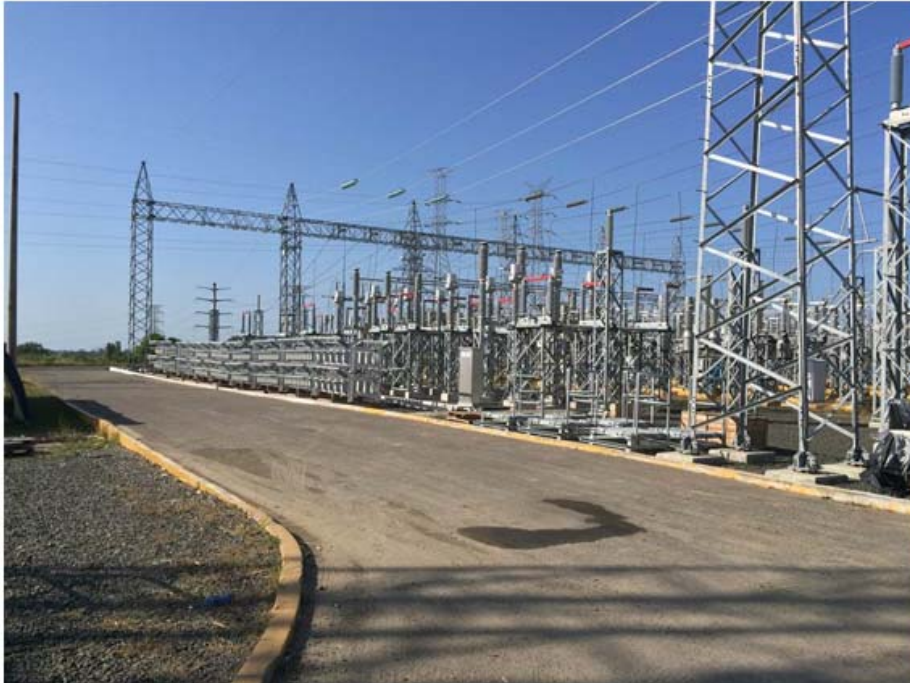
Patio de 115 kV
