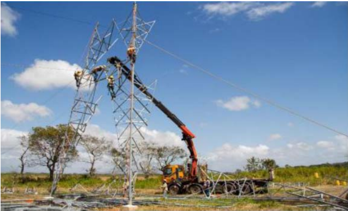
Montaje - Torre 461 (TXS2)
