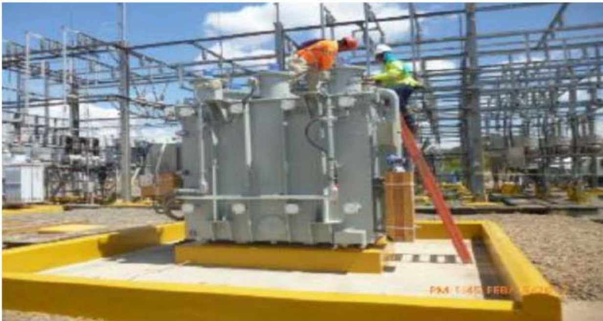
Montaje del nuevo reactor R2.
