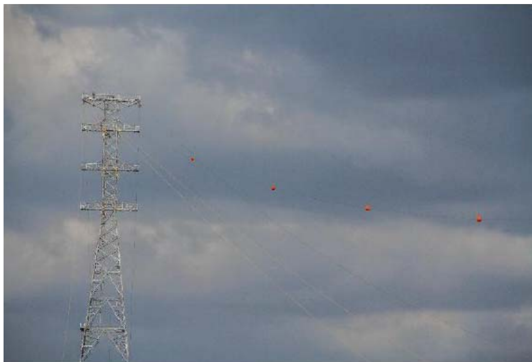
Balizas en el Cruce del Canal – Tramo 3
