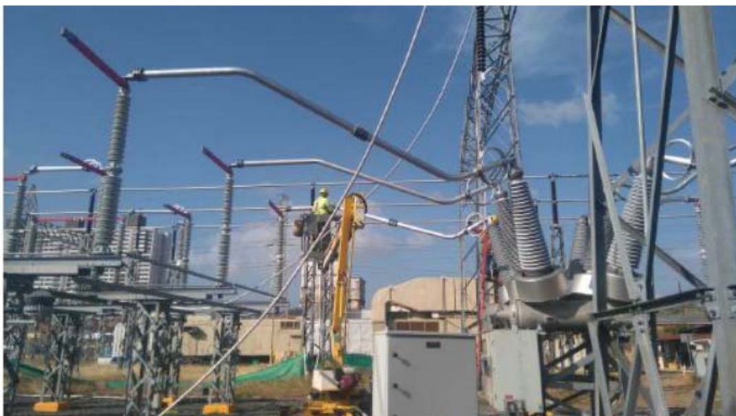
Montaje de Barras Aéreas para Conexión de Barra "B"- SE Panamá
