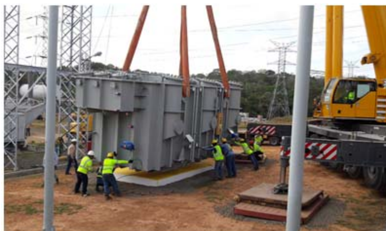
Colocación del Autotransformador T2 sobre su base en SE Chorrera
