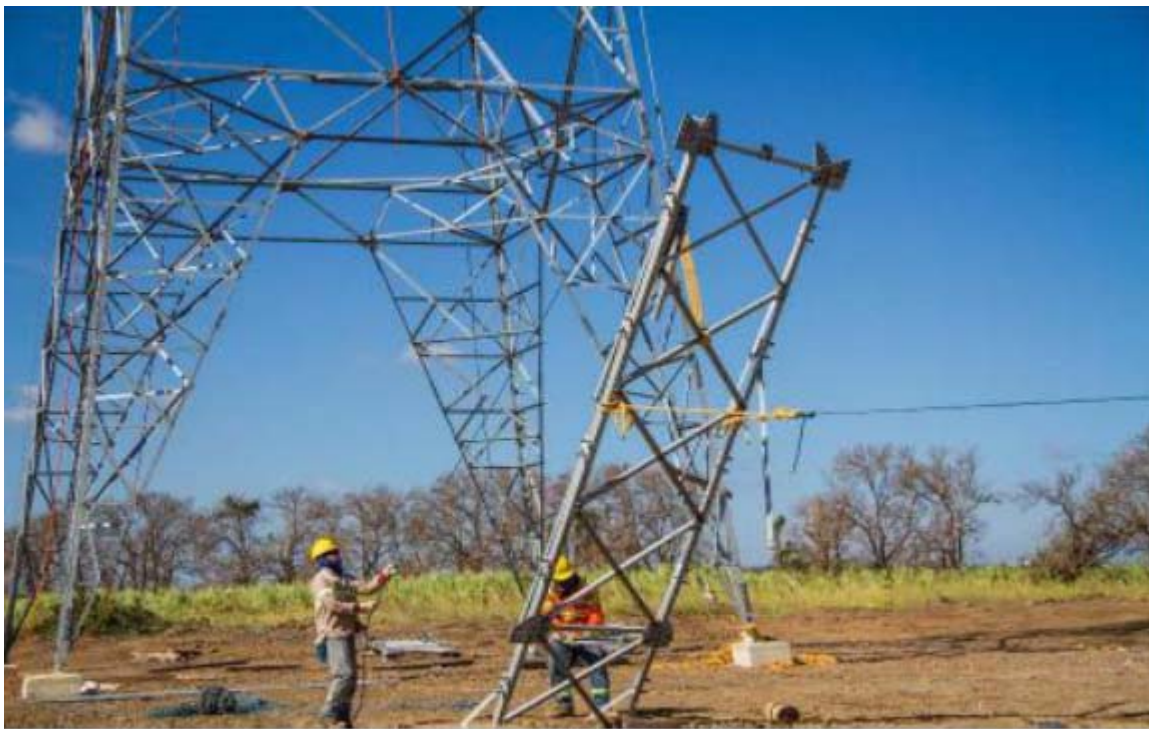
Montaje - Torre 466 (TXS2)
