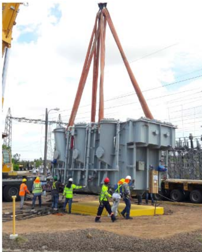
Colocación del Autotransformador T1 sobre su base en SE Llano Sánchez
