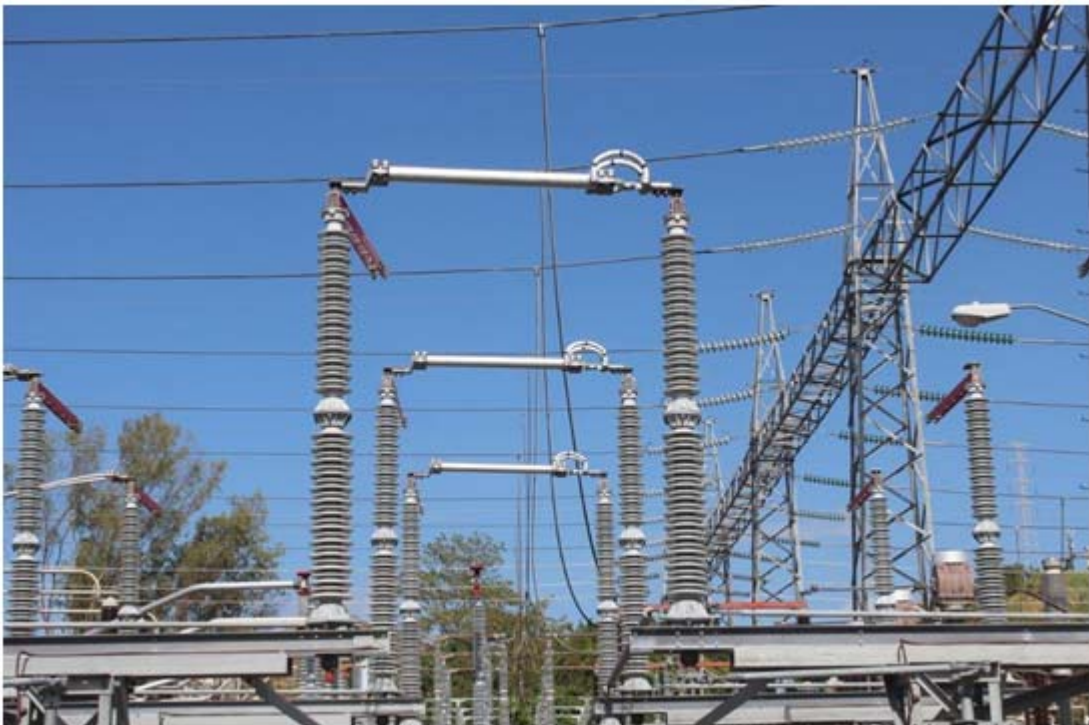
Montaje de tubería de la Barra Secundaria en la Bahía 4 del Patio de 230 kV
