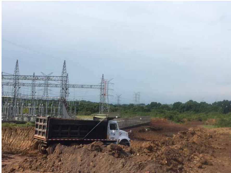
Remoción de material excavado
