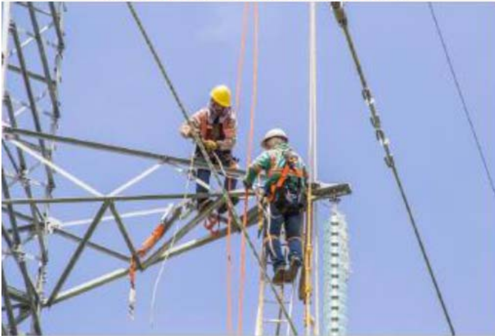
Actividad de Tendido – Tramo 2
