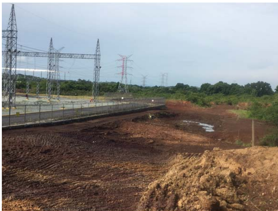
Avance de la limpieza y desarraigue del área de la bahía
