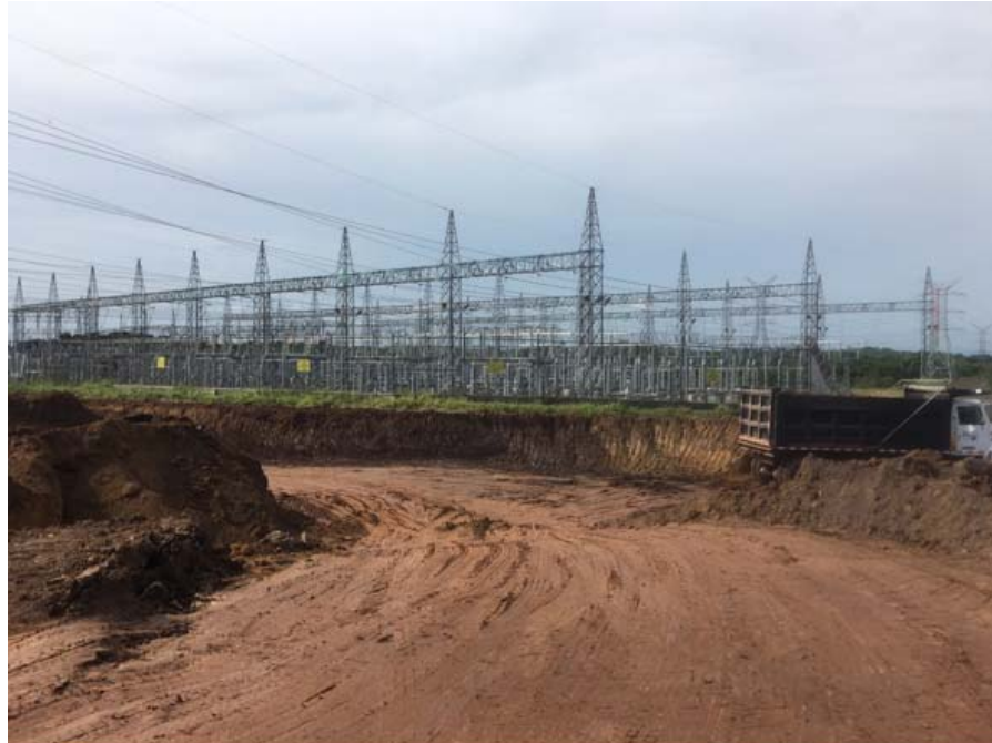
Avance de excavación del área de los SVC
