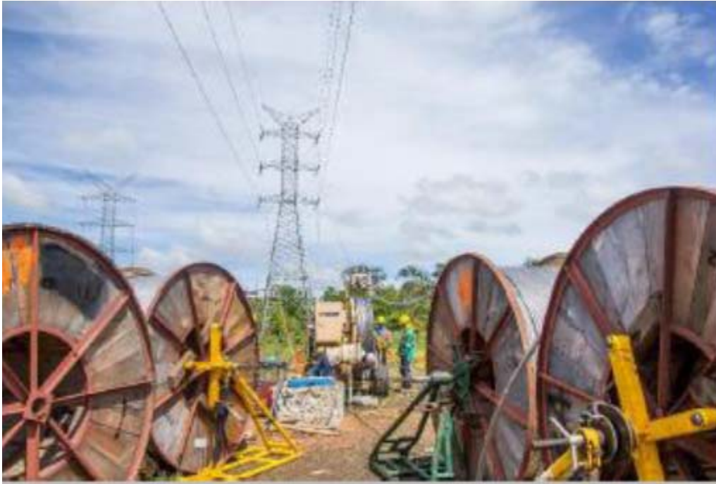
Actividad de Tendido – Tramo 2
