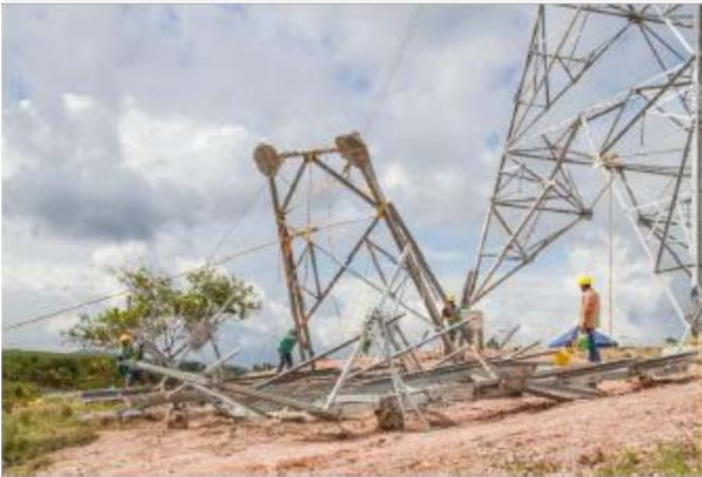
Montaje – Torre 290-1 (TXAT)
