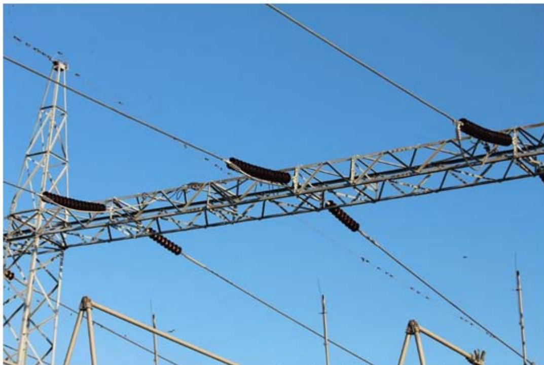
Montaje de la Barra Aérea en la Bahía 4 del Patio de 230 kV
