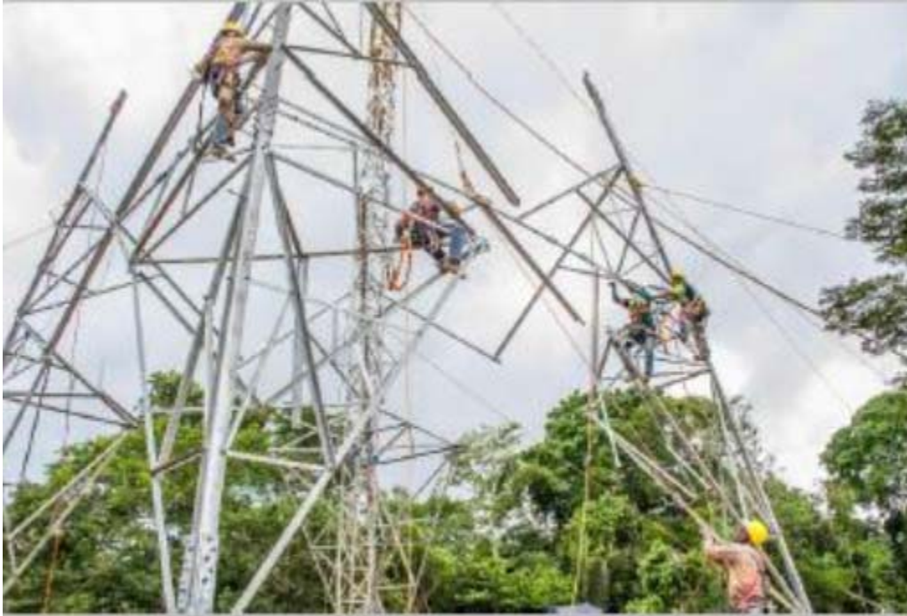
Montaje - Torre 105 (TXA1)
