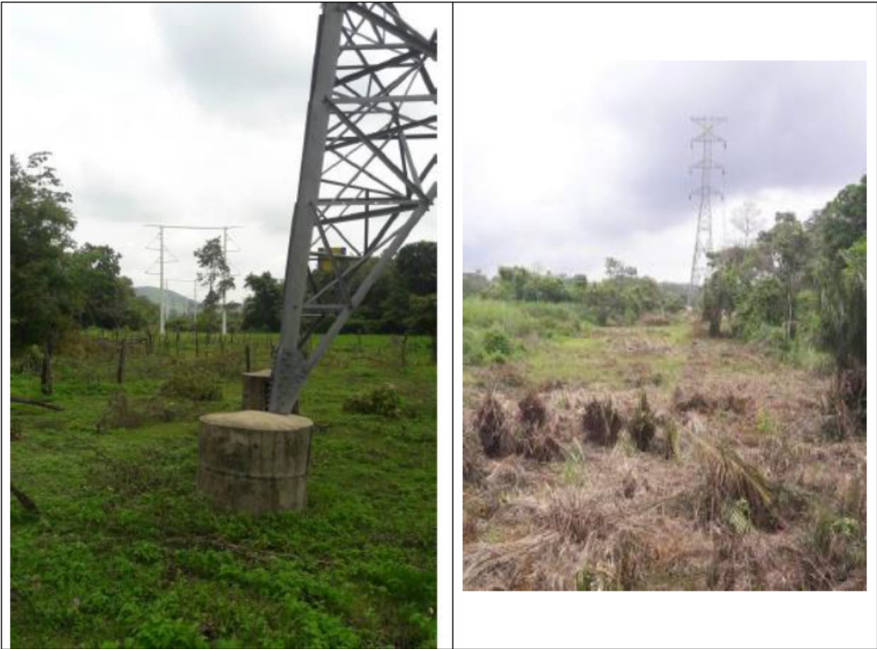
Despeje de franja de servidumbre. LT 230Kv.
