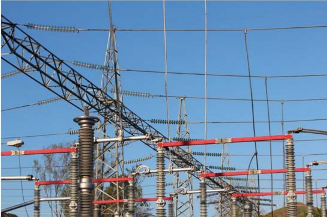
Montaje de las bajantes en la Bahía 4 del Patio de 230 kV
