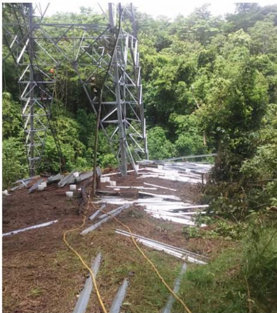
Ilustración 1 MONTAJE DE LA TORRE 117
