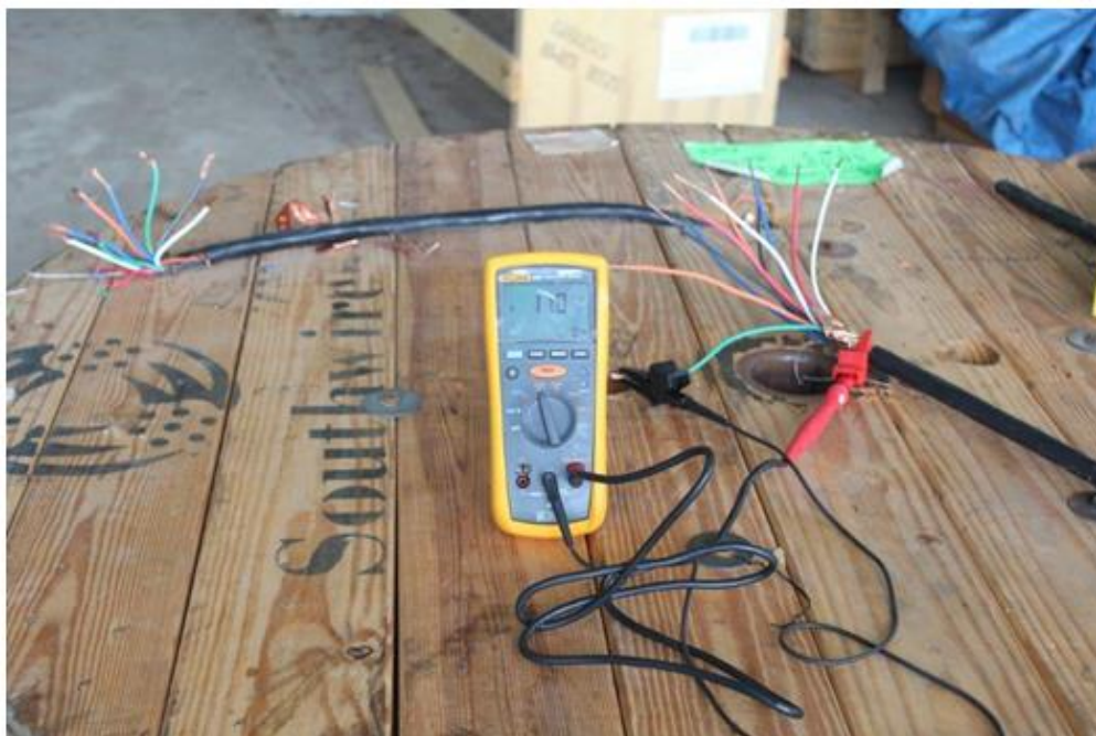
Prueba de aislamiento de los cables del seccionador 23T5, Bahía 6, Patio de 230 kV
