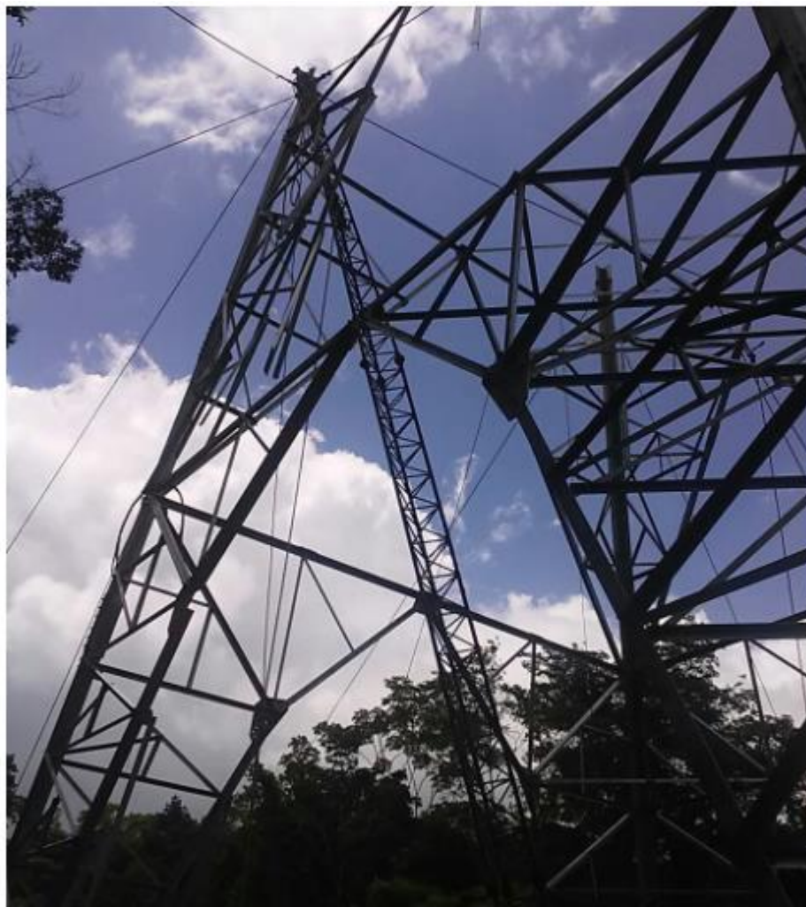
Ilustración 2 MONTAJE D LA TORRE 117
