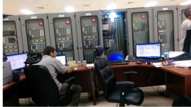
Ajustes configuración de los relés de protección
