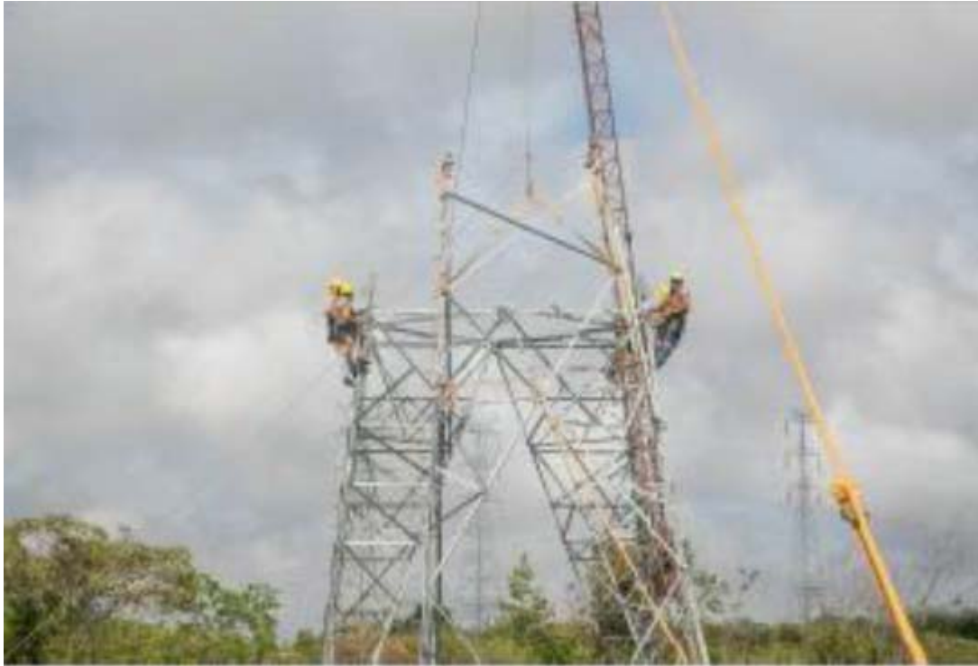
Montaje – Torre 287 (TXS2)
