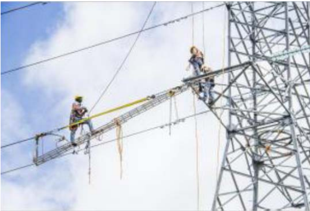
Actividad de Tendido – Tramo 2
