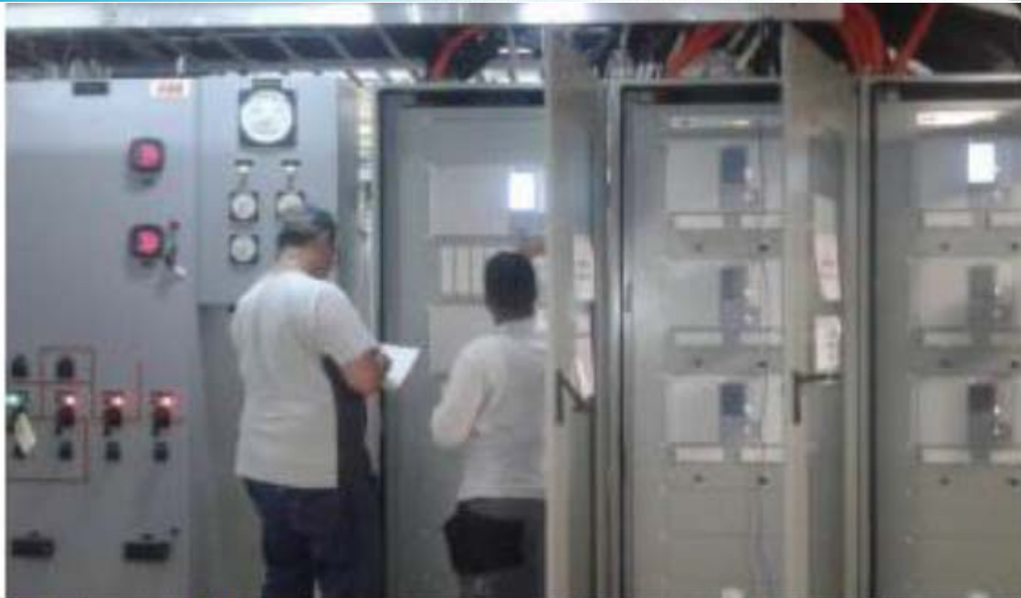
Pruebas de Bloqueo y Diferencial de Barra B - SE Chorrera
