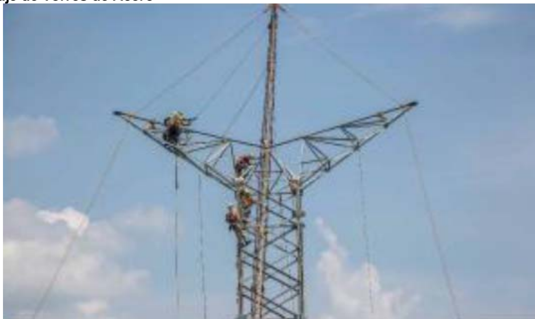
Montaje - Torre 217 (TXAT)
