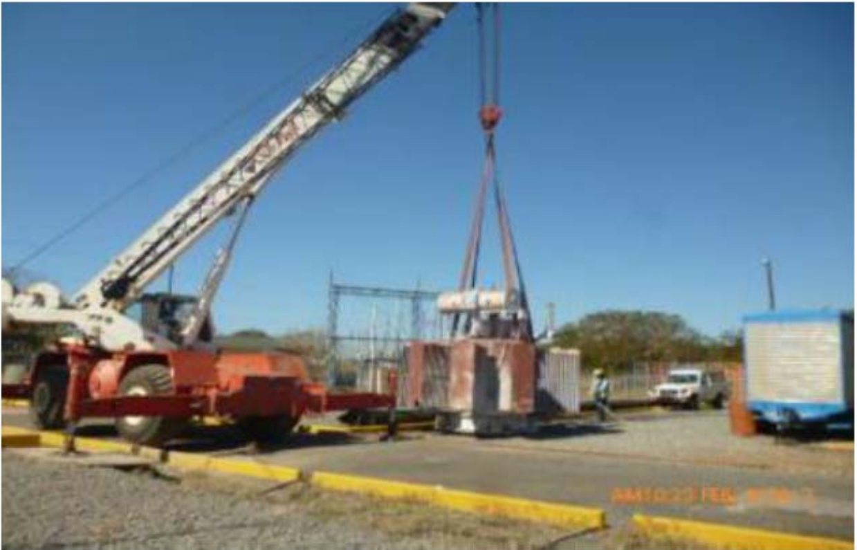
Remoción del Reactor R2 existente.
