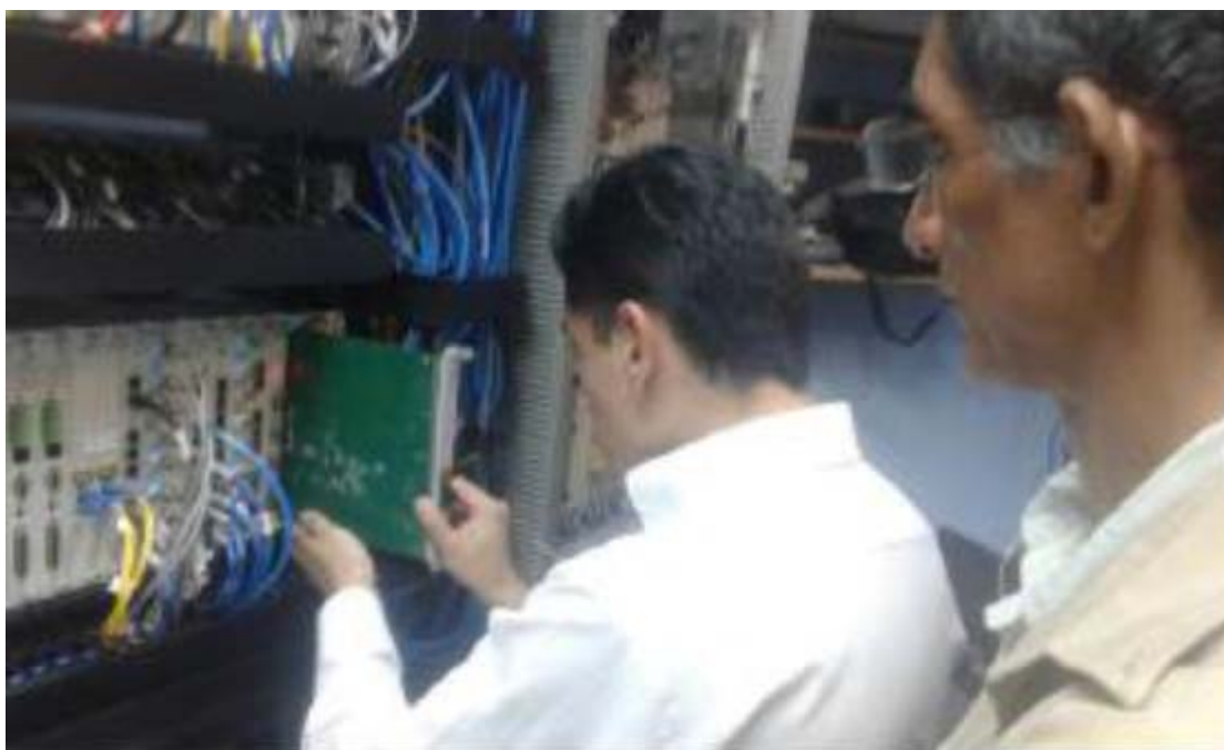
Instalación de Tarjeta de comunicación - SE Panamá
