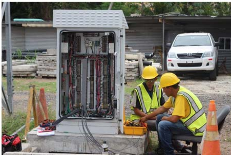
Pruebas de continuidad de los cables en la caja de centralización CCN13, Bahía 6, Patio de 230 kV
