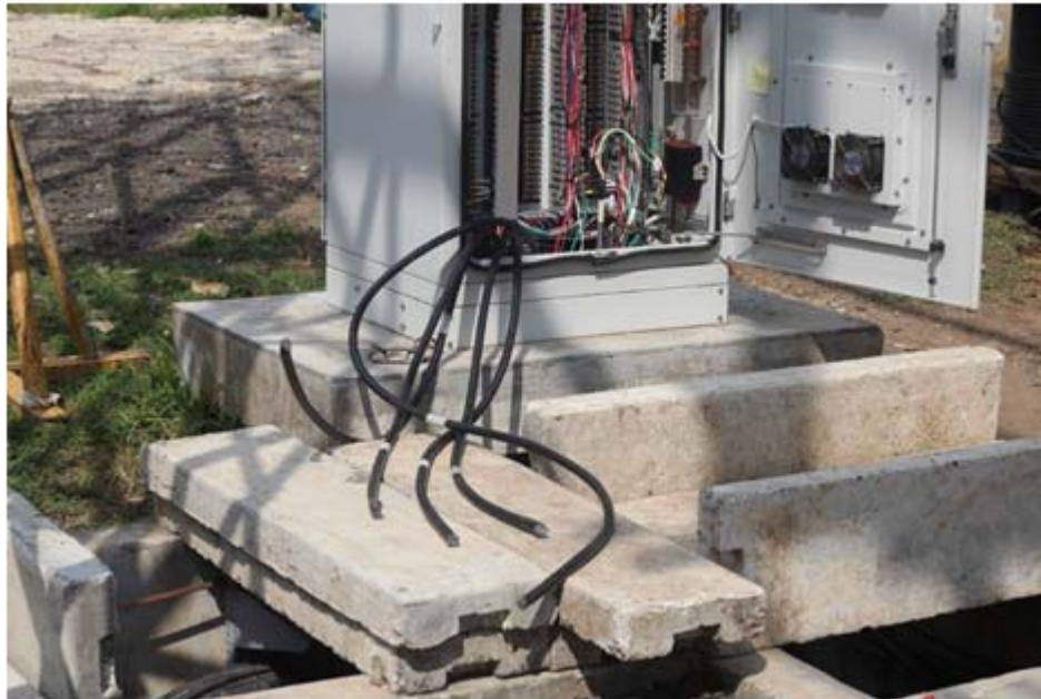
Tendido de cables de control entre shelter de 230 kV y caja de centralización CCN13, Bahía 6, Patio de 230 kV
