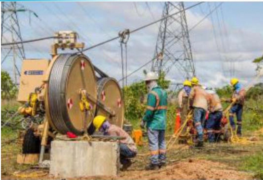
Actividad de Tendido – Tramo 2
