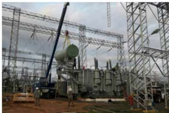
Montaje de los accesorios del nuevo autotransformador T2 en SE Chorrera
