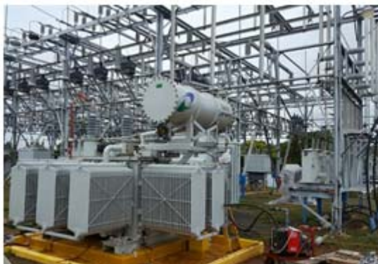
Montaje de los accesorios del transformador de Tierra TT2 en SE Chorrera
