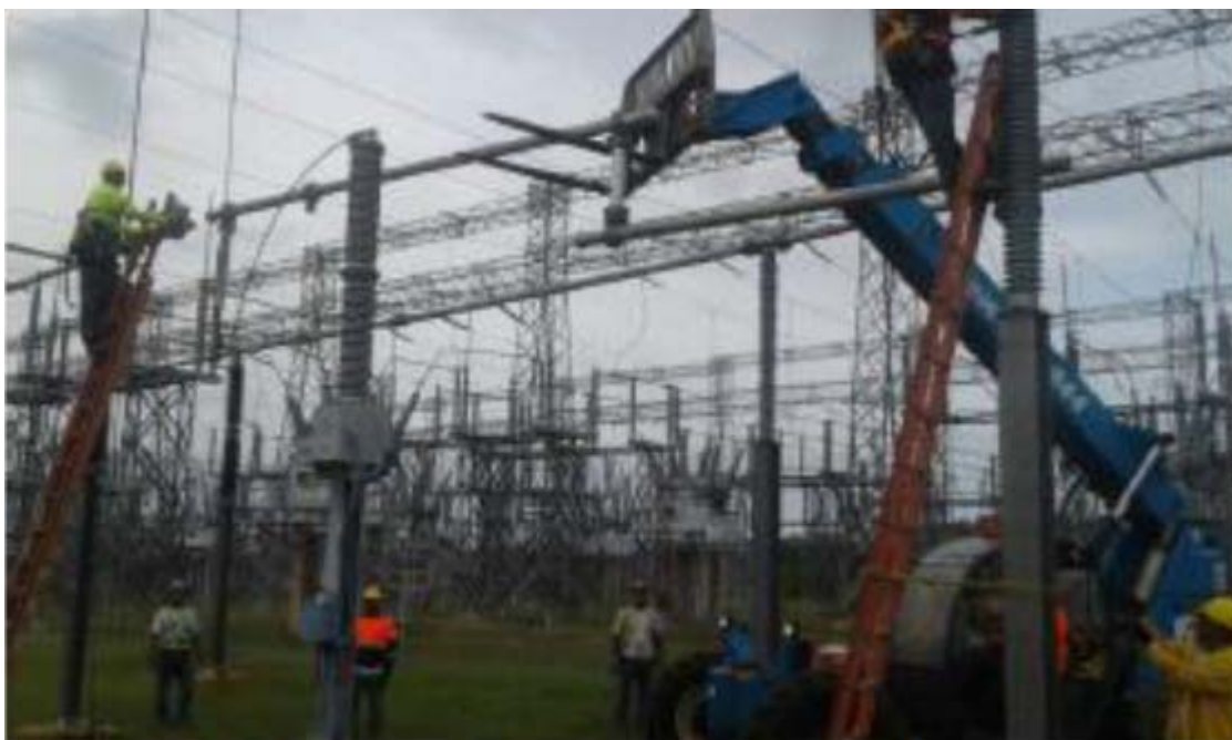
Instalación Barra B Fase B – SE Chorrera
