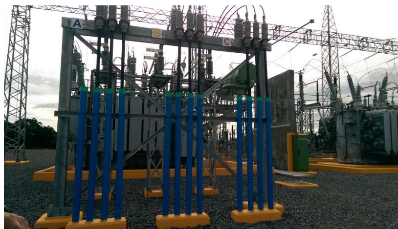
Vista del transformador T2 energizado
