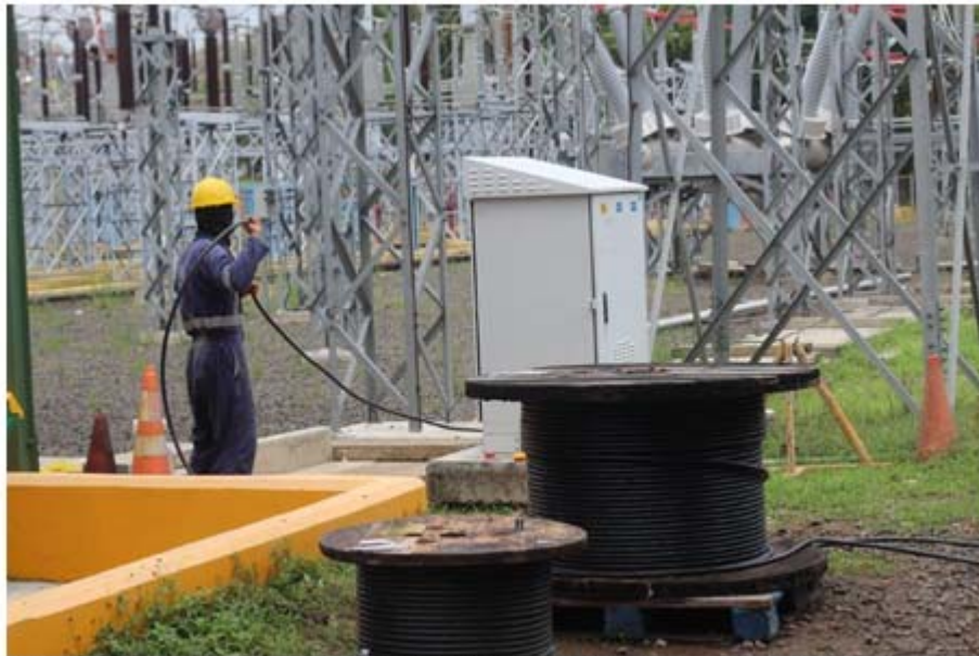
Tendido de cables entre la caja de centralización CCN10 de la bahía 7 de 115 Kv y el shelter
