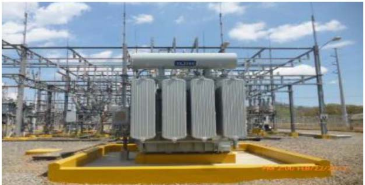
Reactor R2 energizado.
