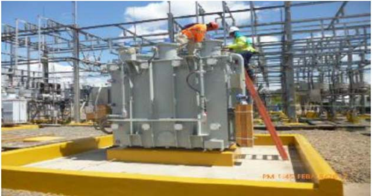
Montaje del nuevo reactor R2.
