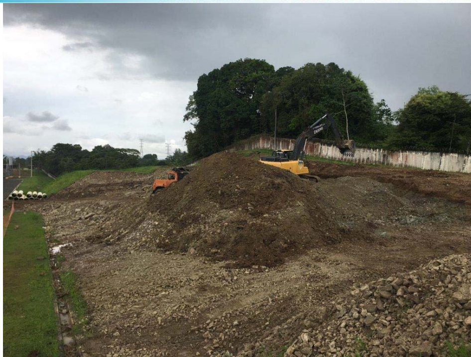
Avance de los trabajos de excavación en el área de la plataforma A – S/E Panamá 2
