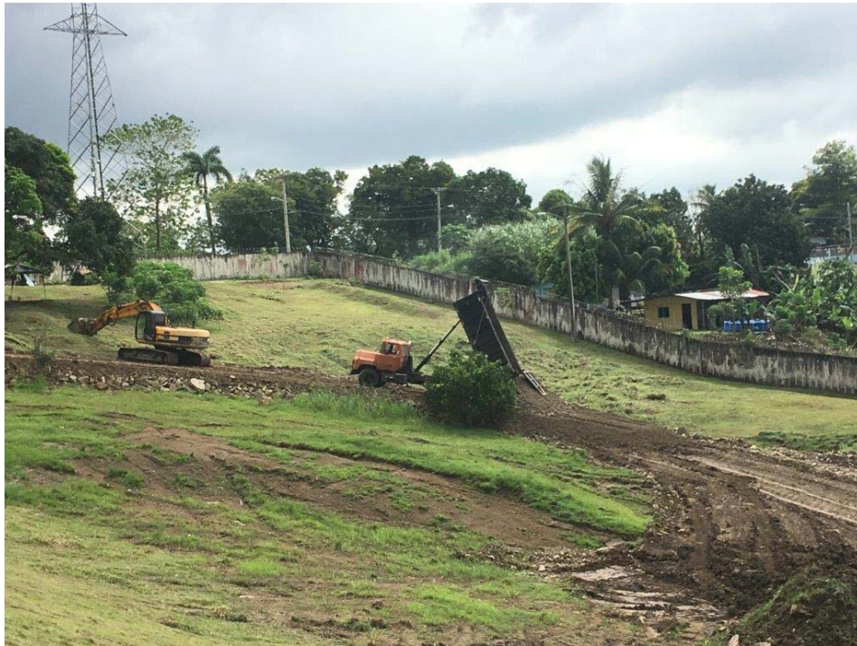
Avance de los trabajos de conformación del camino de acceso al área de la plataforma C – S/E Panamá 2
