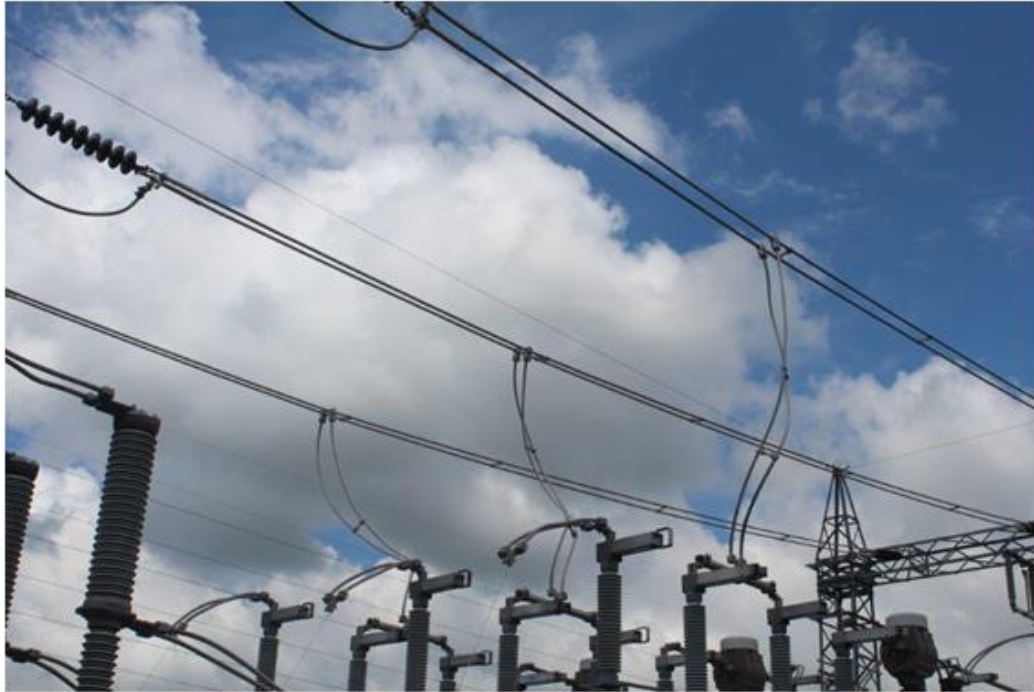
Cambio de herrajes, conductores y aisladores de la barra aérea, en lado de la Barra A de Bahía 7, Patio de 115 kV
