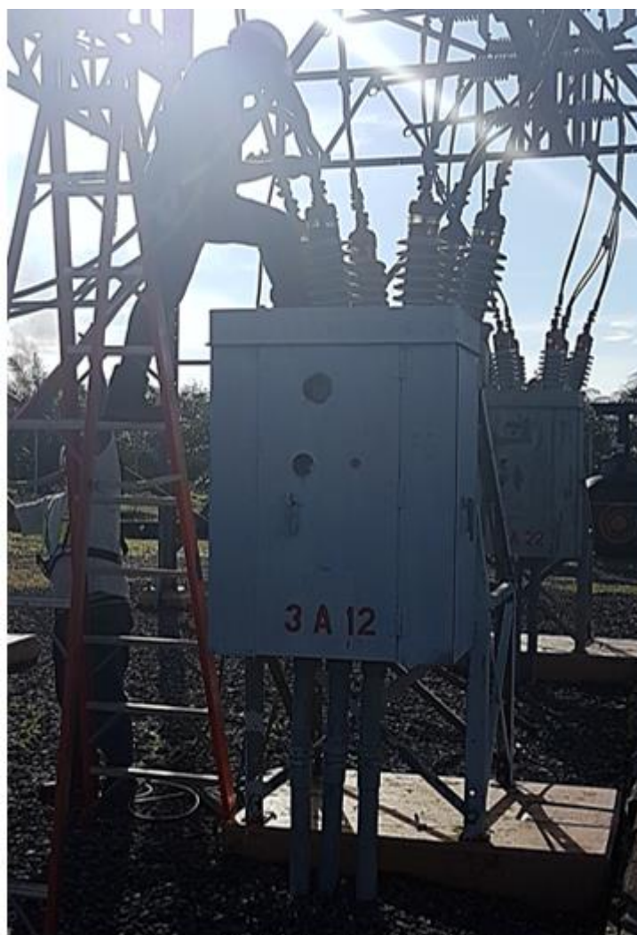
Desconexión de Interruptor 3A12 existente.
