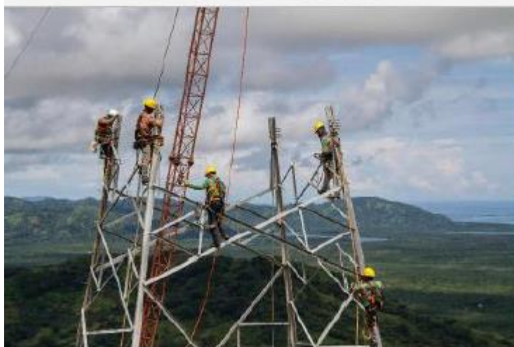
Montaje - Torre 216 (TXAT)
