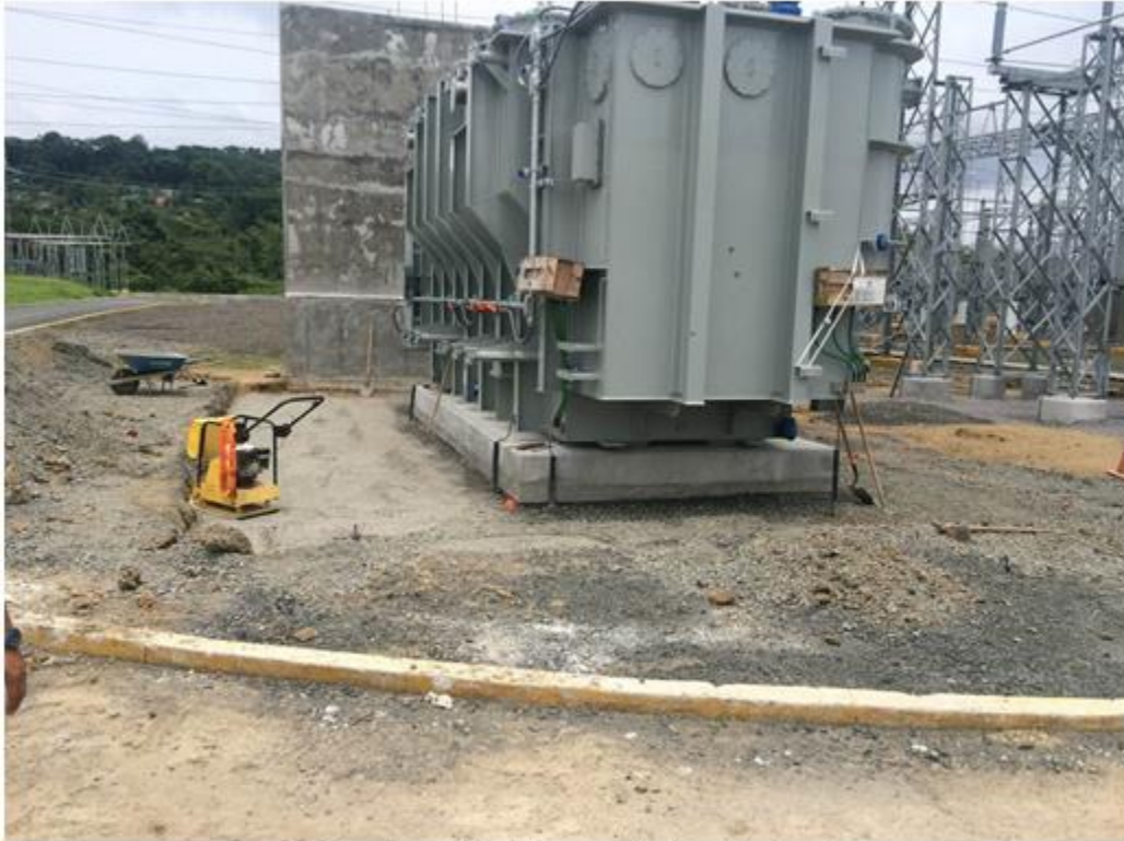
Contrucción de la tina recolectora de Aceite
