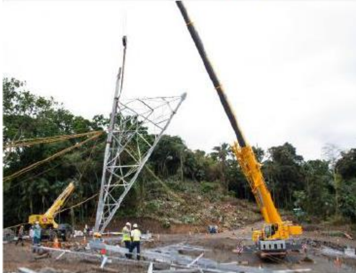
Montaje - Torre 39 (TXE2)
