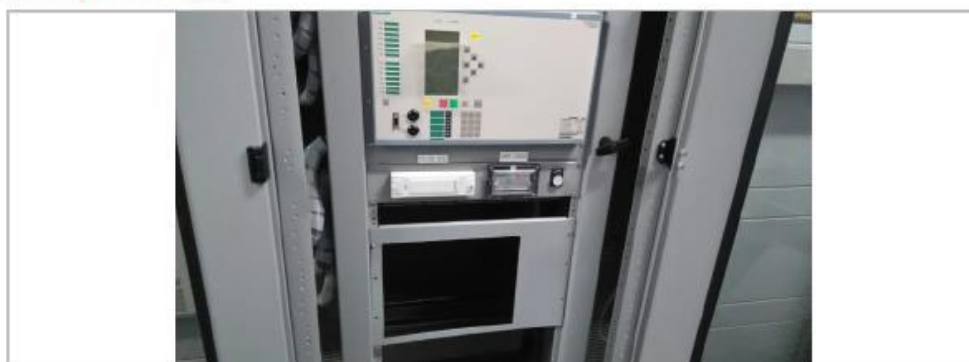
Montaje de Equipos de Protección y Control de Tableros Existentes SE Panamá
