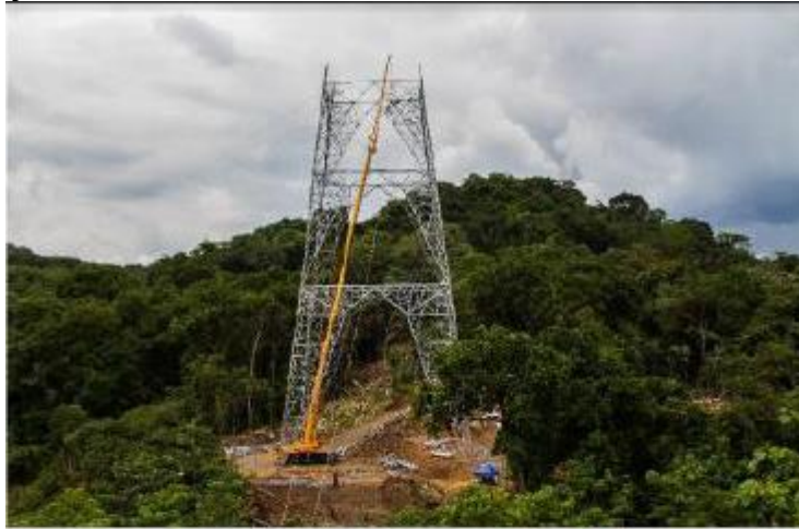
Montaje - Torre 38 (TXE1)
