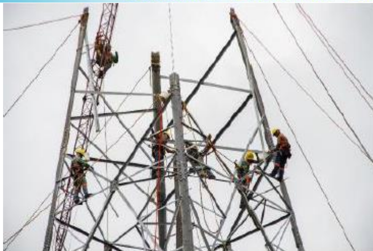
Montaje - Torre 40 (TXE2)
