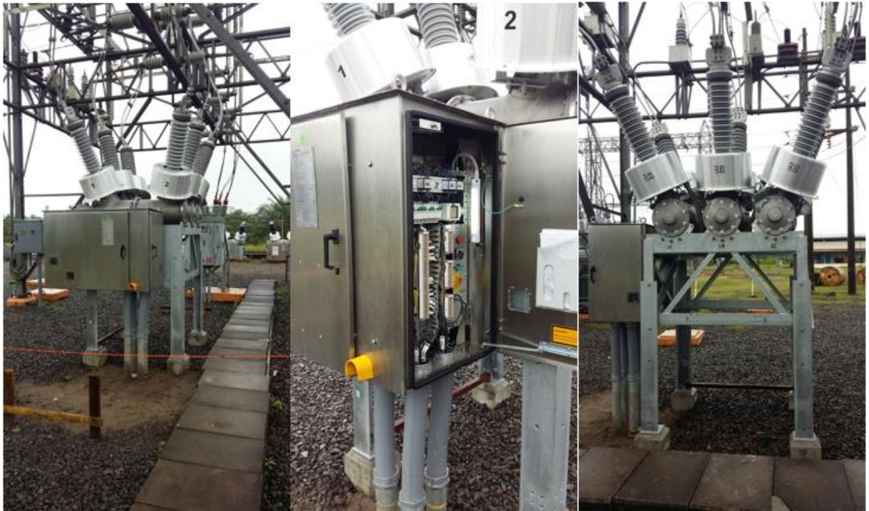
Nuevo interruptor 3A12 instalado.
