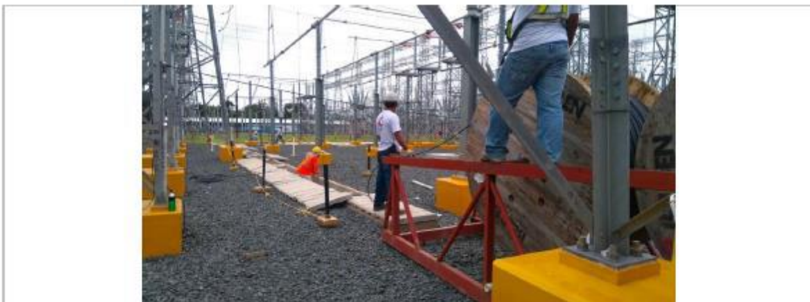
Tendido de Cables de Protección y Control de Patio a Casa Control – SE Chorrera
