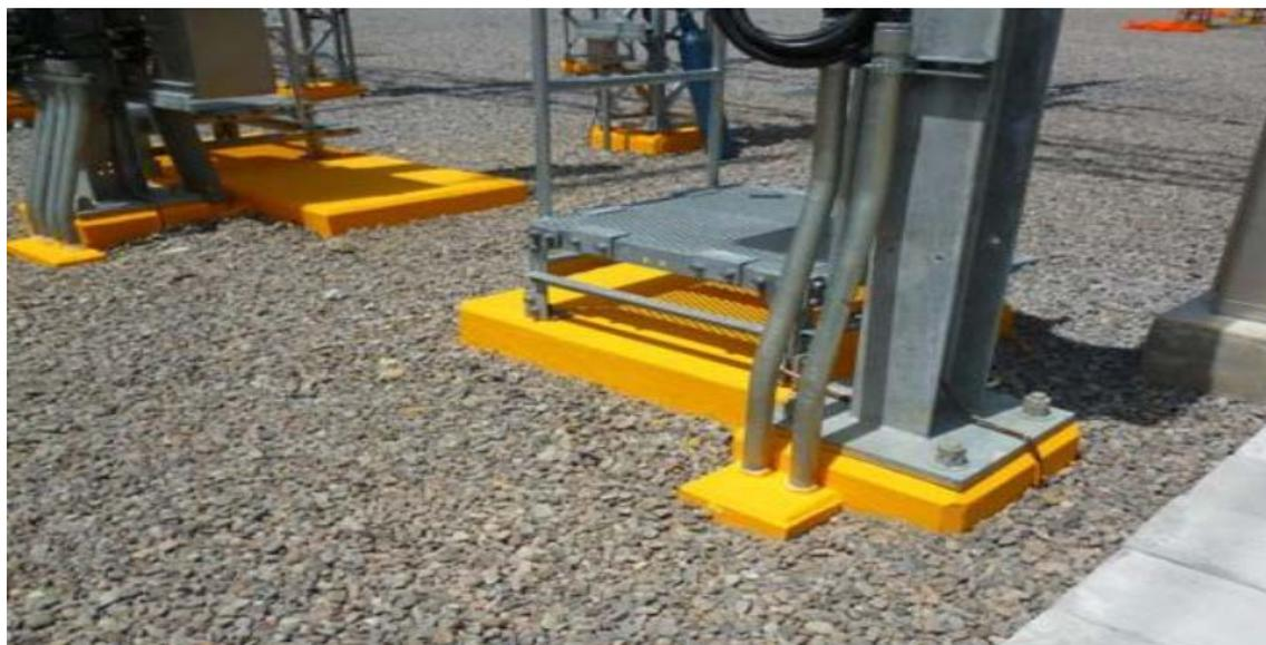
**Trabajos de acabado de pintura en las bases de los equipos**
