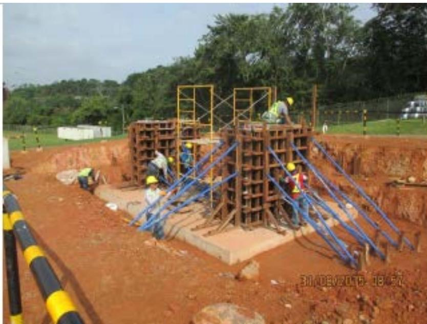
**Desencofrado de Pedestal de Pórtico**
