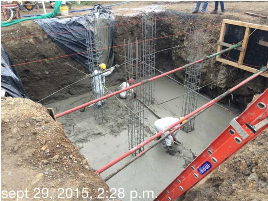
Vaciado de la zapata de la torre de pórtico 4M
