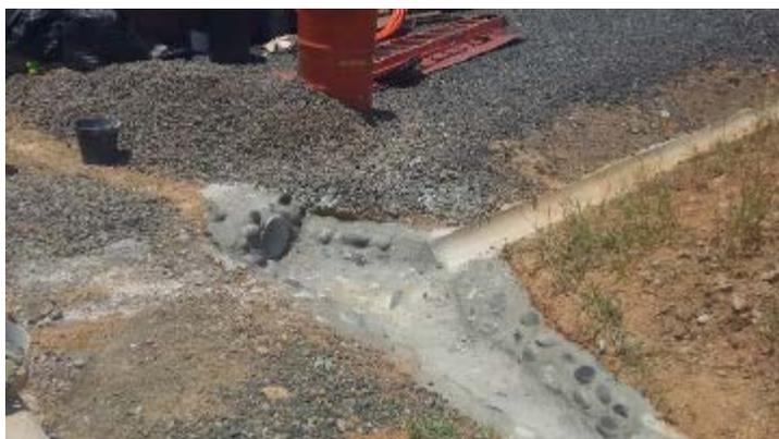
**Reparación descarga a media caña para el control del agua**
