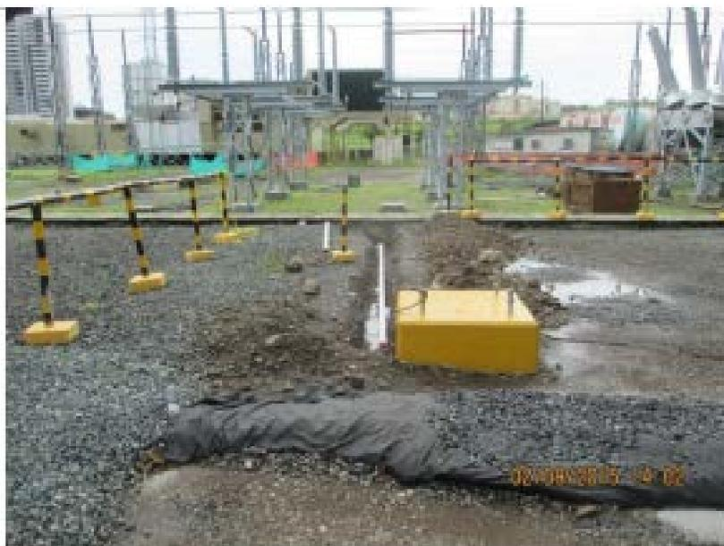
**Colocación de tubería desde Seccionadoras a Canaletas**
