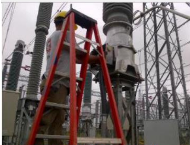
Conexión de TC - SE Veladero
