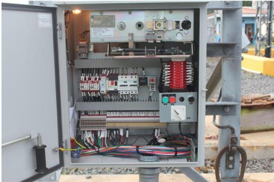
Pruebas de operación seccionador operado a motor 11T5
