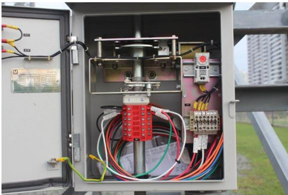
Verificación bloqueo de cuchilla puesta a tierra 11NT5
