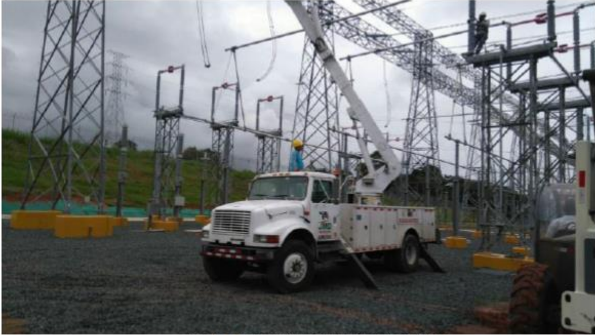
Pruebas de Comisionado para Seccionadoras
