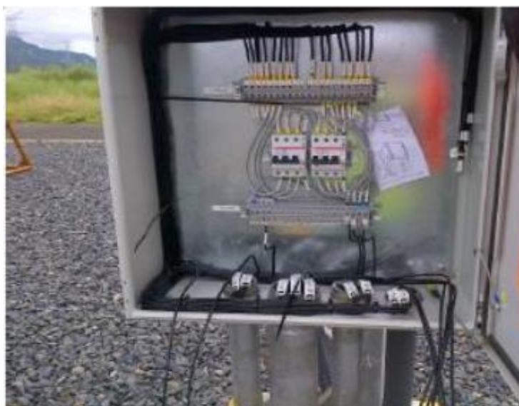
Conexión de Cajas de TP - SE Veladero
