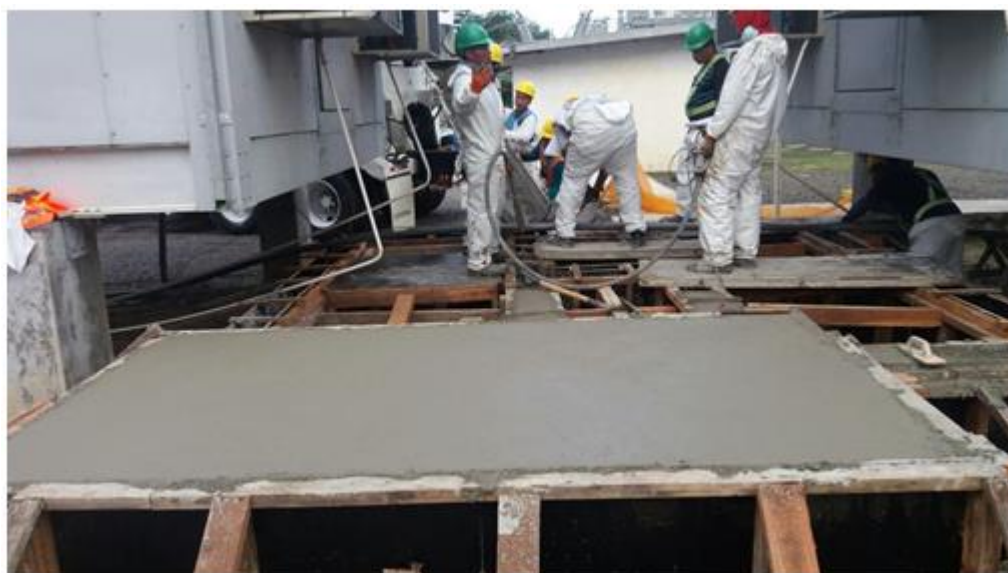
Vaciado de paredes de la Cámara de Mantenimiento # 2
