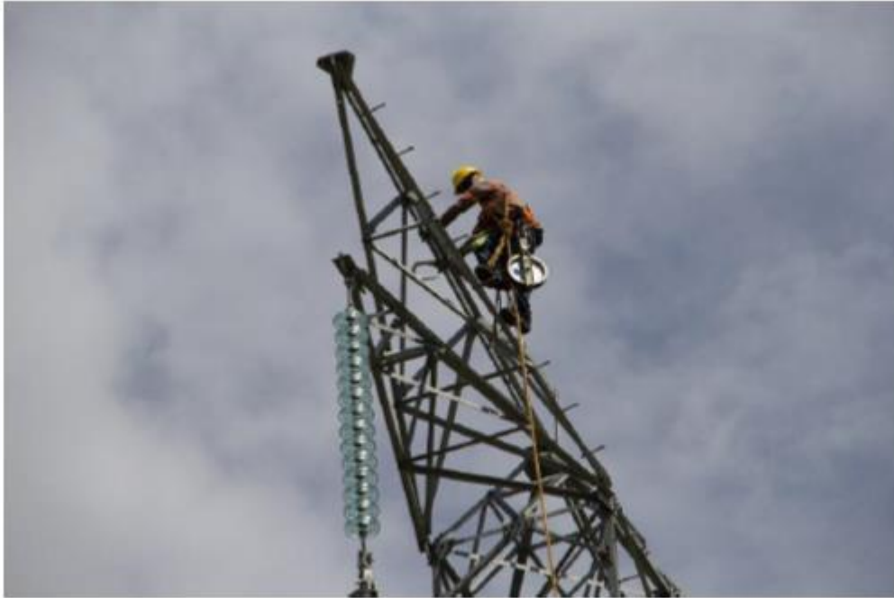
Actividad de Tendido – Tramo 2
