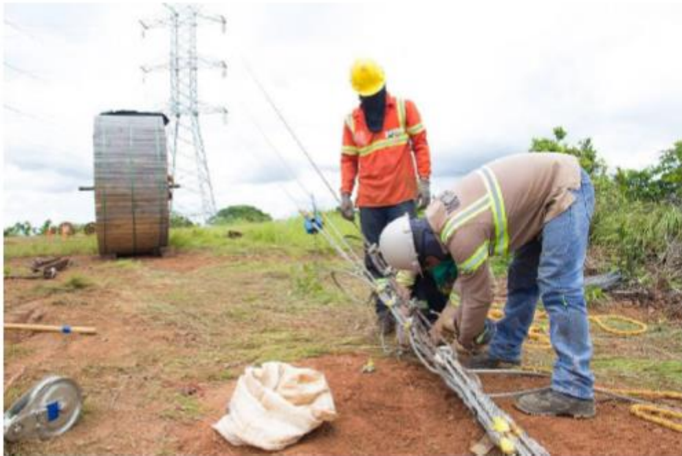
Actividad de Tendido – Tramo 2
