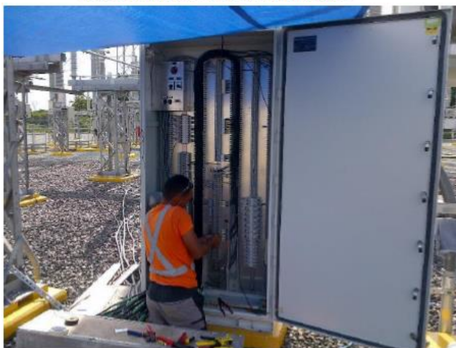
Cableado de Tableros para Servicios Auxiliares
