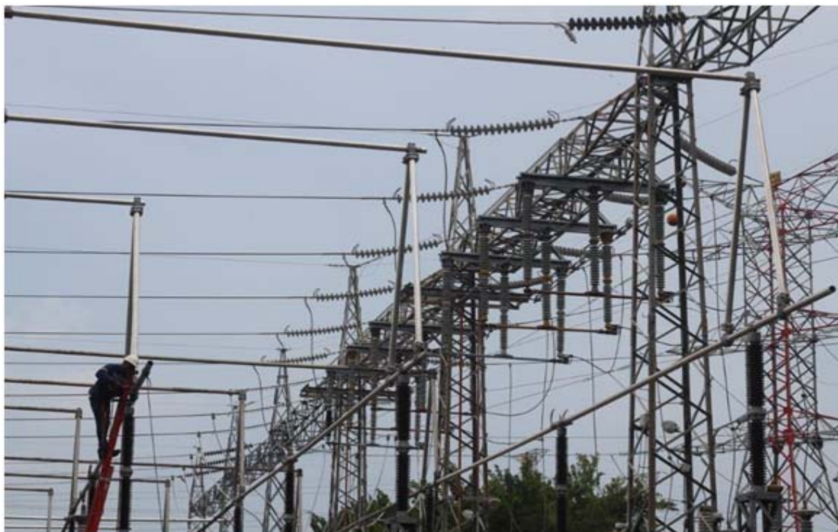
Trabajos de unión de la barra B a la Bahía 6 del Patio de 230 kV
