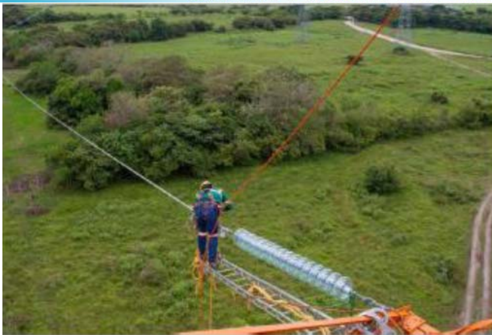
Instalación de aisladores – Tramo 2
