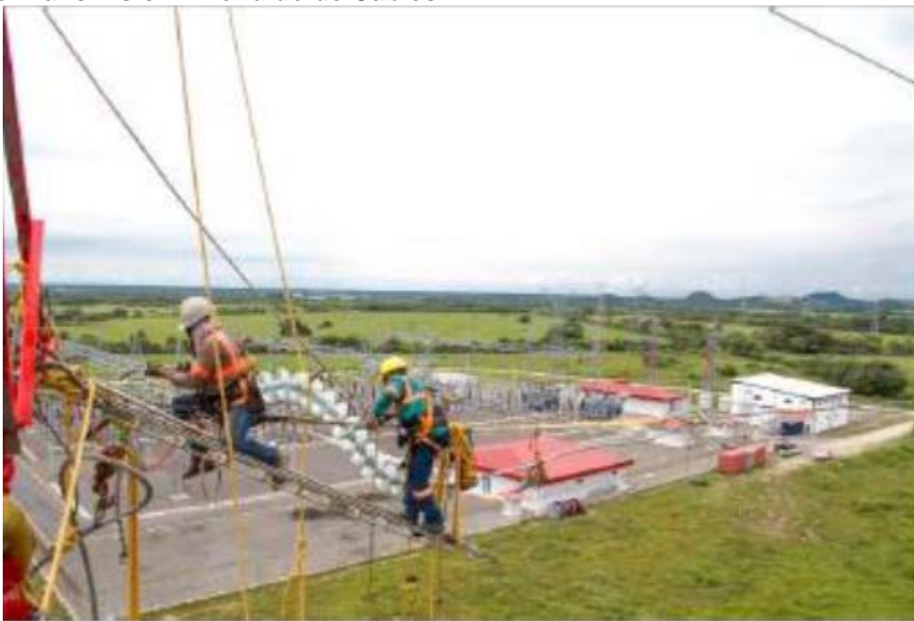
Instalación de aisladores – Tramo 2
