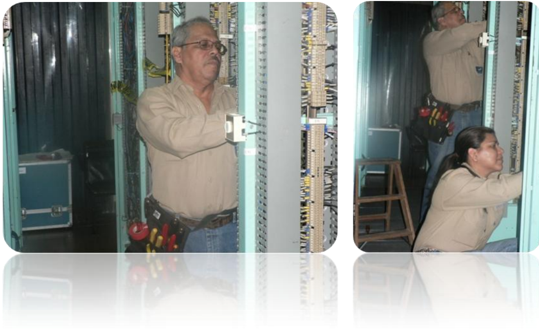
Personal de Protecciones Realizando Trabajos de Instalación
