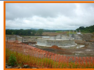
Presa El Corro – gira agosto 2010.
