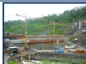
Vista del sitio presa de la CH Changuinola – gira agosto 2010.
