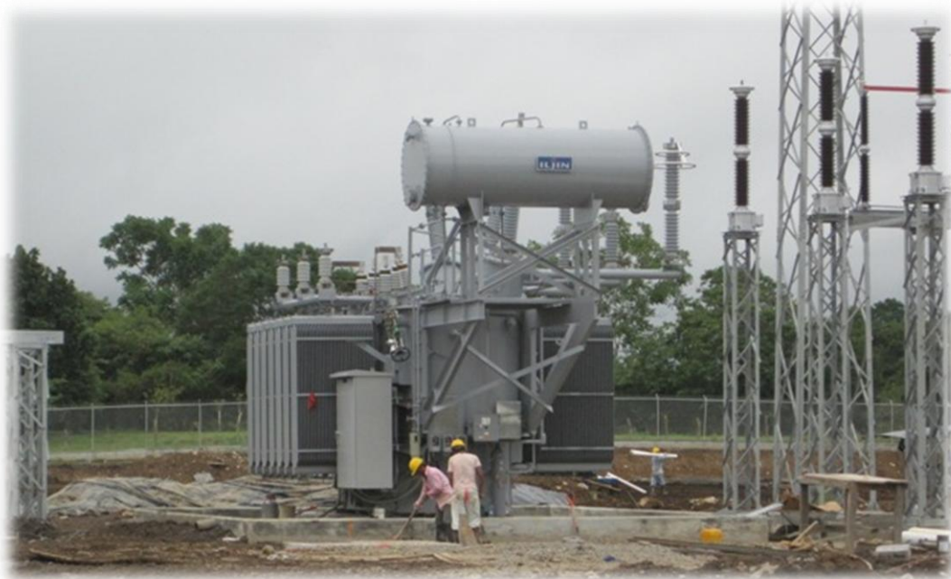
Montaje de Transformador de 83MVA Subestación Boquerón 3
