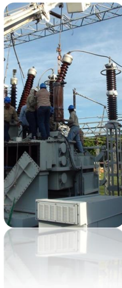
Personal de la GOM realizando trabajos de mantenimiento a los transformadores de las subestaciones a nivel nacional
